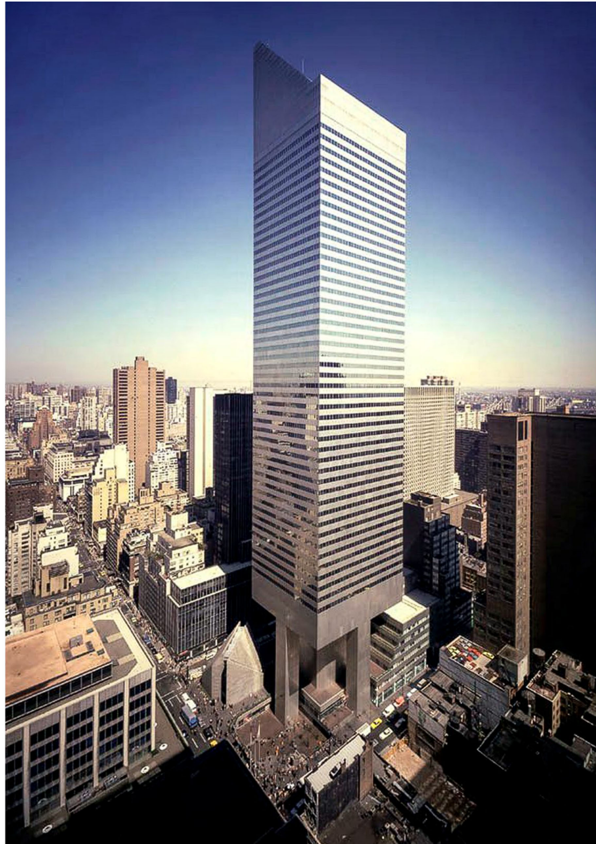
Figura 5. Visión de conjunto del Centro Citicorp. La fachada posee los vidrios de las ventanas y las enjutas de aluminio en el mismo plano, lo que abarató el coste de construcción y mantenimiento respecto a si se hubiera preferido mostrar el sistema estructural. Stubbins quiso dotar de funcionalidad a la cubierta, proyectándola como un gran captador solar, lo que justificaba su inclinación.
