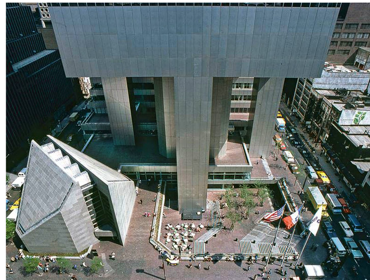
Figura 4. Relación de la base de la torre Citicorp con el espacio público de la plaza hundida y la iglesia luterana de San Pedro. La ciudad se introduce en el edificio, como una invitación al viandante a adentrarse en él.
