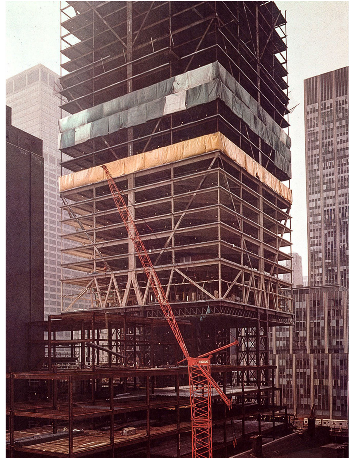
Figura 9. Vista en escorzo desde el este de la torre en construcción (1975). A primera vista, lo más llamativo de la estructura del Centro Citicorp, son los masivos pilares «mástil» centrales (de más de 1'5 metros de ancho) y las diagonales extendiéndose a través de las plantas. Si miramos nuevamente, llama la atención la esbeltez de los pilares de las esquinas en el alzado estructural y su interrupción en la octava planta de cada módulo. Todos los elementos del perímetro estructural, a excepción de los soportes centrales, trabajan sólo en las ocho plantas del módulo estructural que definen los chevrones invertidos de acero, canalizando todas las cargas gravitatorias a los pilares centrales.
