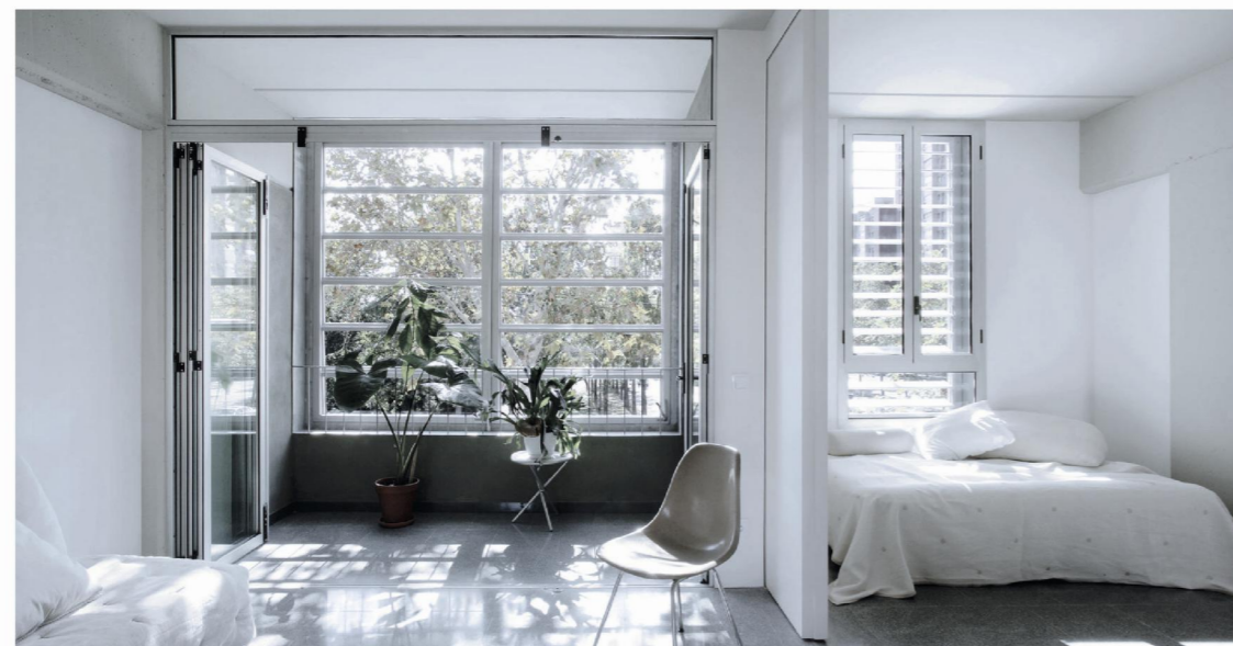
> [Fig. 30] Emiliano López y Mónica Rivera (2007). Viviendas para jóvenes en Sant Andreu . Fotografía de Hevia, J. Las diferentes capas que conforman la galería permiten una transición fluida entre el interior y el exterior. La practicabilidad de las ventanas abatibles permite que la galería guarde calor en invierno por el efecto invernadero y aislar del ruido de la calle. Fuente: https://www.plataformaarquitectura.cl
