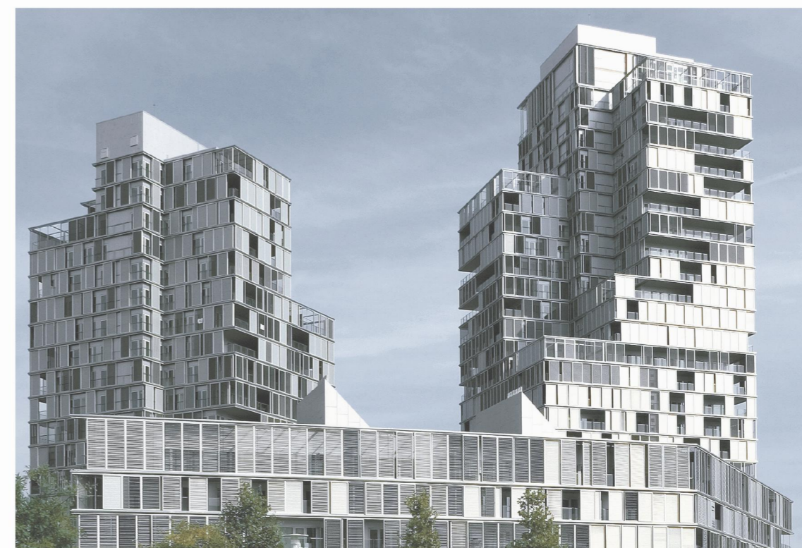
[Fig. 22] Clotet&Paricio (2021). Dos torres en Diagonal Mar, Barcelona . Fotografía de Casals, L. Los espacios de relación exterior rodean el perímetro del edificio y se convierten en el organizador de la distribución de las viviendas. Las terrazas se diseñan con una amplia superficie que permite la comunicación entre las habitaciones. Las persianas correderas de aluminio protegen del viento, el sol, y sirven de filtro contra el ruido y el clima. Fuente: https://arquitecturaviva.com
