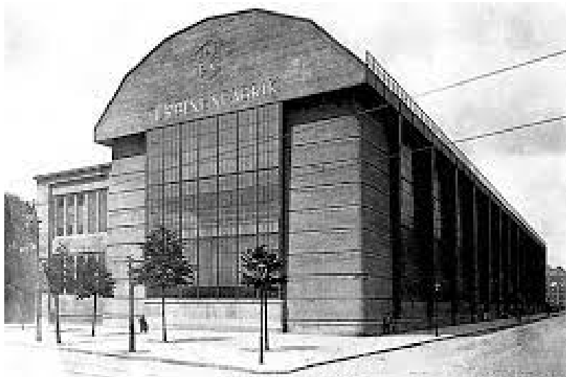
Peter Behrens, AEG-Turbinenhalle, Berlín, 1910; fachada. Fuente: www.bauhauskooperation.de
