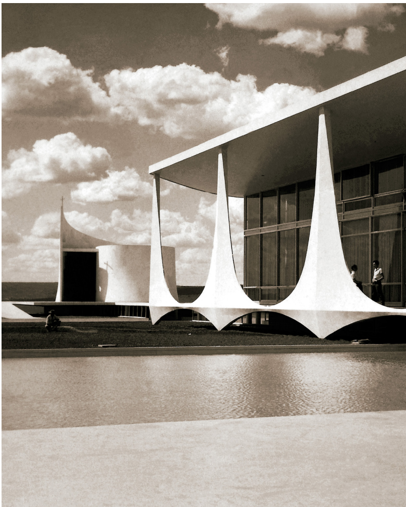
Oscar Niemeyer, Palácio de la Alvorada, Brasília, 1956-1957; pilares de sección variable. Fuente: AV Monografías, 125, 2007.
