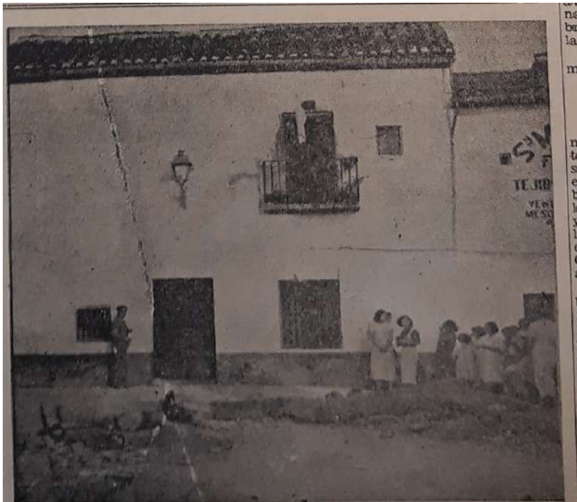
Esta casa fué el blanco de los tres disparos del cañón de Infantería que actuó para pacificar la resistencia del Albayzín. Aunque exteriormente no se aprecian sino disparos de fusil, el interior tiene grandes destrozos producidos por el estallido de los obuses, dos de los cuales atravesaron la puerta y uno la ventana. Frente a la casa existen restos de una barricada y en el balcón ondea, ahora, una bandera blanca.
