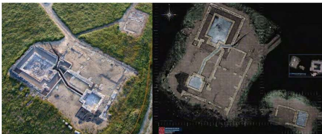
Fig. 75: Fotografía aérea y ortomosaico a partir de modelo fotogramétrico de las termas públicas de Turobriga (Bermejo 2010, 456-457)
