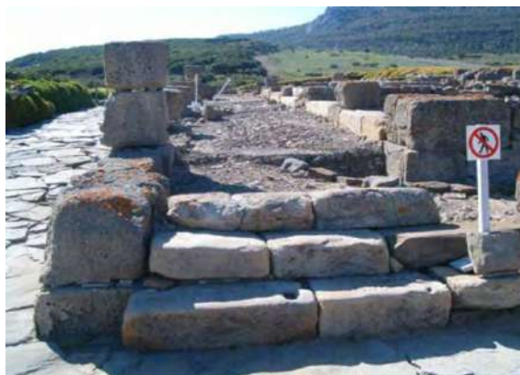
Fig. 85: Remodelación de finales del siglo III mediante la cual la porticus se transforma en espacio cerrado y se crece la cota de circulación mediante un nuevo pavimento y unas escalinatas de acceso (Torrecilla 2007, 288).
