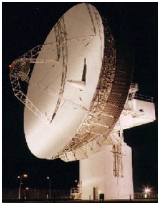
Figura 65. Estação construída pela GCHQ (Government Communications Headquarters - United Kingdom) em 1972 para fins de interceptação sinais de telecomunicações. Fonte: Duncan Campbell (1999), p.9
