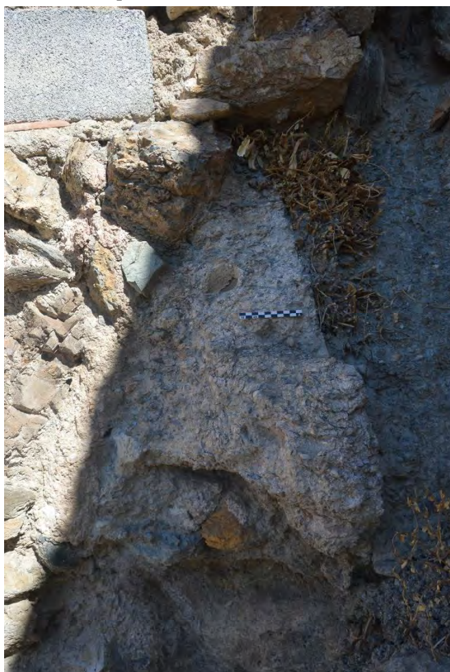
Figura 5.11. 4: Restos de mortero -UE 20- equivalente al del tapial de calicanto al que se le apoya
