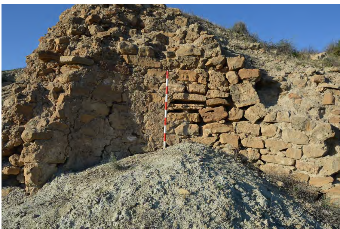
Figura 5.12. 5: Restos de la cara interna de la UE 49.
