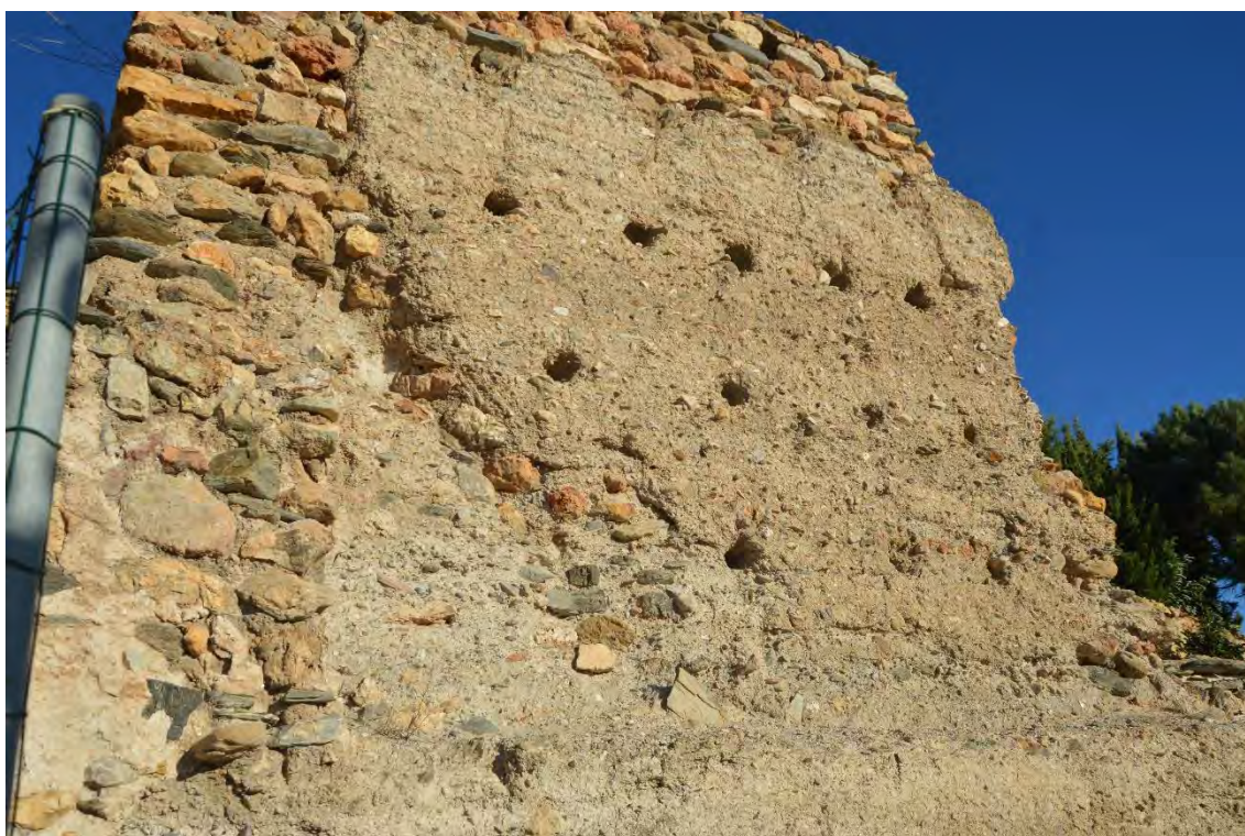
Figura 5.11. 3: Cara oeste de la torre CE 03.
