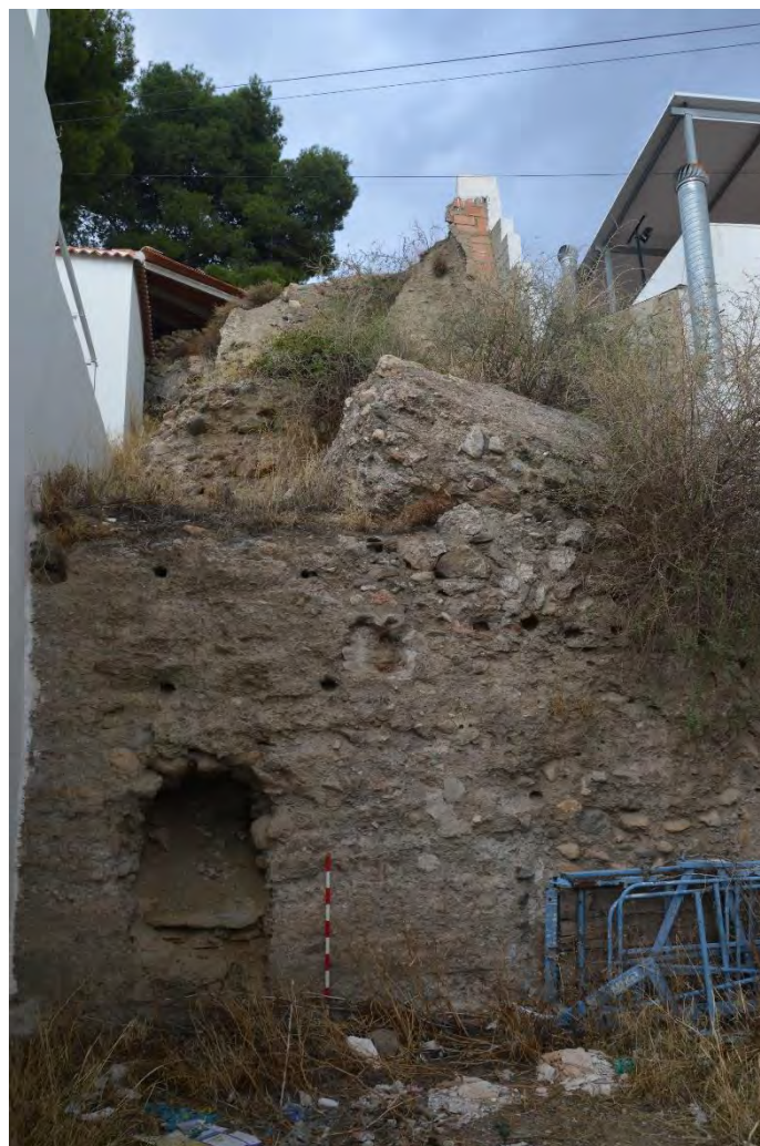
Figura 5.11. 3: Frontal de la torre CE 02.
