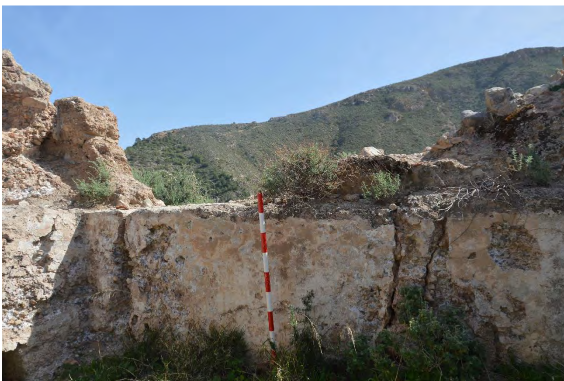
Figura 5.14. 10: E 09 del aljibe interno.
