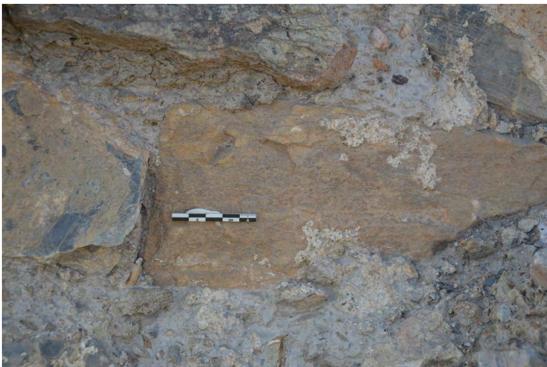
Figura 5.7. 12: Restos de enlucido de cal de la UE 18.
