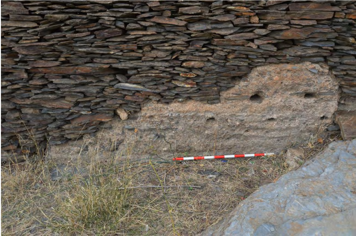
Figura. 5.13. 18: Cara Sur de la torre de tapial calicostrada -UE 15-.
