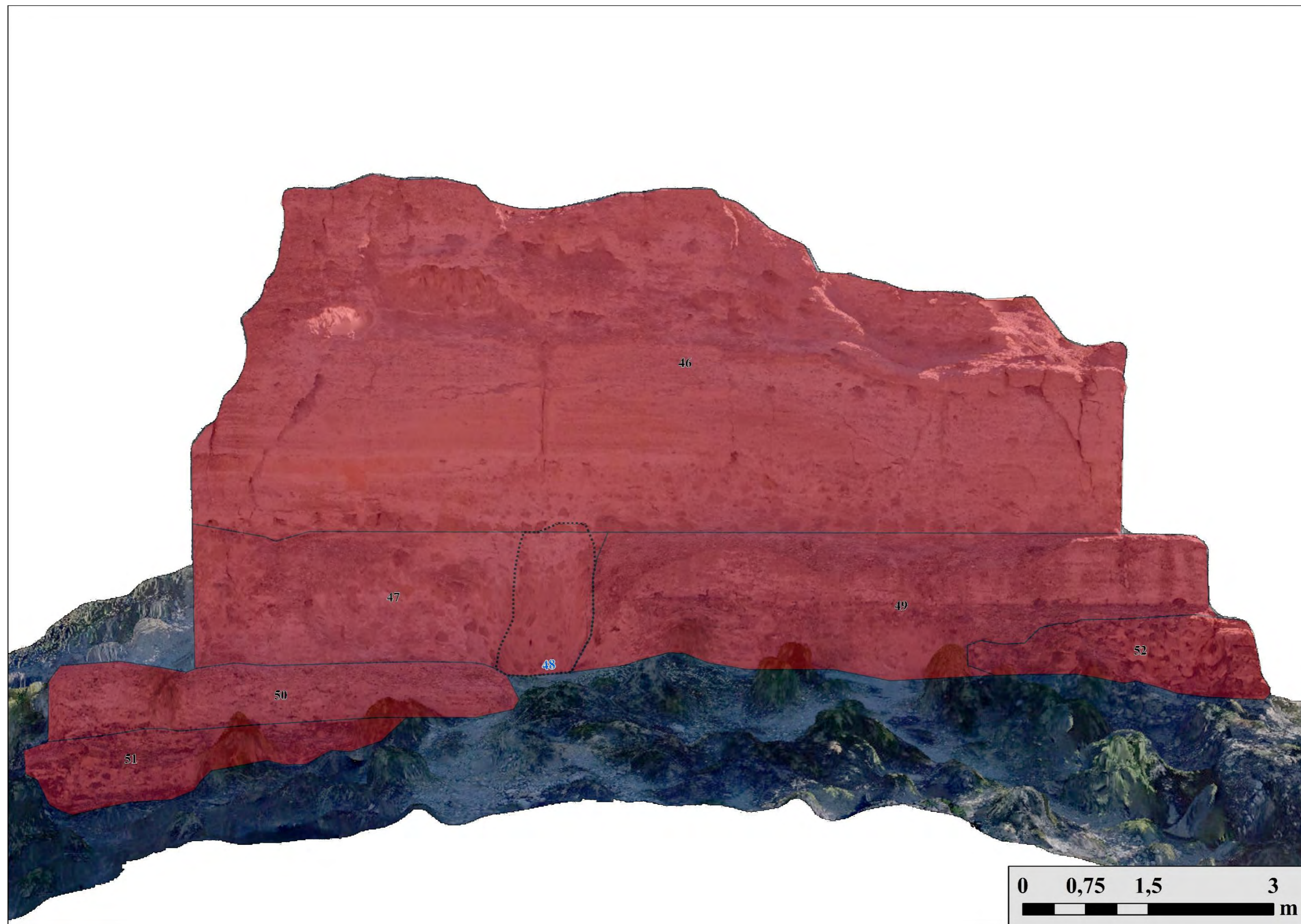
Figura 5.3. 32: Cara Norte de la torre principal.
