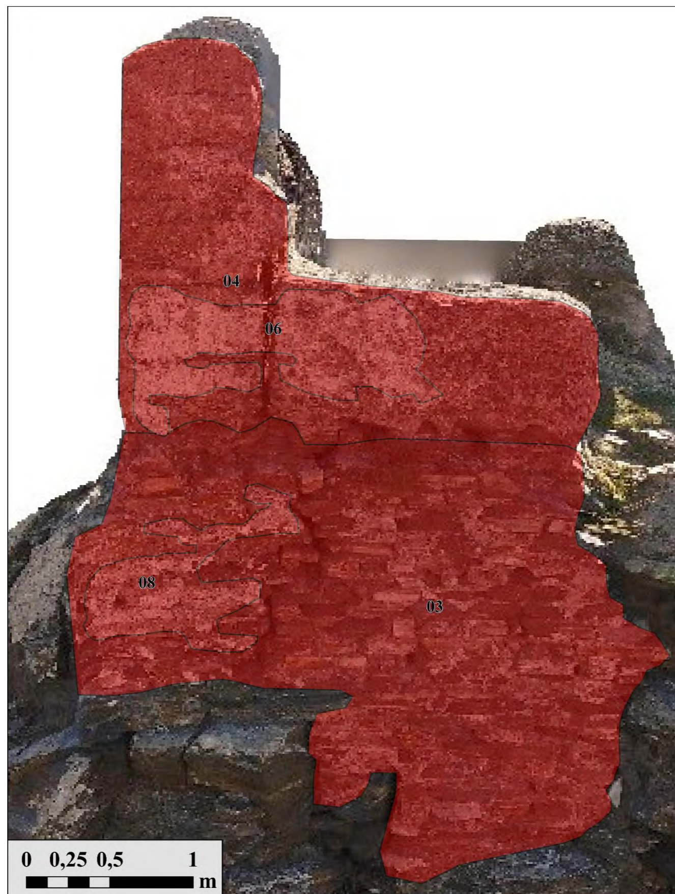
Figura 5.16 20: Alzado norte de la torre del recinto superior.
