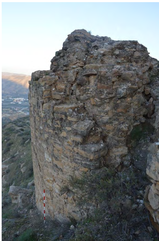
Figura 5.12. 17: Cara Sureste de la torre UE 62.
