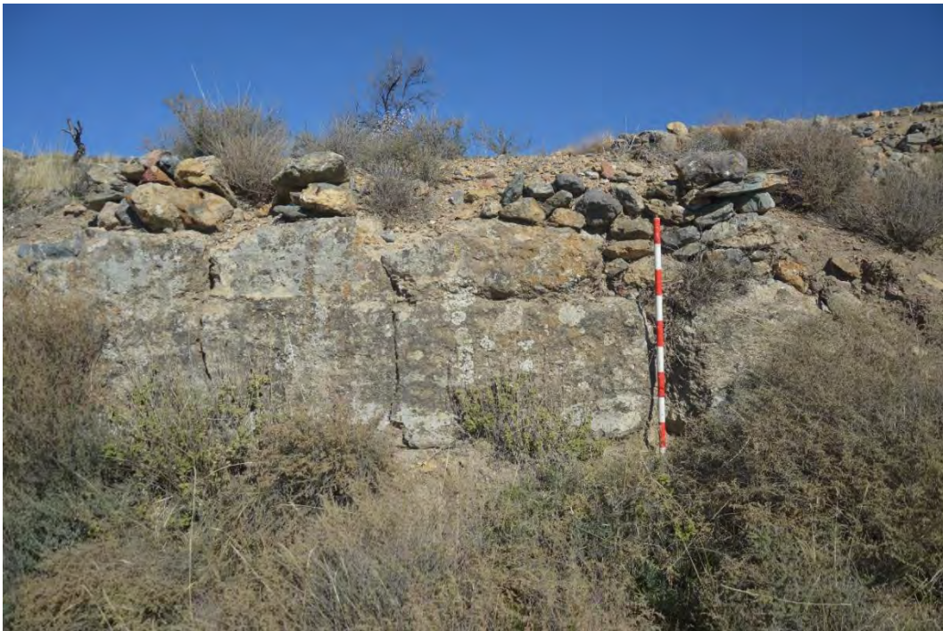
Figura 5.9. 14: Tapial hormigonado -UE 112-.
