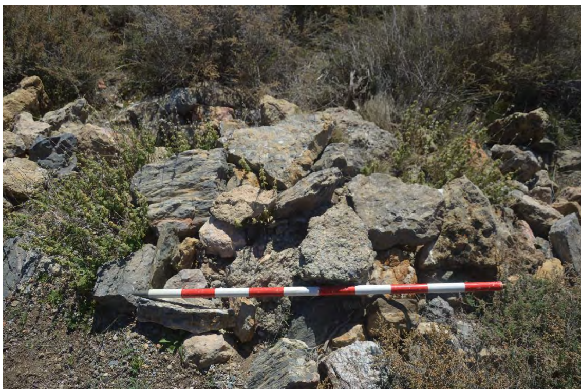
Figura 5.9. 9: Restos de tapial hormigonado.
