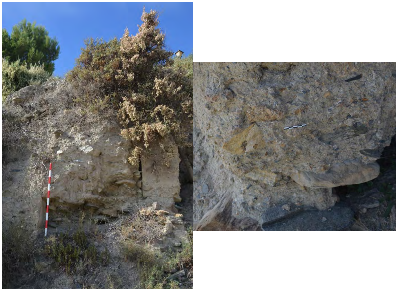
Figura 5.4. 2: Izq. Restos de la torre CE 01 -vista frontal-. Dcha. Mechinal y mortero de la UE 02
