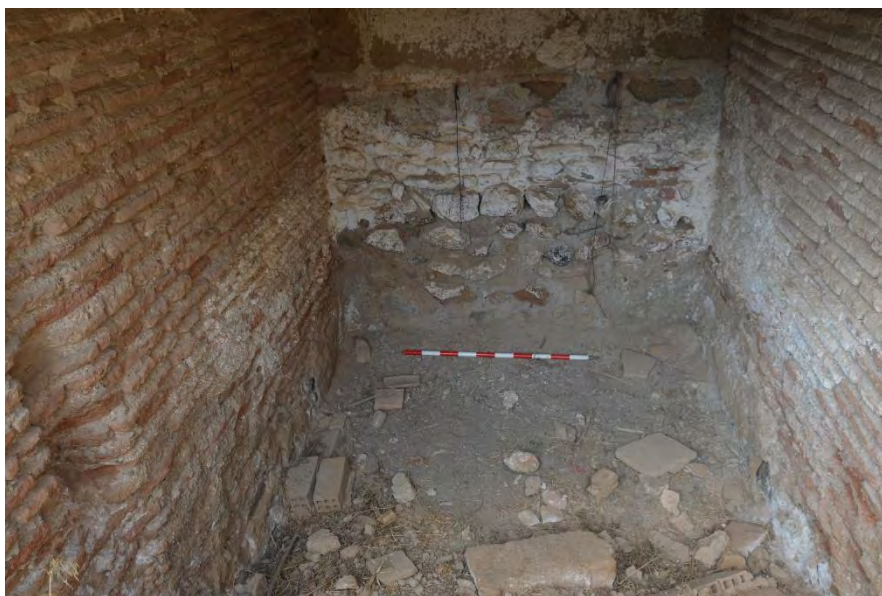
Figura 5.18. 9: Interior de la torre con la E 08 al fondo.
