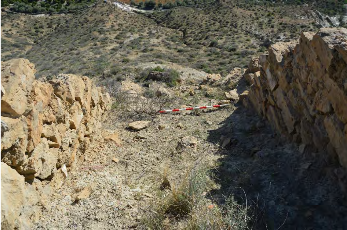
Figura 5.12. 35: Cierre Sur del CE 08, casi desaparecido -UE 66-.
