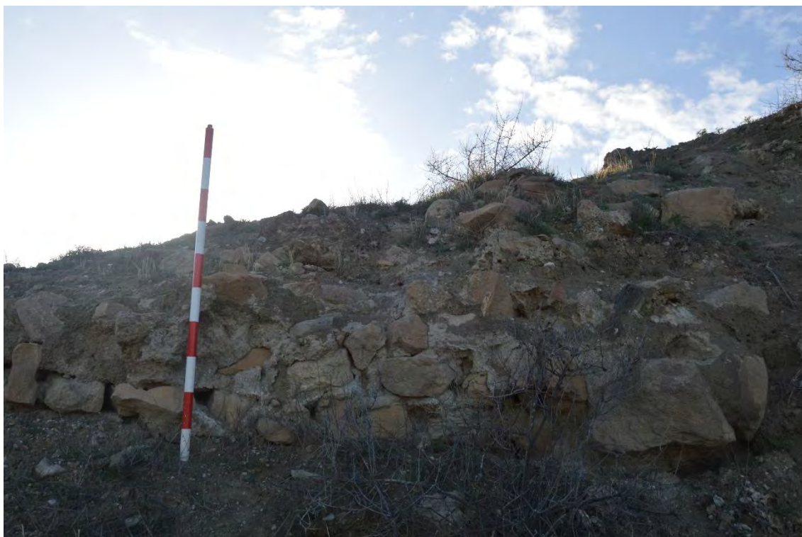
Figura 5.12. 33: Restos del zócalo de mampostería -UE 16- de la torre E 10.
