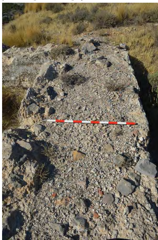
Figura 5.7. 14: Muro Este del aljibe -UEs 27 y 30-.
