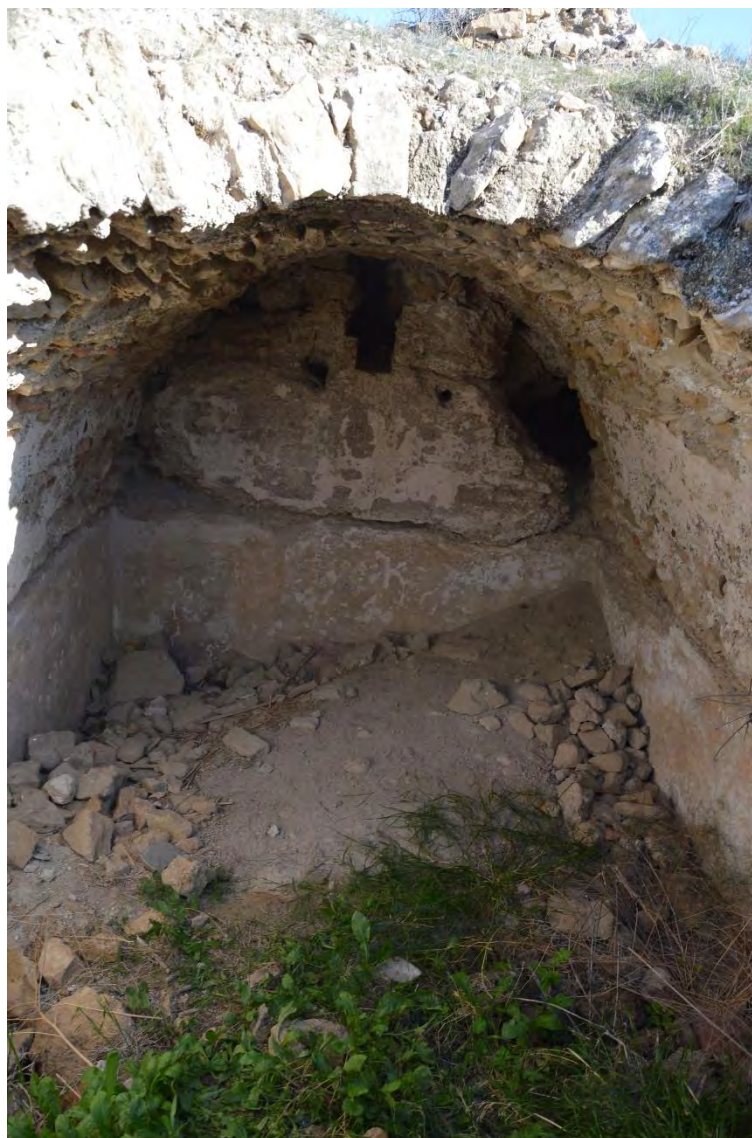
Figura 5.12. 13: Vista del aljibe CE 05 desde el Oeste.
