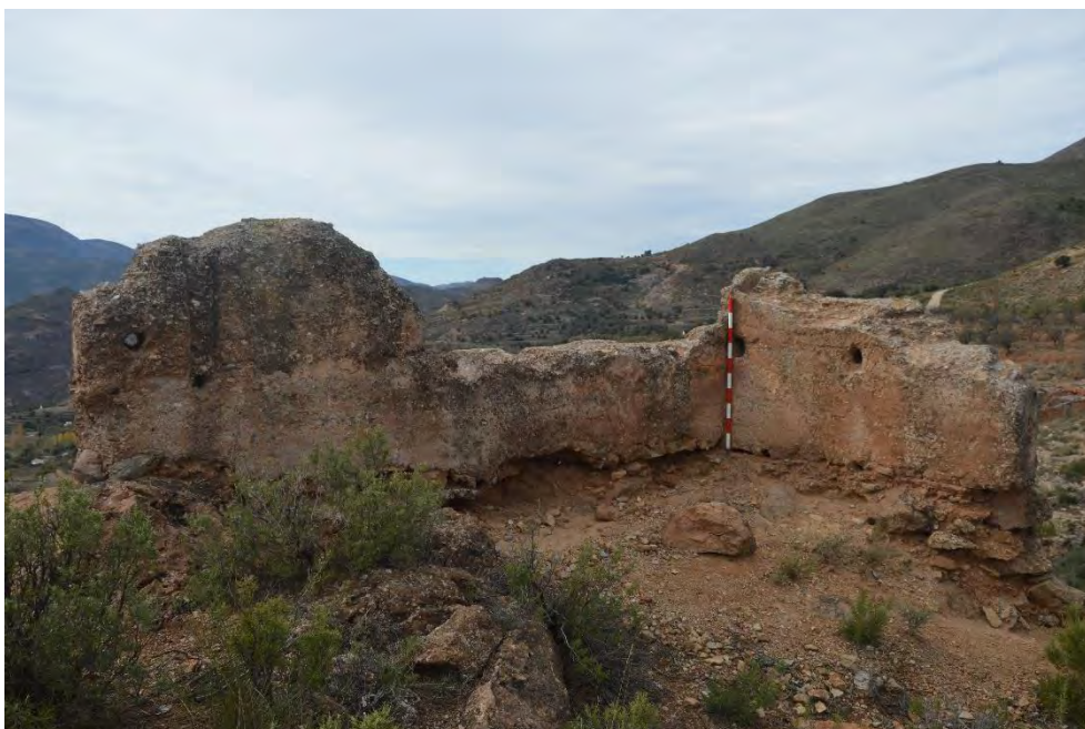
Figura 5.3. 3: Interior de la torre albarrana.
