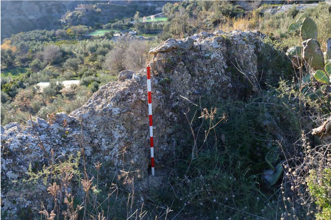
Figura 5.15. 6: Cara interna del tapial de la UE 10.
