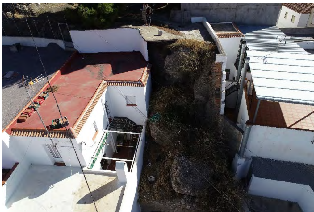
Figura 5.11. 4: Parte superior de la torre CE 02.
