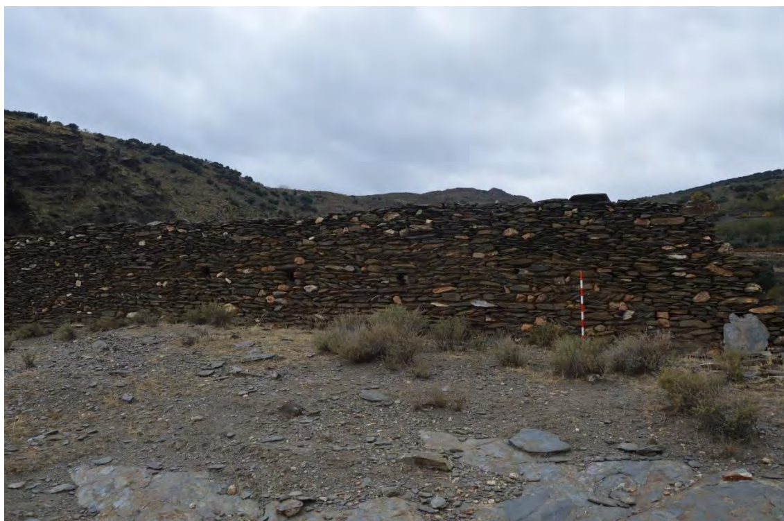
Figura. 5.13. 21: UE 09 realizada a espina de pez en la parte inferior y sobre ella la UE 10.
