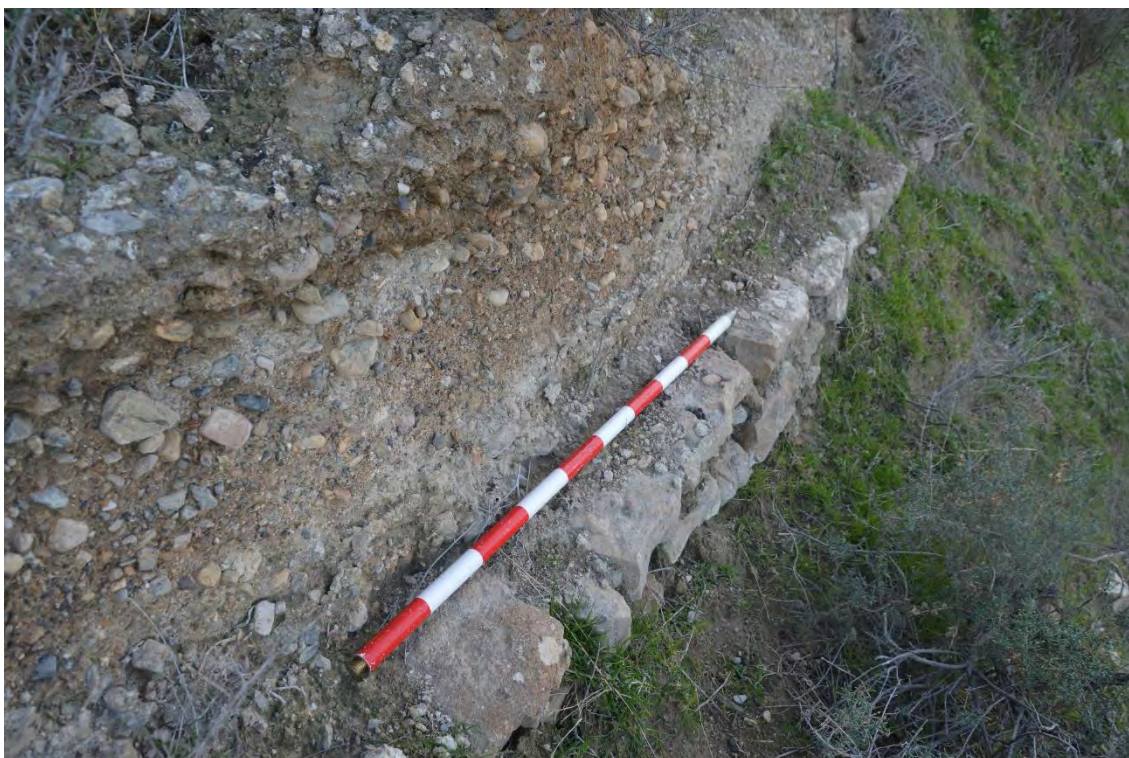
Figura 5.12. 15: Zarpa de mampostería -102- y sobre ella el tapial -101-.
