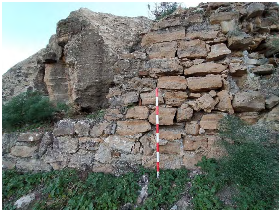
Figura 5.12. 16: Restos del paño de muralla UE 61.
