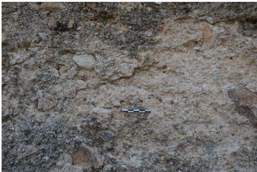
Figura 5.3. 15: Mortero del aljibe -UE 12-.
