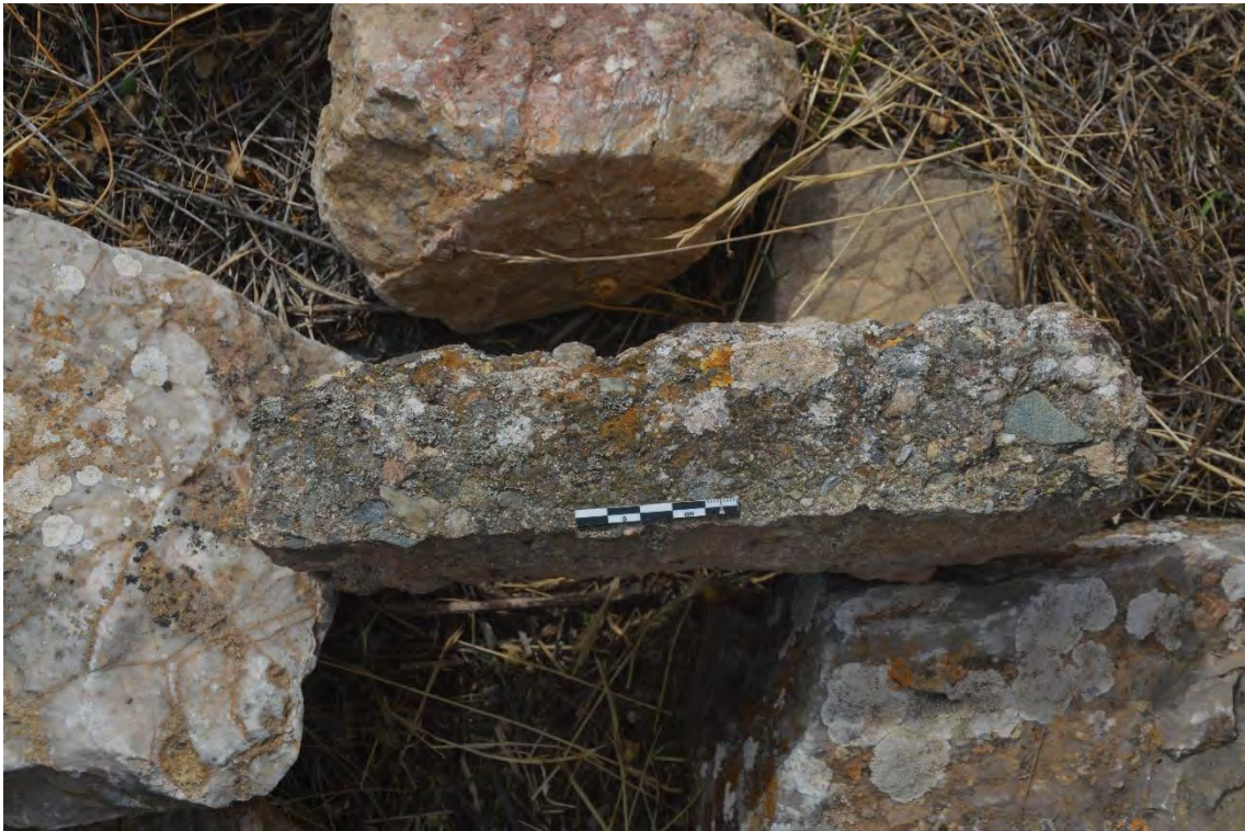
Figura 5.5. 14: Restos de mortero perteneciente a una costra de tapial calicostrado
