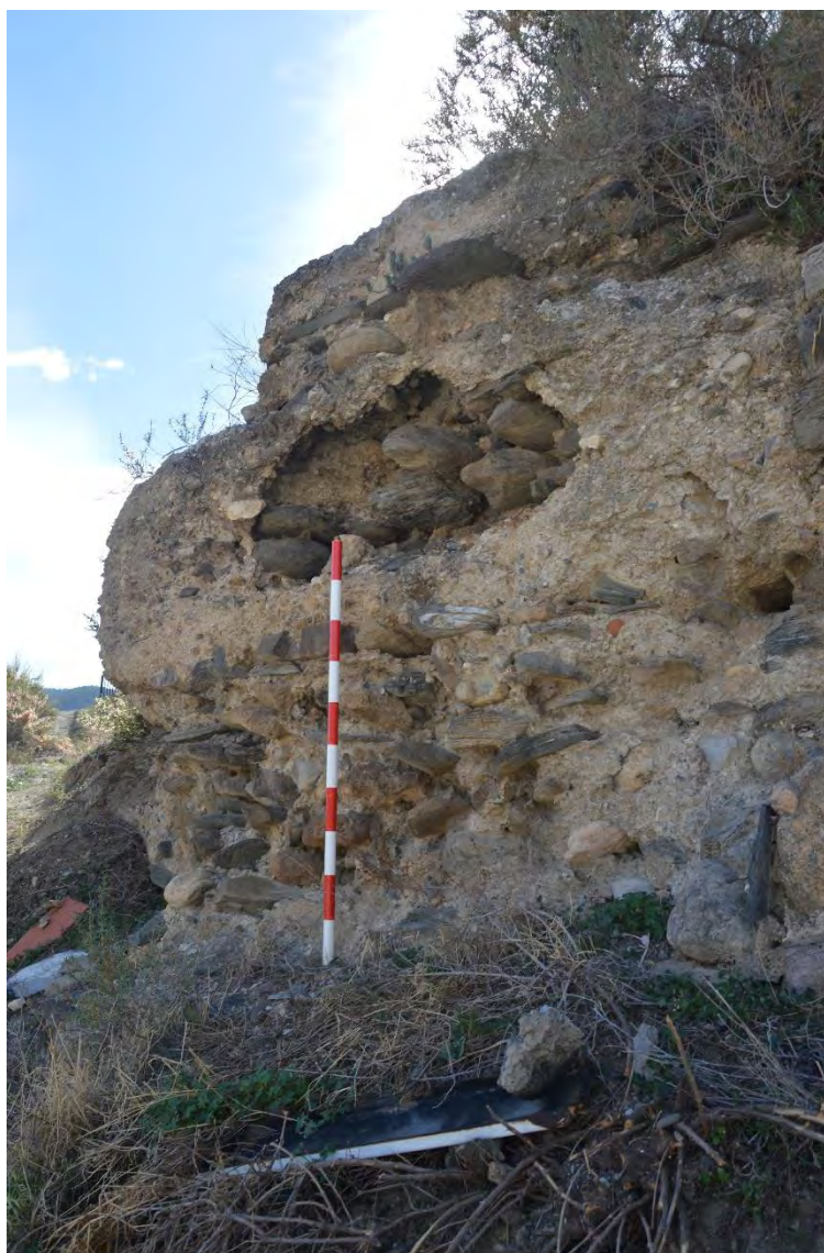
Figura 5.4. 4: Frontal de la torre CE 02.
