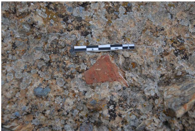
Figura 5.16 9: Hormigón de cal con fragmentos de cerámica del tapial UE 20.
