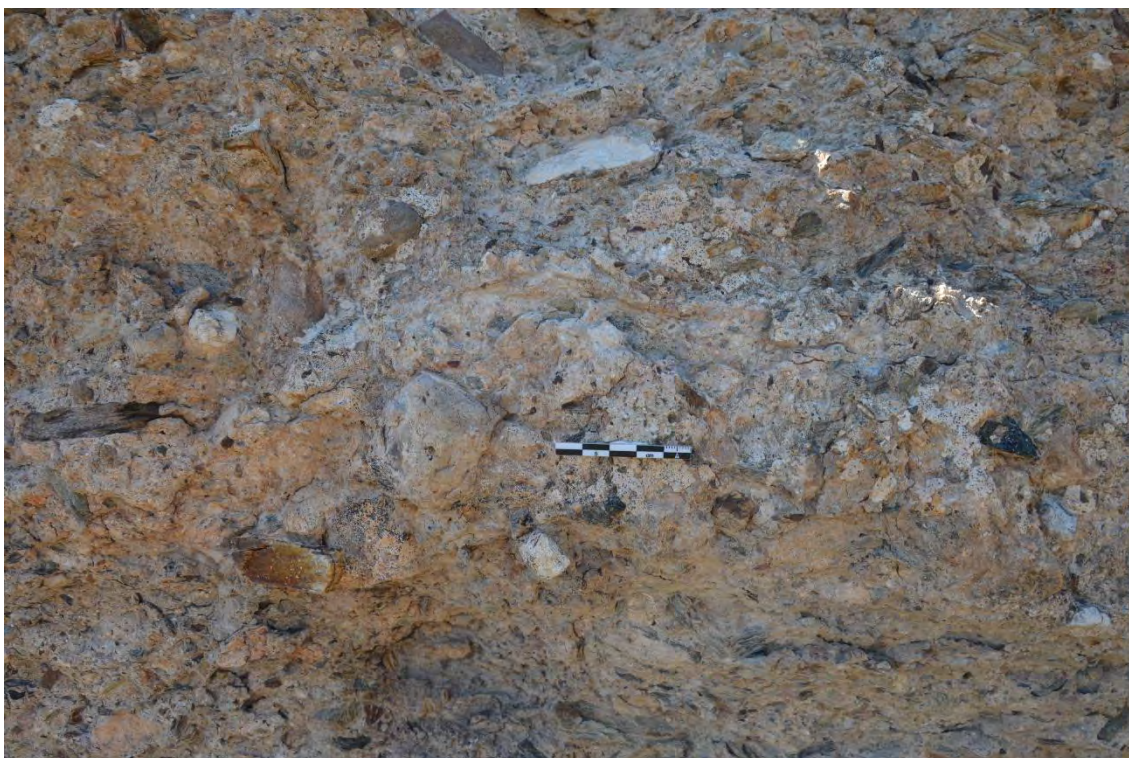
Figura 5.7. 10: Mortero del calicanto de la UE 14.
