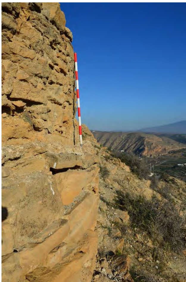
Figura 5.12. 10: Zócalo de mampostería -UE 130- sobre el que se levanta el alzado de la torre UE 49.
