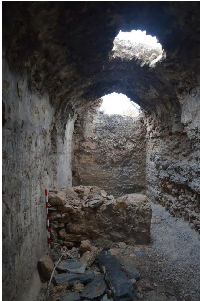
Figura 5.5. 13: Interior del aljibe con la UE 37 compartimentando el espacio.
