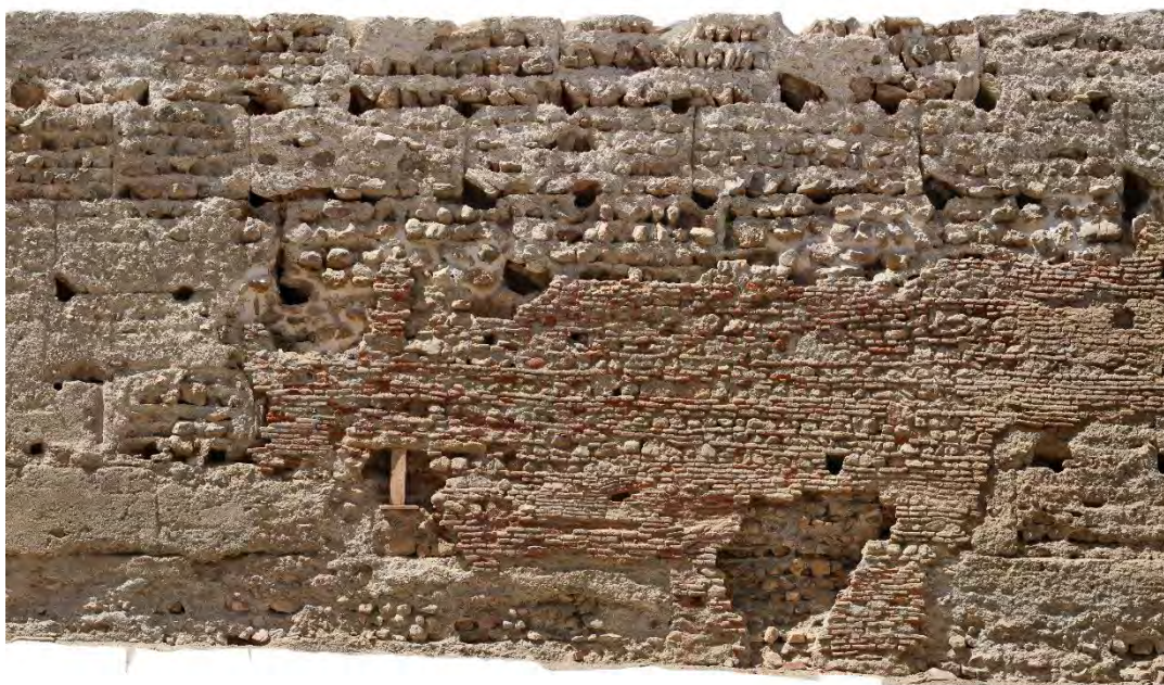
Figura 7. 28: Tapial de calicanto de la alcazaba de Guadix, realizado en cajones con la misma solución para los mechinales que en el caso de Escariantes. Ortofoto cedida por P. Romero.
