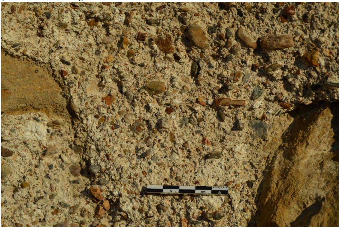
Figura 5.12. 12: Mortero de cal de la UE 57.
