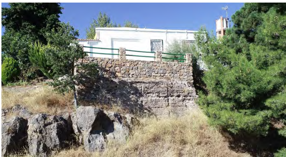
Figura 5.11. 9: Foto aérea de la cara Este de la torre CE 05.
