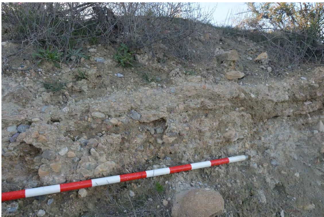
Figura 5.12. 16: Restos del tapial -UE 23- de la cara Este del recinto intermedio, sobre un zócalo de mampostería -UE 22-.
