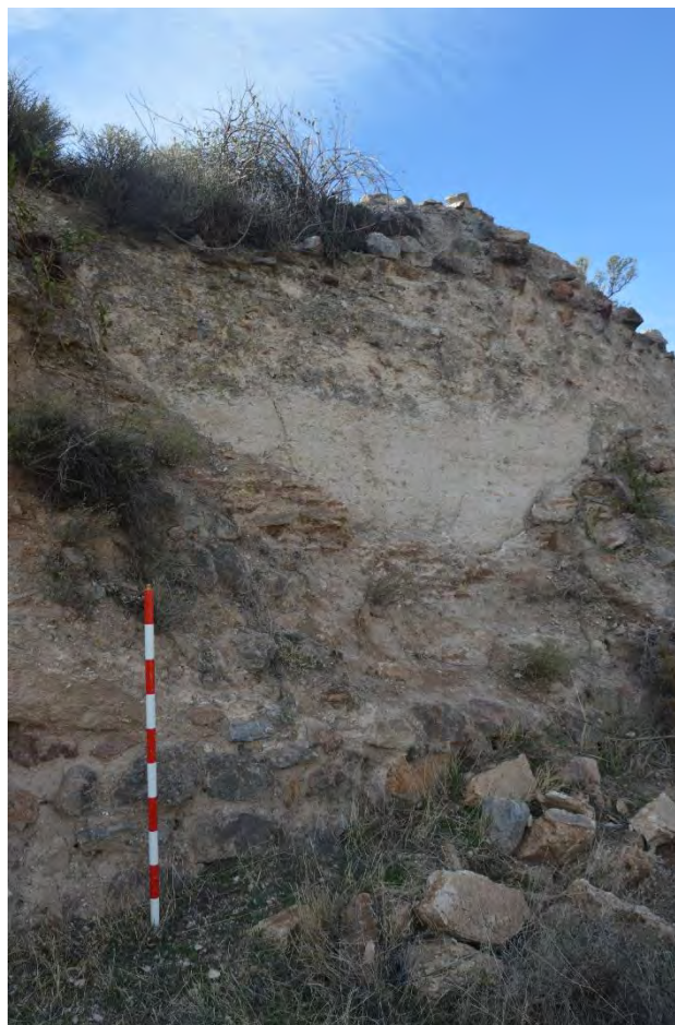
Figura 5.3. 17: Restos del tapial calicostrado -UE 10- sobre zócalo de mampostería -UE 11-, forrando aljibe.
