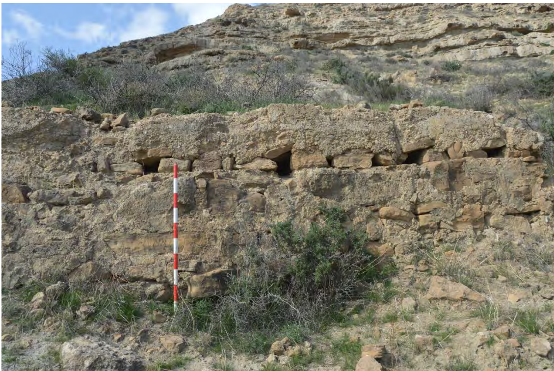
Figura 5.12. 70: Tramo de acequia en la que se levanta sobre un zócalo también de tapial para salvar el desnivel.
