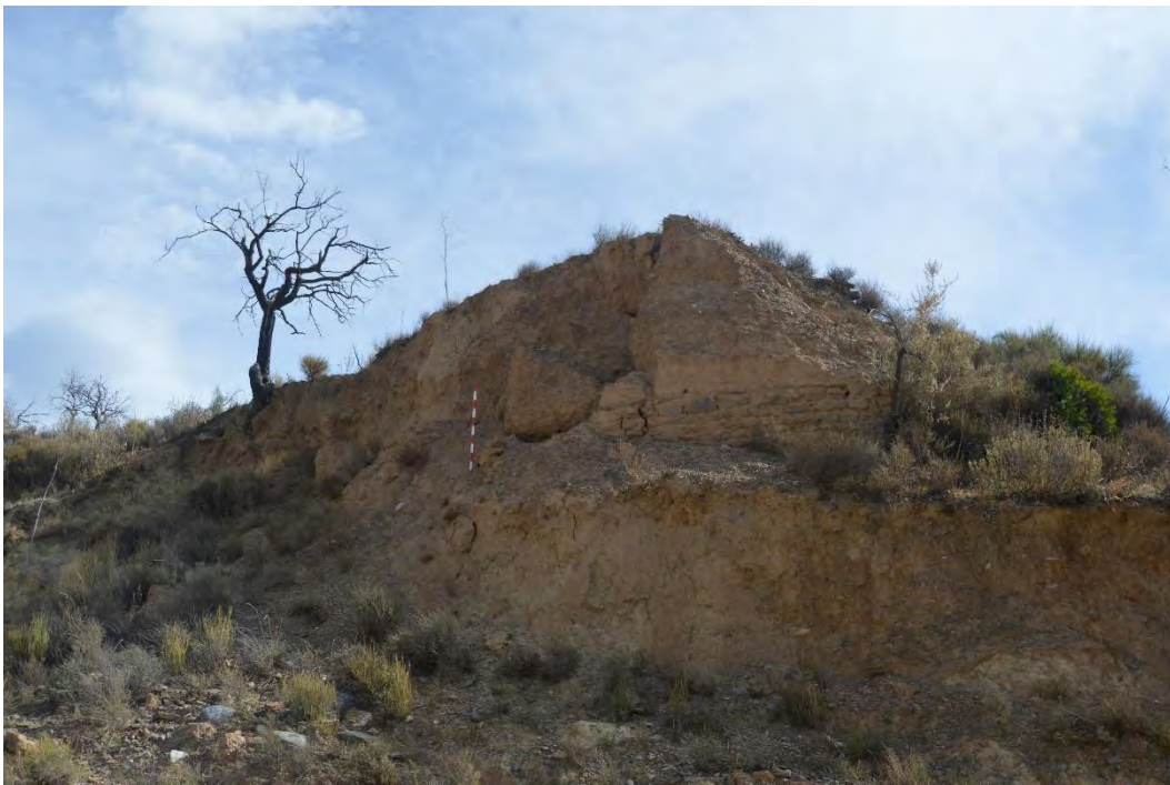
Figura 5.2. 3: Restos del alzado de la torre E 01.
