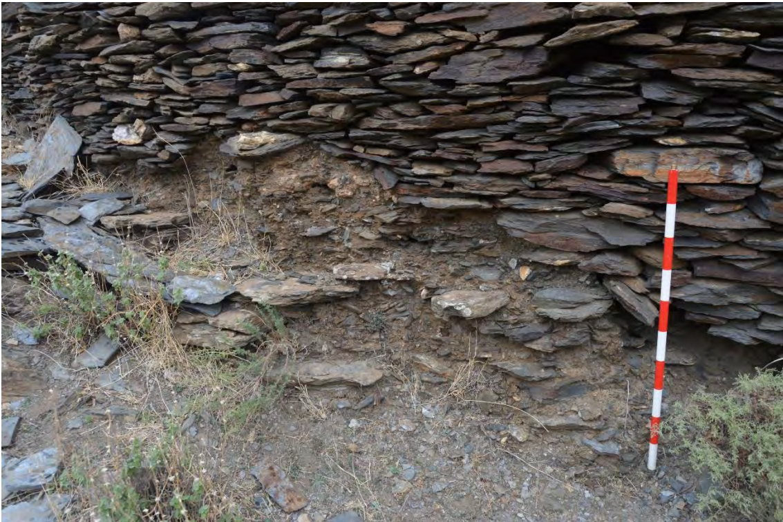
Figura 5.13. 6: Restos de tapial calicostrado -UE 17-.
