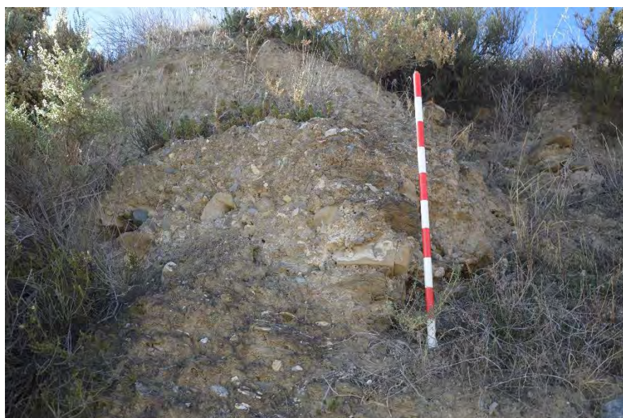
Figura 5.4. 6: Tapial hormigonado -UE 04- con los restos de mampostería en la parte superior derecha de esta -UE 05-.
