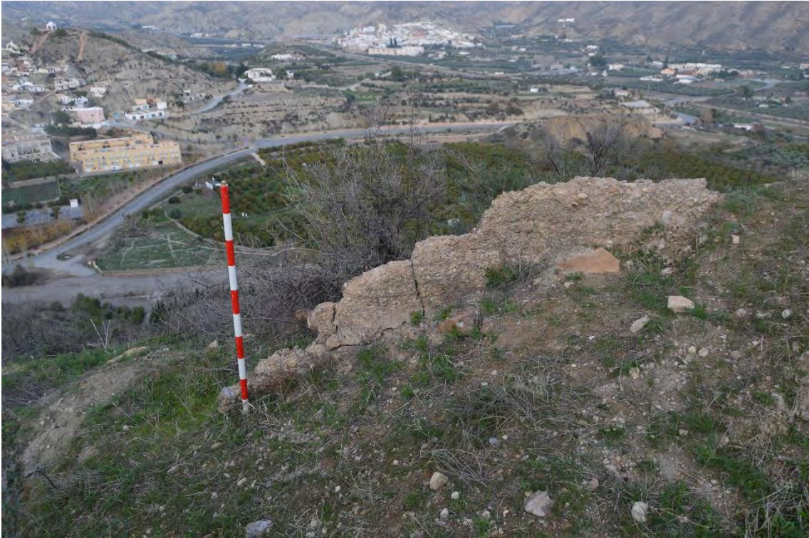
Figura 5.12. 25: Resto del tapial calicostrado del recinto exterior.
