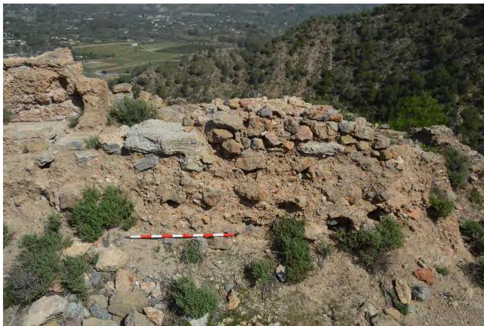
Figura 5.14. 7: Continuación de la UE 40 y la 42 sobre ella reparándola.
