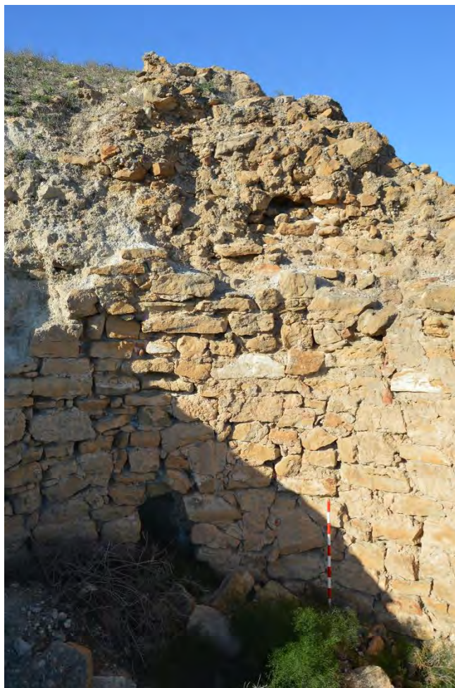
Figura 5.12. 7: Aparejo interior de la torre UE 47.
