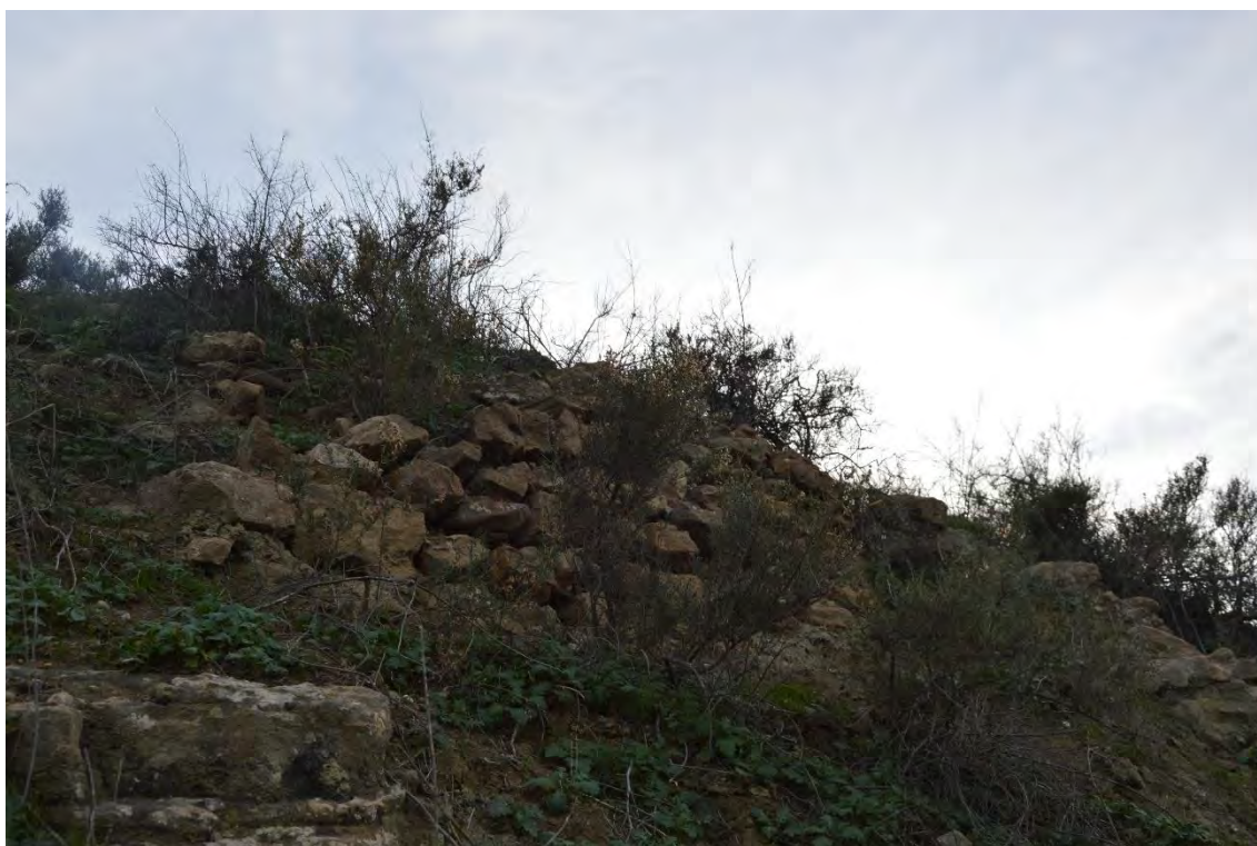
Figura 5.12. 30: Restos de mampostería de la UE 89.
