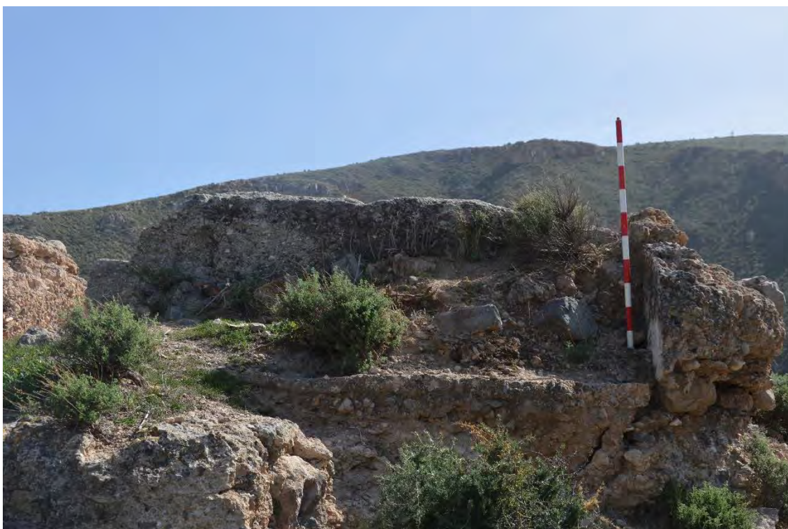
Figura 5.14. 5: Restos del pavimento -UE 14- sobre el tapial calicostrado UE 12.
