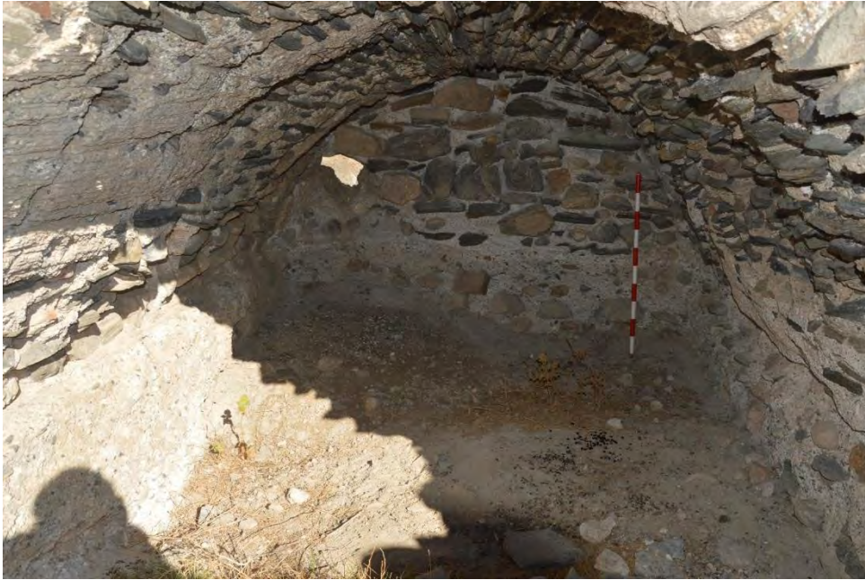
Figura 5.17. 12: Interior del aljibe CE 04.
