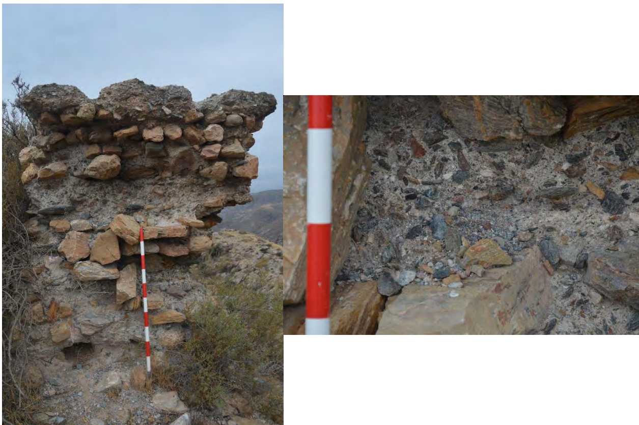
Figura 5.5. 6: Restos de la UE 20 y su mortero.
