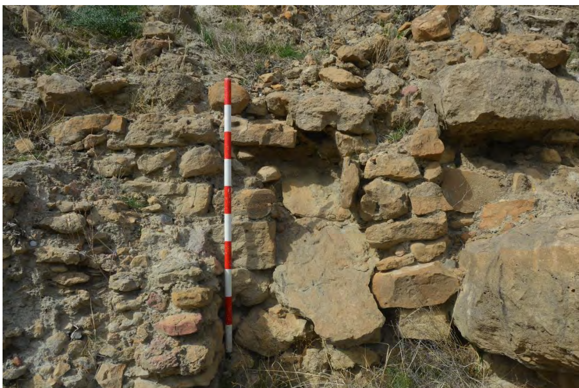
Figura 5.12. 65: Restos de la UE 120 con la atarjea de desagüe en el centro -UE 119-.
