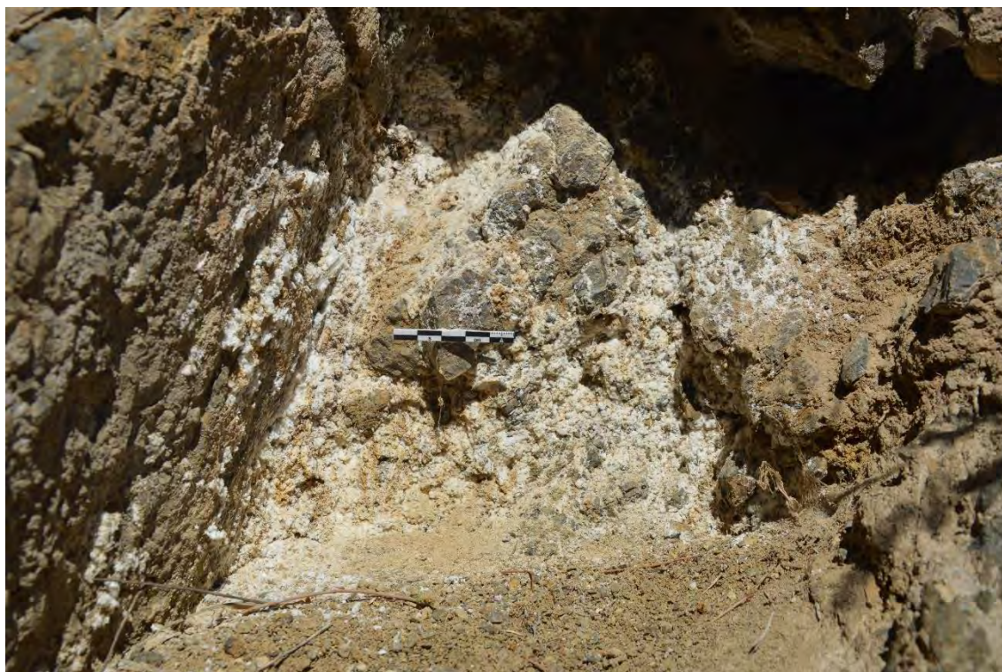
Figura 5.6. 4: Restos de la UE 04 forrando a la roca madre en el extremo meridional del cerro, bajo el recinto superior de la fortaleza.
