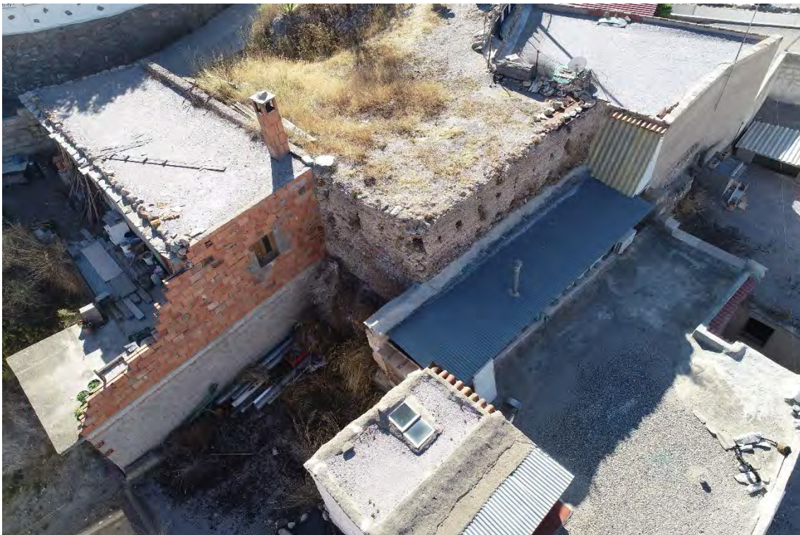
Figura 5.11. 5: Vista aérea de la torre CE 04.
