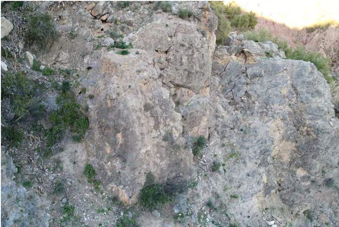
Figura 5.20. 6: Torre albarrana en el frente Sur del peñón.
