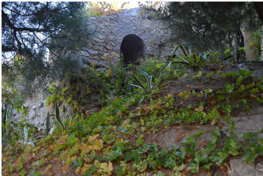
Figura 5.11. 8: Arco de medio punto trabado con cemento sobre posible resto de torre calicostrada -UE 10-.
