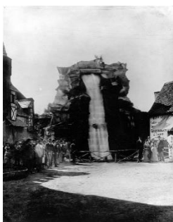
Fig. 8. Cascada de agua impulsada por un motor eléctrico. Exposición de Electricidad, Frankfurt, 1891
