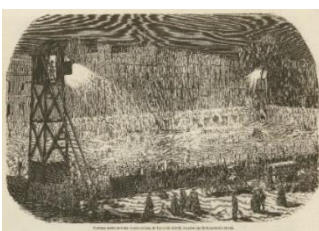
Fig. 3. Trabajos nocturnos con focos eléctricos para la construcción de la calle Rivoli. Grabado para L'Illustración , 1854.
