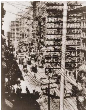
Fig. 42. Líneas de teléfono en Manhattan, 1887. Sector electricidad.com
