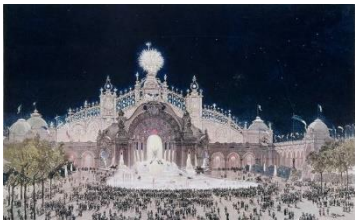
Fig. 27. Palacio de la Electricidad. Litografía.
