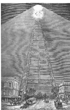
Fig. 6. Diseño de moonlight tower para la ciudad de San José, California, Ca 1881.
