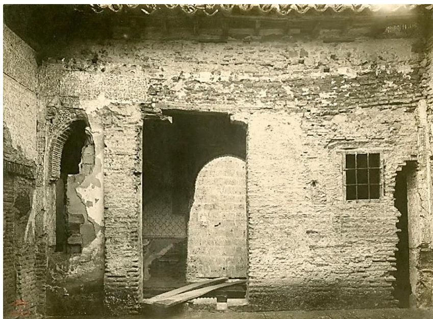
APAG/CF. F-13051. Torres Molina. 1920. Galería oeste del Patio del Harén . Estado anterior a la intervención de Torres Balbás.
