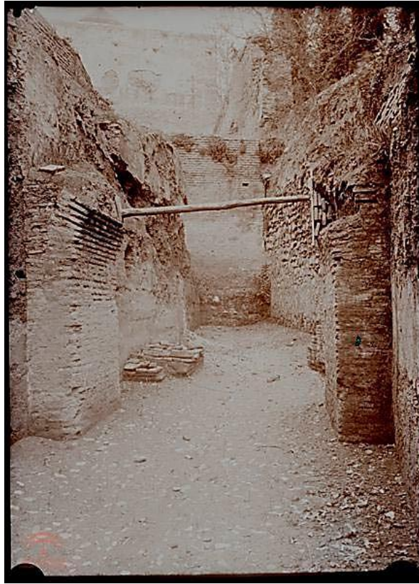
APAG. F-463. Torres Molina. Primer tercio del siglo XX. Intervención en la muralla y camino de ronda.
