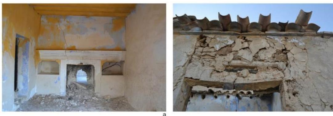
Ilustración 9. Interior de una vivienda del poblado de Marchalico Viñicas en Sorbas, Almería (a). Yesones empleados en la construcción de un edificio en el poblado de Marchalico Viñicas en Sorbas, Almería (b). Elaboración propia.
