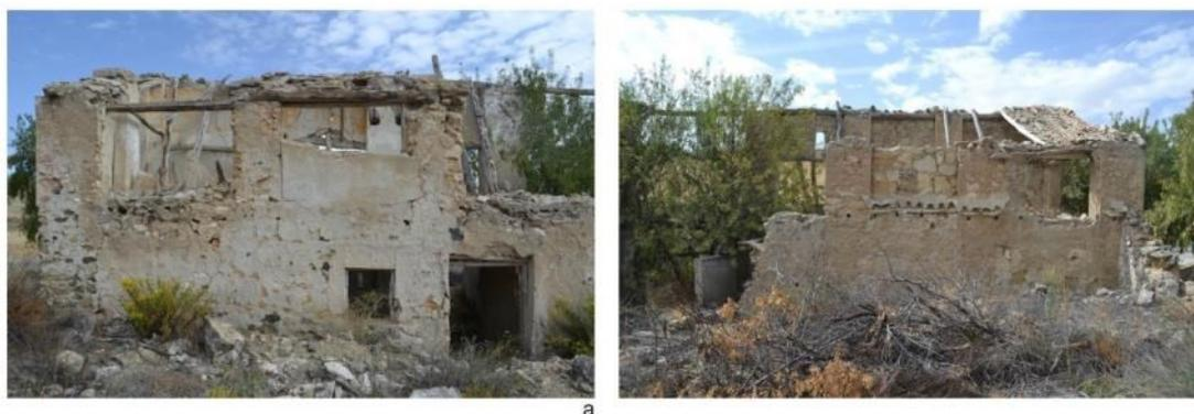
Ilustración 8. Pilares maestreados de yeso y cerramiento de mampostería encofrada a una cara, en el km 30 de la carretera de Agrón – Arenas del Rey, Granada. Elaboración propia.
