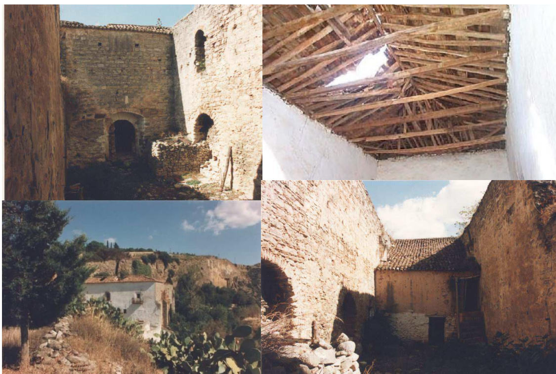
Figura 94. Estado de los Descalzos Viejos. Reproducida con la amable autorización de la bodega rondeña los Descalzos Viejos.
