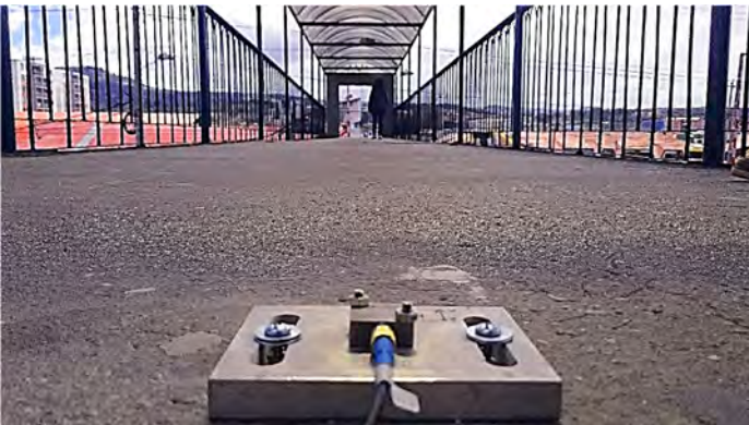
Figura 2-1 Medición de vibraciones en un puente peatonal
