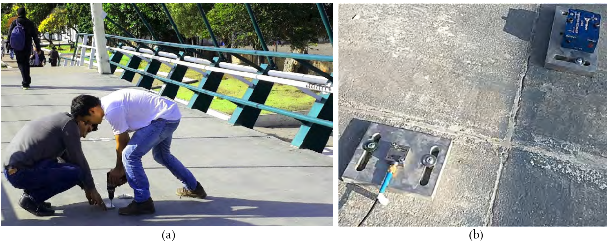
Figura 2-11 Procedimiento de montaje de sensores mediante pernos sobre el tablero de un puente
