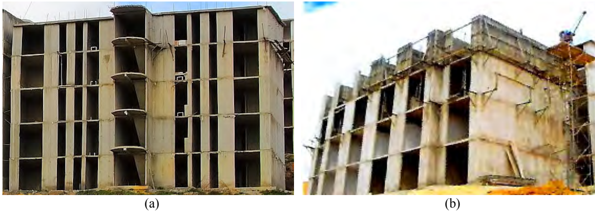
Figura 5-2 Estructura en concreto bloque tipo (a) y proceso constructivo empleado (b)
