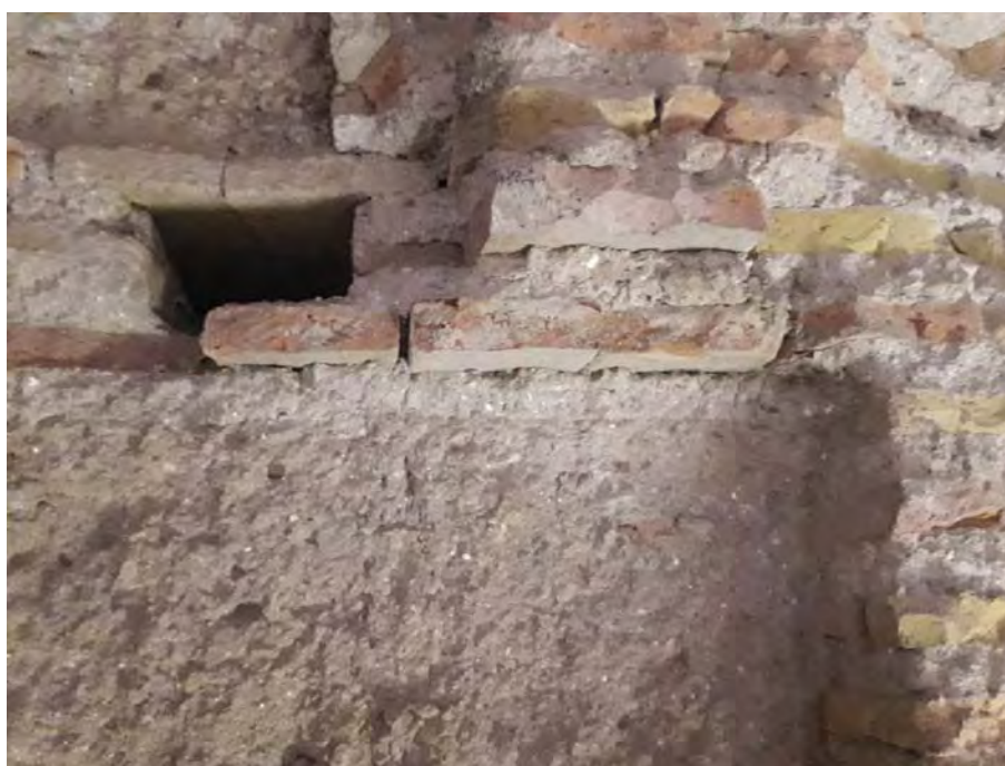
(b) Detalle del remate de mortero de cal previo a la primera hilada de ladrillo de la verdugada
