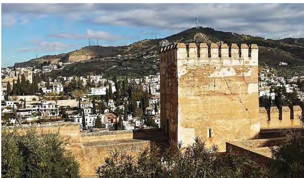
Figura 2.1: Estado actual de fisuración de la Torre de las Gallinas de la Alhambra. s.XIV
