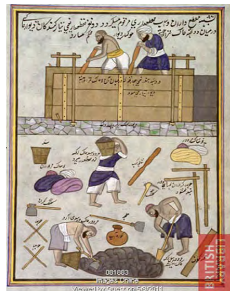
Figura 3.7: Representación de la ejecución de un tapial. Fuente: British Museum
