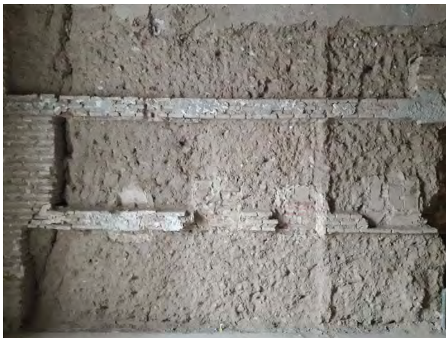
(a) Aspecto de un tapial con verdugadas de ladrillo
