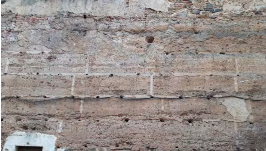
Figura 3.14: Tapia con juntas reforzadas. Muralla de Cáceres s.XII.
