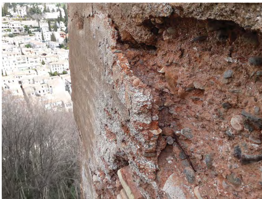
Figura 3.11: Tapial calicostrado. Torre de las Gallinas (Alhambra) s.XIV
