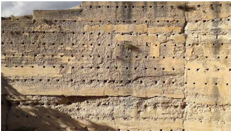
Figura 3.6: Mechinales en alzado de muro de tapial. Muralla Zirí de Granada. s.XII
