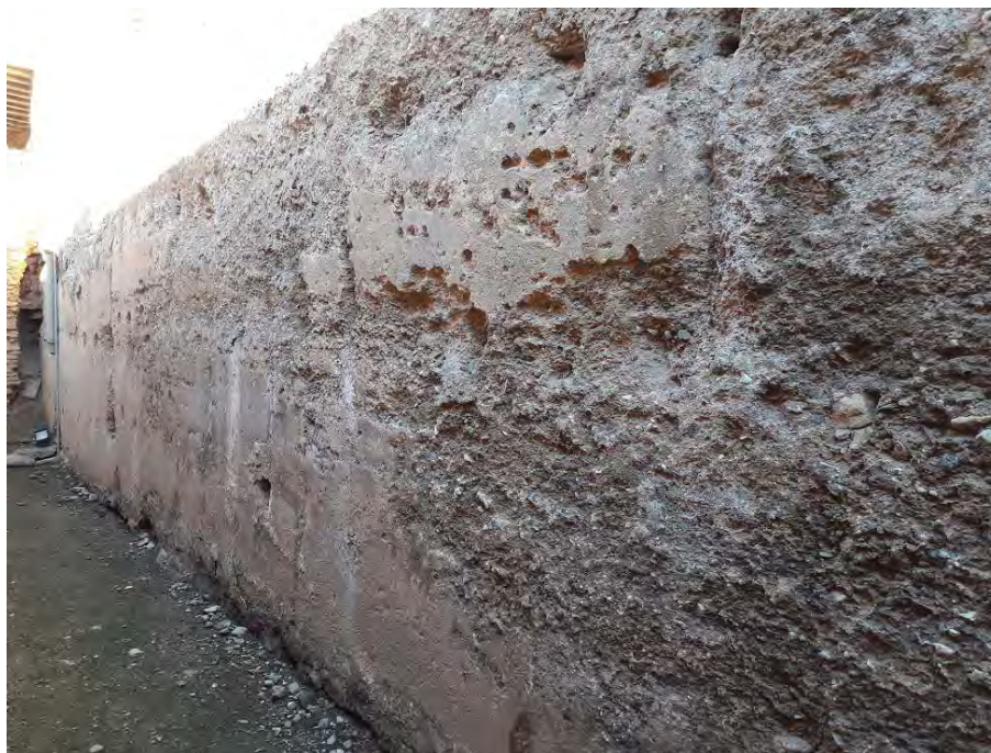
Figura 3.9: Tapial hormigonado. Muralla de la Alhambra. s.XIV
