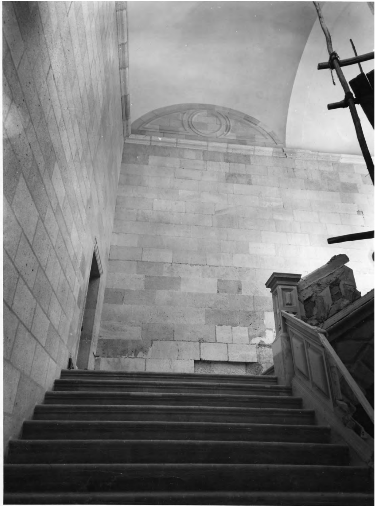
Fig.389. Andamios en la deshecha escalera principal del palacio de Carlos V. (Archivo de la Casa de los Tiros).
