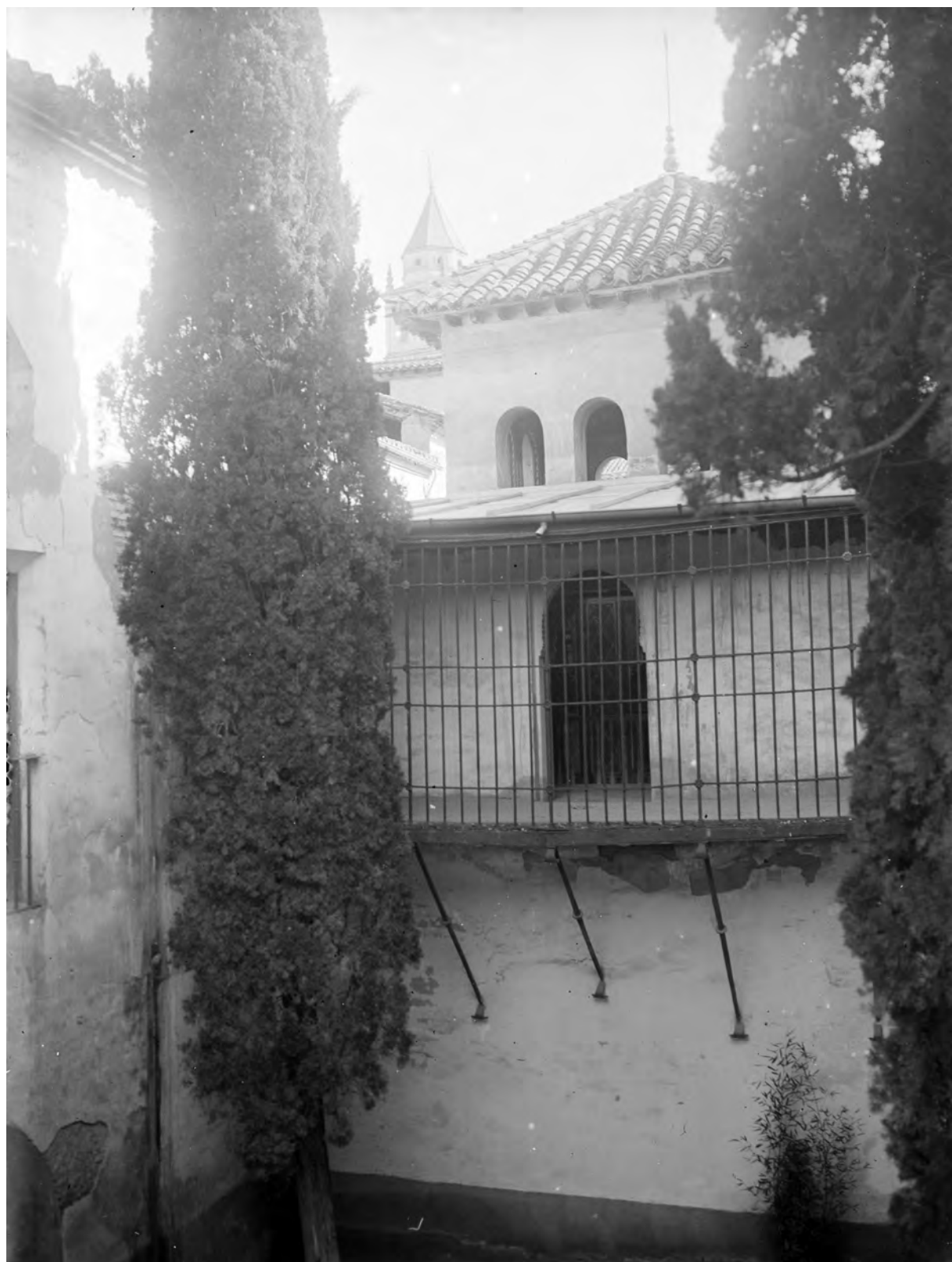
Fig. 183. Patio de la Reja. (Ca. 1880. Archivo de la Casa de los Tiros).
