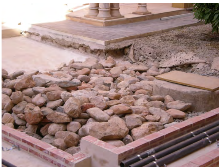
Fig. 300. Cimentación del templete oriental. Palacio del Riyāḍ al-Sa'īd (Fotografía Francisco Serrano).
