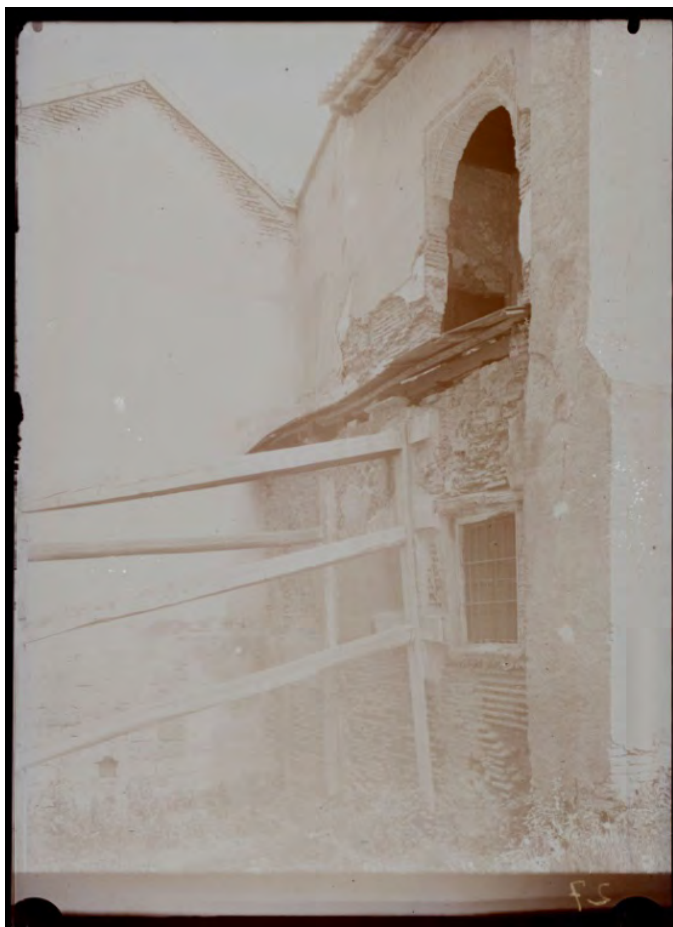
Fig. 392. Desplome del patio del Harem sobre la calle Real Baja. Ca. 1905. (Archivo del Patronato de la Alhambra y el Generalife)
