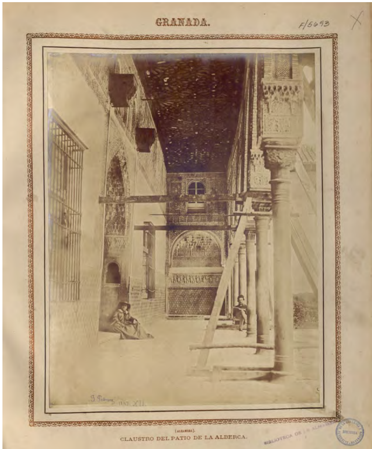
Fig. 235. Interior del pórtico N con el apuntalado de la galería. (Joaquín Pedrosa. Álbum español. 1857. Patronato de la Alhambra y el Generalife).
