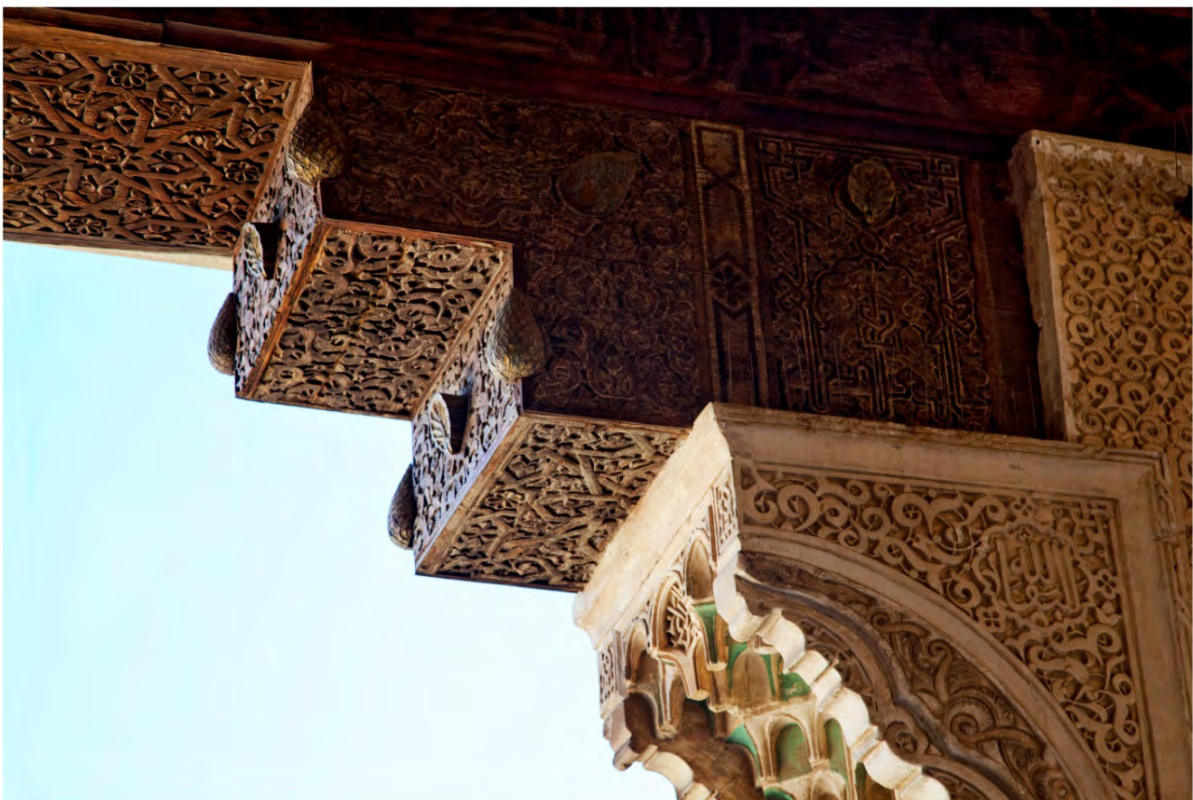
Fig.46.- Zapatas y viga central. Galería del pórtico S de Comares.( Fotografía Francisco Serrano).
