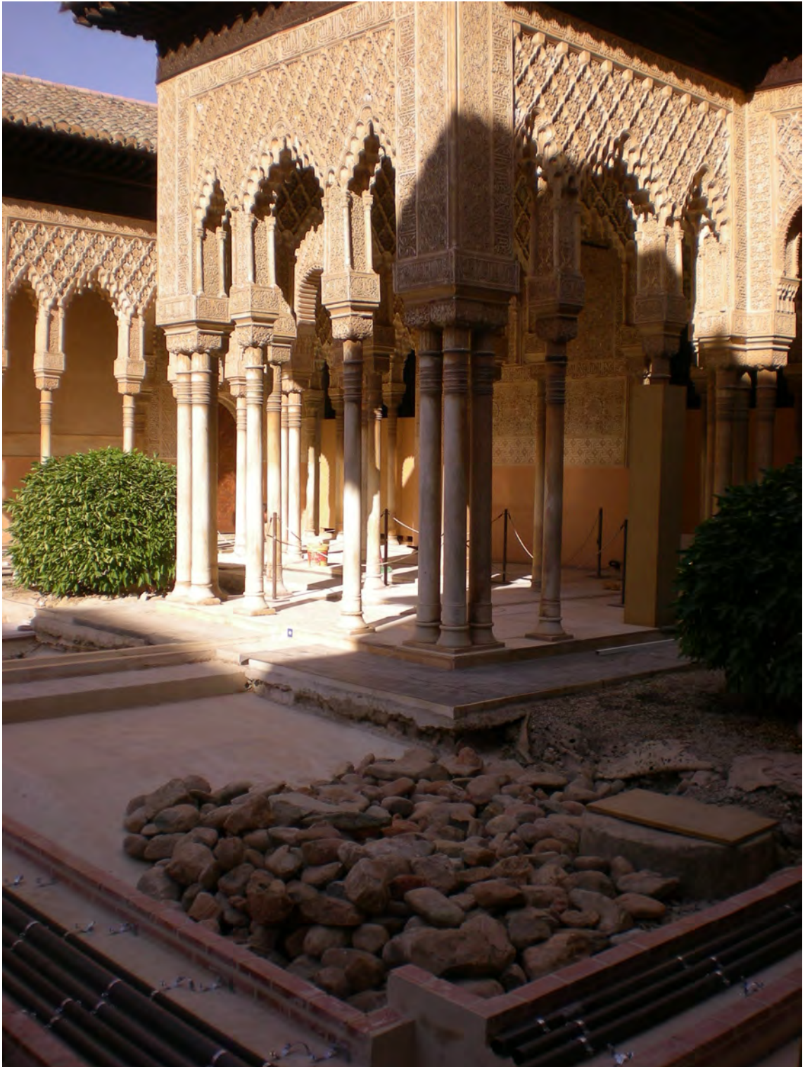
Fig. 263. Templete O con parte de su primitiva cimentación al descubierto (Fotografía de Francisco Serrano).
