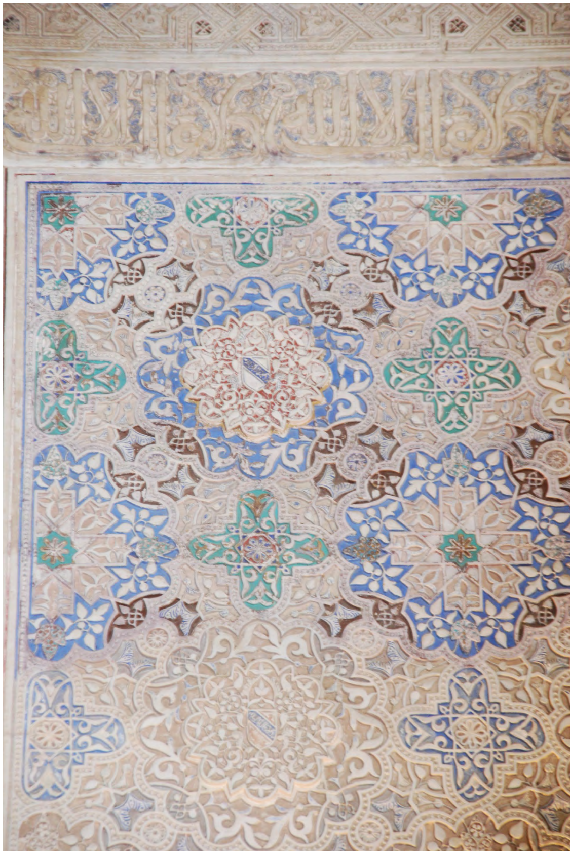
Fig. 279. Pruebas de color en las yeserías reintegradas del muro S de la qubba al-Garbiyya (Fotografía Francisco Serrano).
