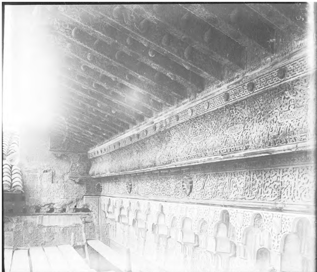
Fig. 317. Parte superior de la fachada de Comares, con los mocárabes, y frisos de madera del alero. (Martínez Riobó. Instituto Gómez Moreno de la Fundación Rodríguez Acosta).
