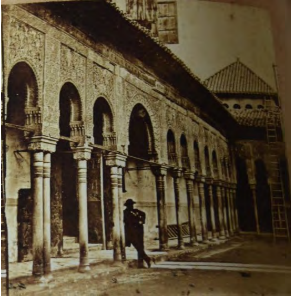
Fig. 290. Intervención en la qubba N de la sala de los Reyes. (A. Gaudín. 1857. Fotografía cortesía de D. Carlos Sánchez Gómez).
