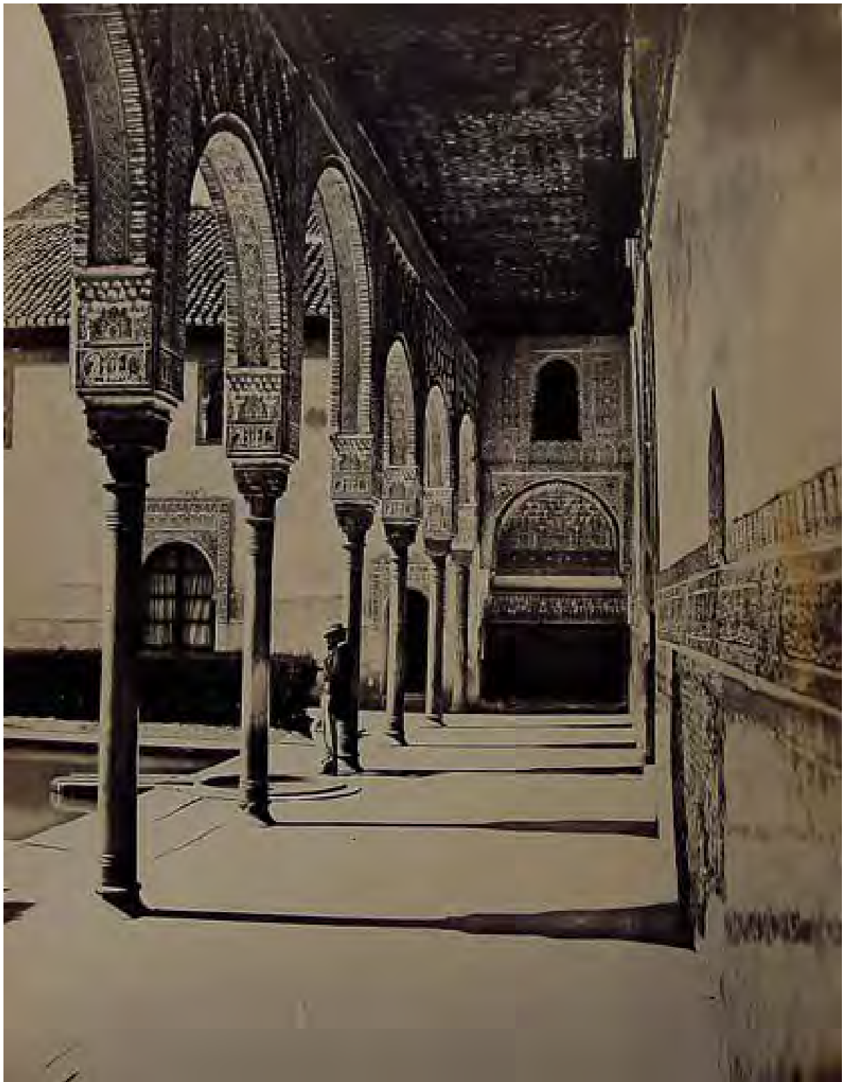
Fig. 248. Interior de la galería del pórtico N del patio del palacio de Comares, tras la intervención de 1860. (Anónimo 1861-1862 ca. Fondo fotográfico Universidad de Navarra).
