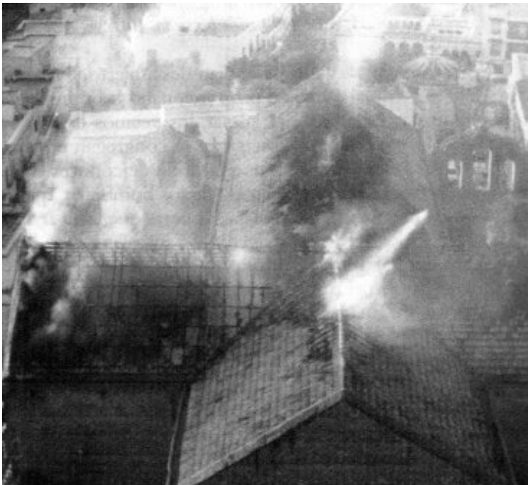
Fig.72.- Incendio de la iglesia de Dalías. (Fotografía Francisco Serrano).
