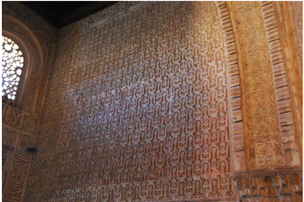
Fig. 224. Muro N de la qubba SO del salón de Comares (Fotografía Francisco Serrano).
