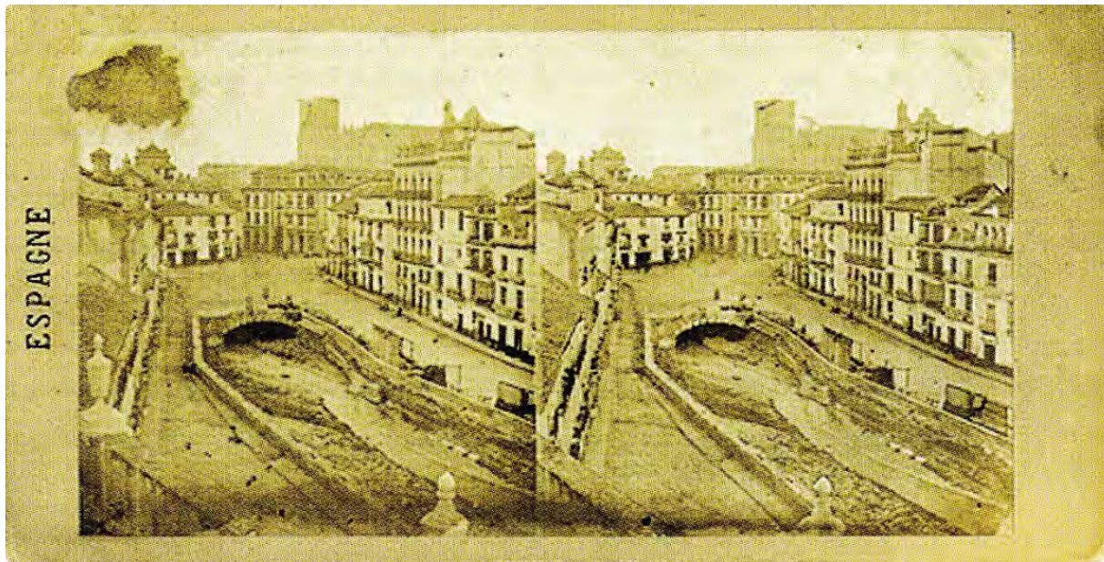
Fig. 366. Vista estereoscópica de Puerta Real, con la alhóndiga Zaida. 1853 ca. Col. Particular. Fot del autor.
