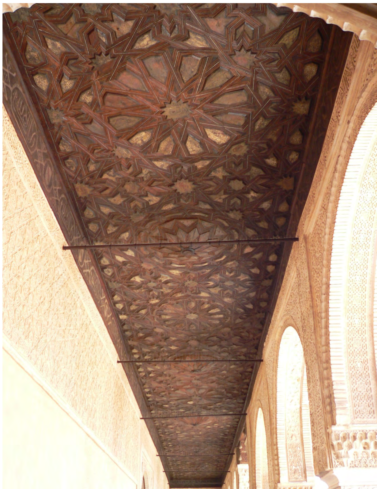
Fig.48.- Techo ataujerado de la galería alta de Comares. (Fotografía Francisco Serrano).
