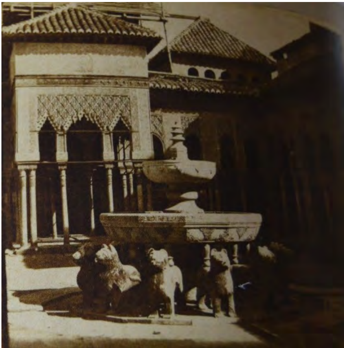
Fig. 289. Intervención en la qubba central de la sala de los Reyes. (Galván y Laurent. 1857. Fotografía estereoscópica, cortesía de D. Carlos Sánchez Gómez).
