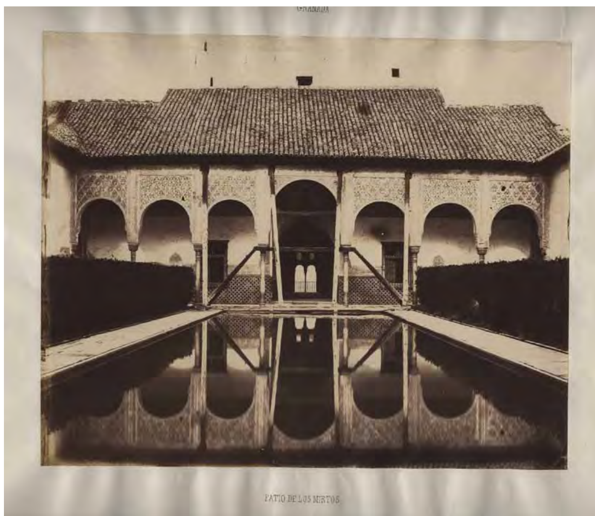
Fig. 240. Galería S del patio de Comares. Luis León Mason. (1855 ca. Fondo fotográfico Universidad de Navarra).
