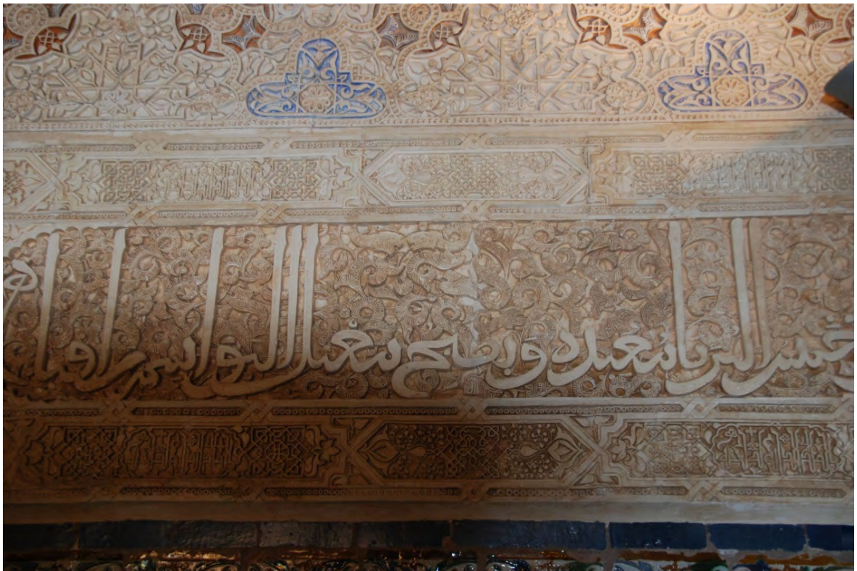
Figs. 277 y 278. Detalles de las reintegraciones de yeserías en el muro S de la Qubba al-Garbiyya (Fotografía Francisco Serrano).
