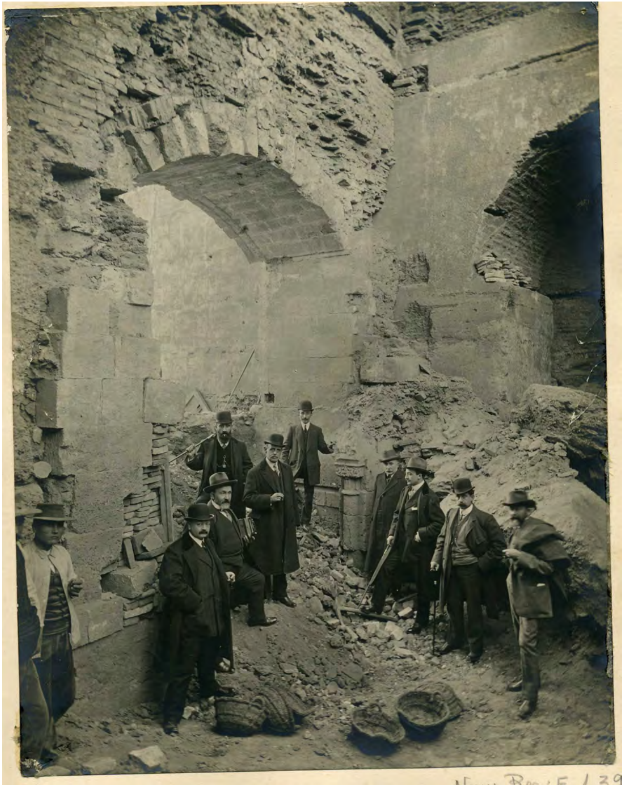
Fig.403. Desescombro de la Puerta de los Siete Suelos. 1906. (Archivo Casa de los Tiros).
