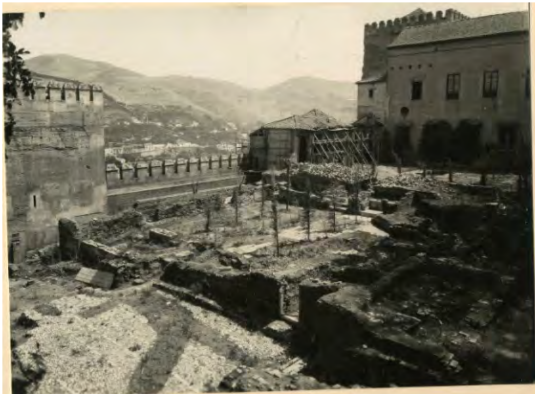
Fig.401. Galería de Machuca con puntales tras la desaparición de la casa colindante.(Archivo de la Casa de los Tiros).
