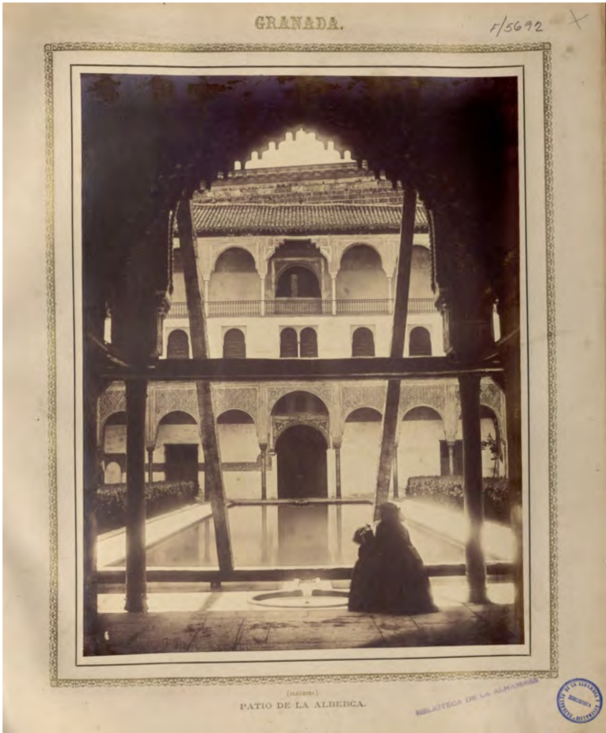
Fig. 234. El pórtico N con el apuntalado de la galería. (Joaquín Pedrosa. Álbum español. 1857. Patronato de la Alhambra y el Generalife).
