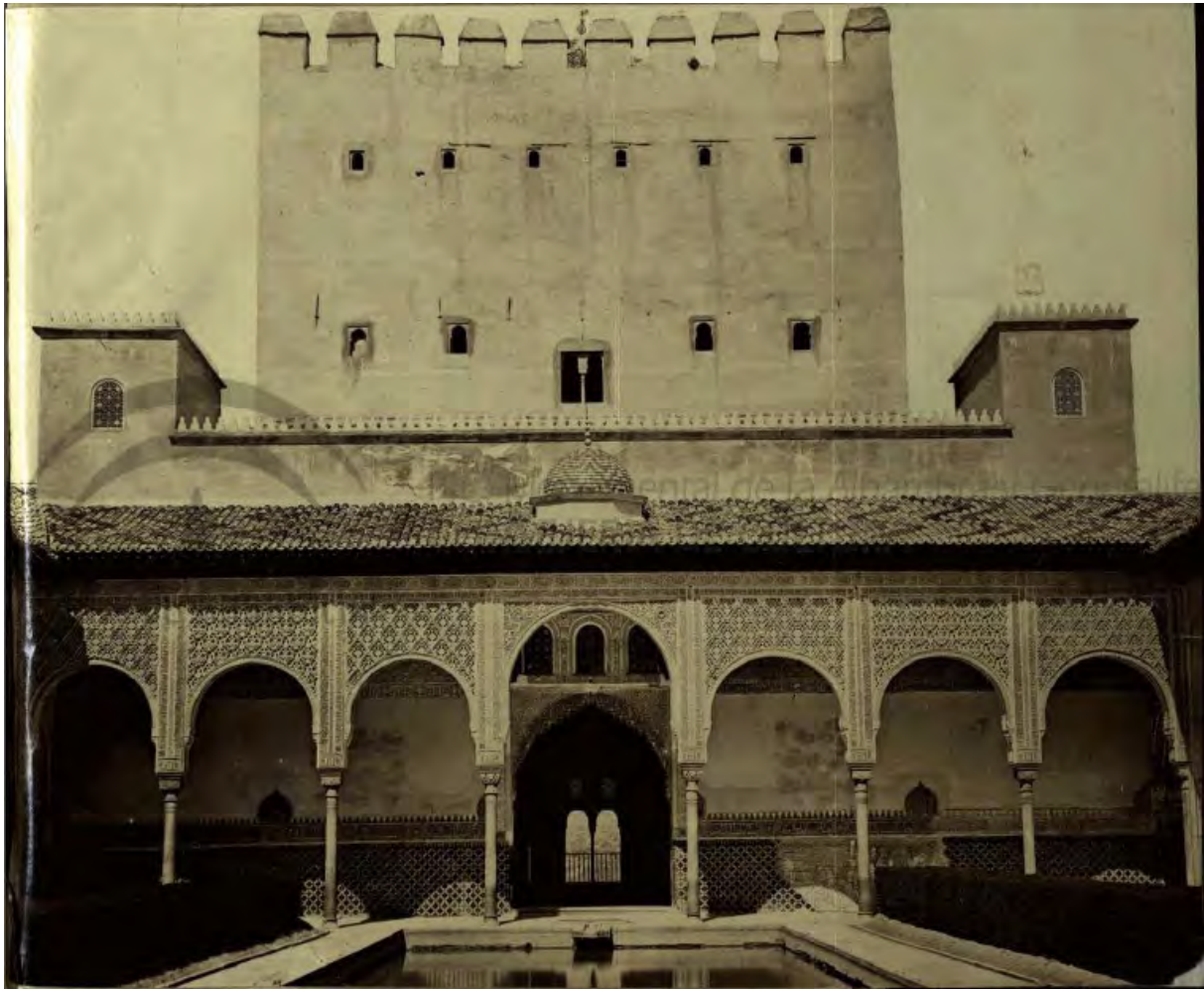
Fig. 237. Anónimo. Pórtico N del patio de Comares, tras la intervención. (1861. Patronato de la Alhambra y el Generalife).
