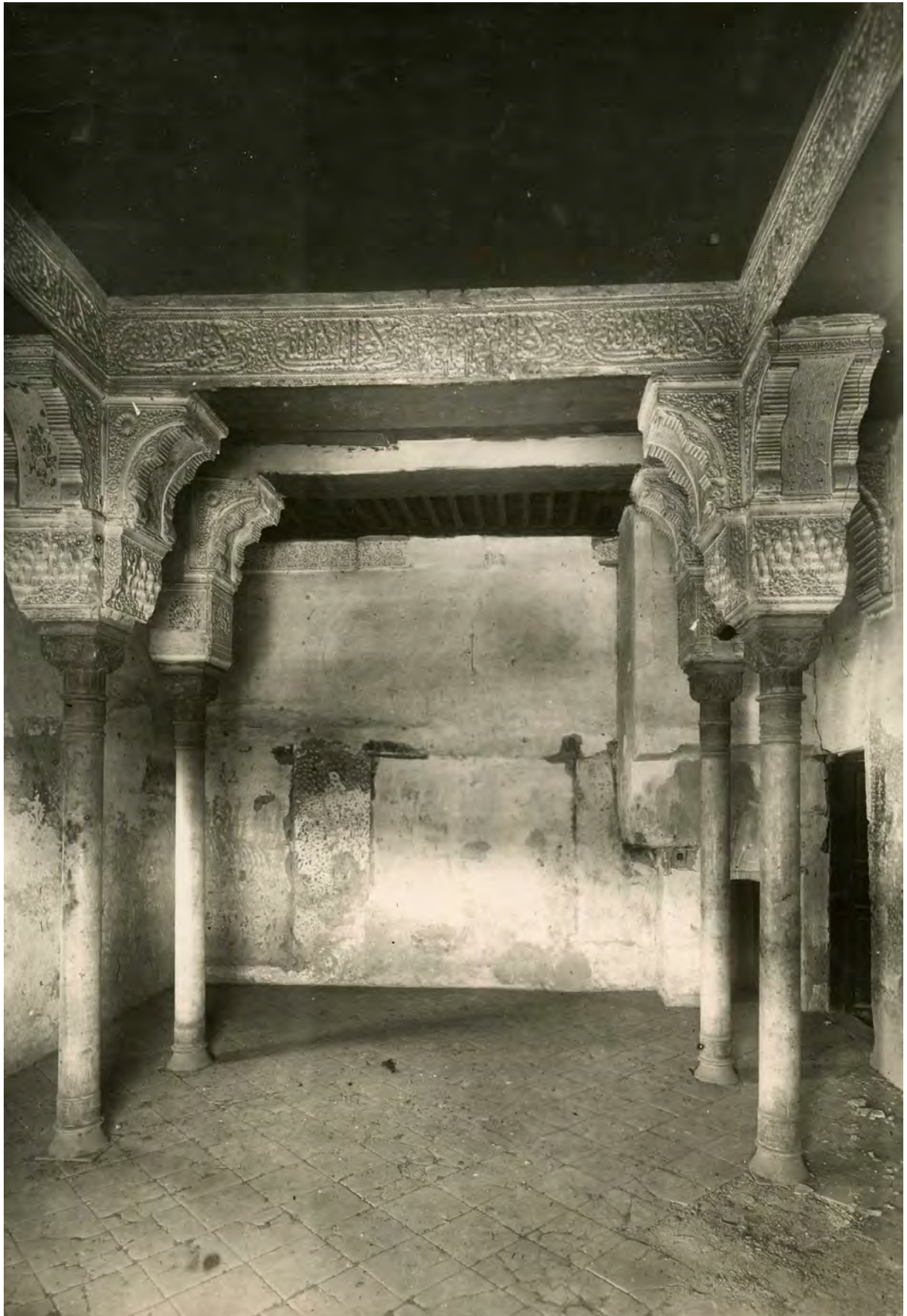
Fig. 190 Estancia de la linterna con el forjado del siglo XVI. (Ca. 1870. Patronato de la Alhambra y el Generalife).
