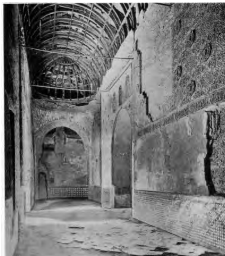
Fig. 378. Sala de la Barca, con los volúmenes restituidos de la armadura. 1905. Col Carnicero- Ruiz Linares.
