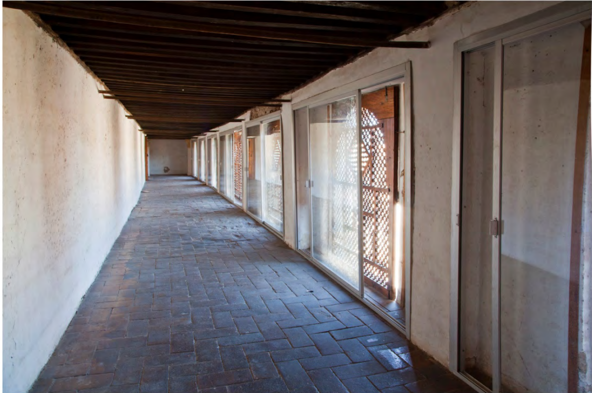
Fig.44.- Primer piso de pórtico S de Comares, con el forjado de viguetas vistas, renovado por José Contreras. (Fotografía Francisco Serrano).
