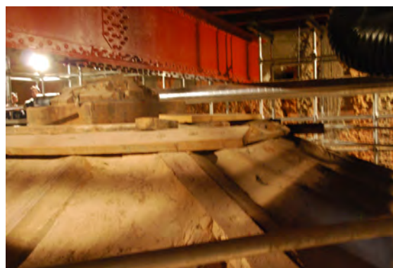
Fig.408. Viga de hierro. Bajo ella el envés del techo de Comares. (Fotografía del autor).
