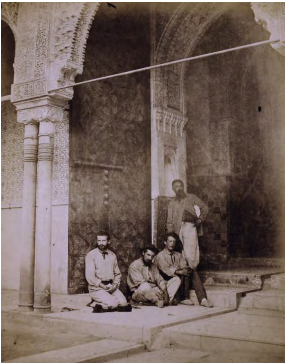
Fig. 272. Grupo de personas ante la hoja izquierda de la recién restaurada y recolocada puerta de la Qubba al-Garbiyya, o sala de Abencerrajes. 1857 ca. Véase como la hoja de la puerta tropieza con uno de los tirantes de hierro que retirado más tarde, apuntalaban el arco de ingreso a la sala desde la galería del patio. (Charles Mauzaisse. Colección Particular).
