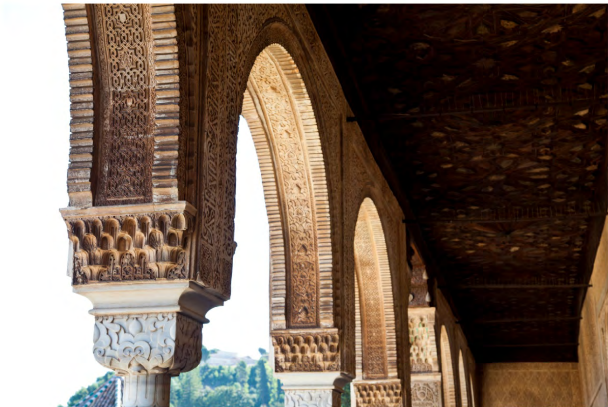
Fig.45.- Arcos renovados en la intervención de 1842. (Fotografía Francisco Serrano).
