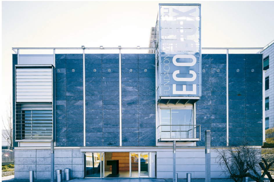
Angel de Diego Risa: Ecobox, Alcobendas, 2005; vista de la fachada principal del proyecto.
