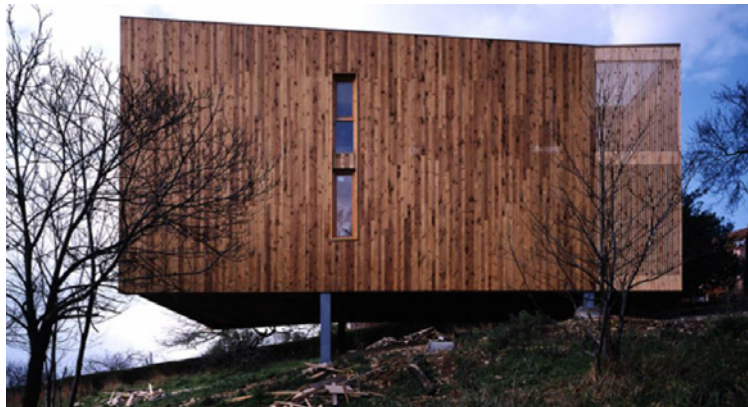
Ecosistema Urbano: Casa de Acero y Madera, Ranón (Asturias), 2003; plantas de proyecto y fachada oeste.
