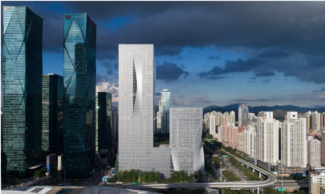
BIG: Shenzhen Energy Mansion, Shenzhen (China), 2009; esquemas de fachadas y vista aérea del rascacielos existente.
