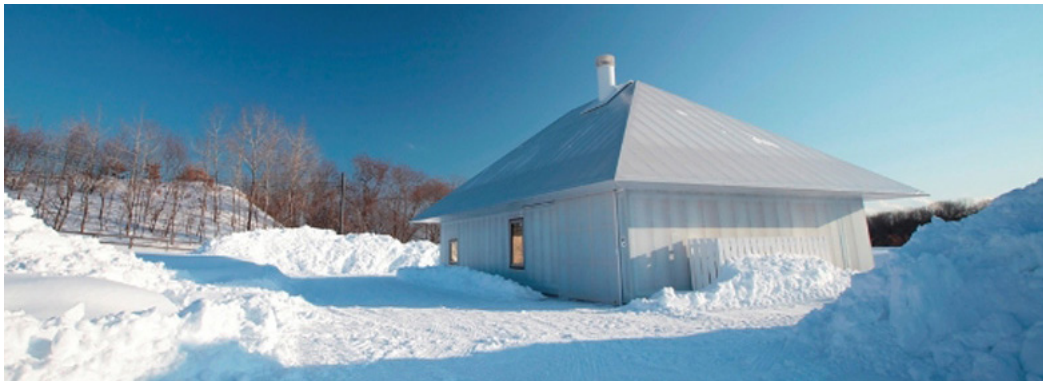
Kengo Kuma: casa experimental Memu Meadows, Japón, 2009-2011; vista interior de la casa y el cerramiento y vista de la casa nevada.
