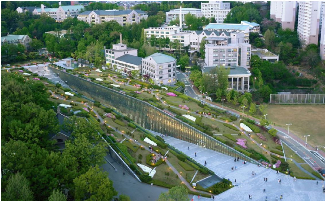
Dominique Perrault: Universidad Femenina de Ewha, Seúl, 2004-2008; esquemas de ideas, sección transversal del proyecto y vista aérea estado actual.
