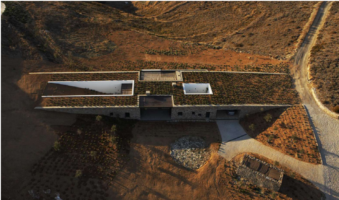
decaArchitecture: Casa Aloni, Isla Antíparos, 2008; planta de la vivienda y vista aérea entre colinas.
