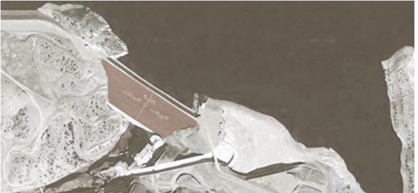
F.8.- Vista aérea de la presa Ahmed El Hansali.
