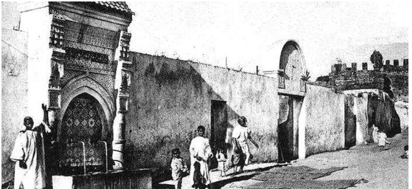
F.34.- Fuente colocada en la fachada principal de Kasbah Bel Kouch.
