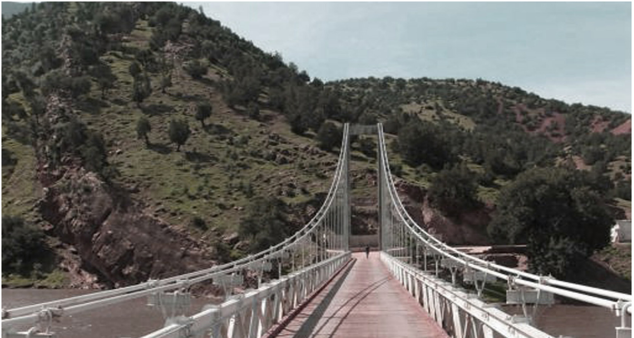
F.13.- Puente Oufdanous.
