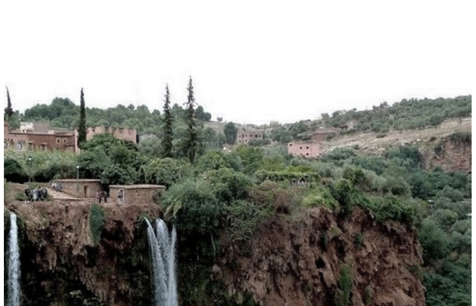
F.18.- Viviendas construidas en el alto de la cascadas de Ouzoud.
