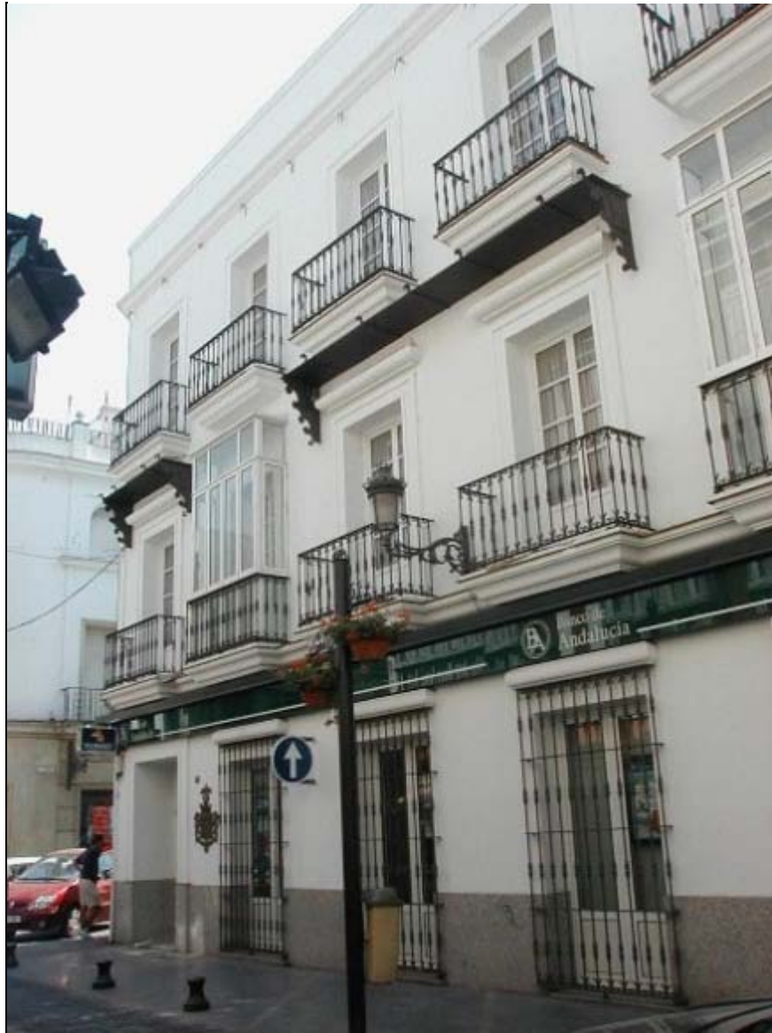
Ilustración 4. Ejemplo de integración y respeto por la coherencia estética en un solar de nueva planta, situado a unos metros del edificio de la ilustración anterior.
