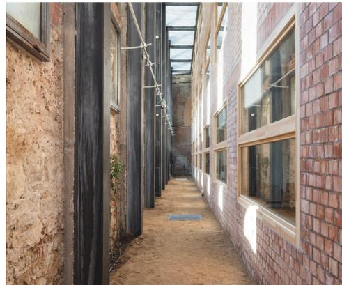
**Figura 76.** Patio Interior del Centro Cívico Cristalleries Planell 1015 en el que se observan los dos tipos de muros y cubierto por vidrio en la parte superior. Foto fuente: [https://images.adsttc.com/media/images/59f3/7b22/b22e/3853/b800/0043/slideshow/\\_14\\_AG\\_3620.jpg?1509128991](https://images.adsttc.com/media/images/59f3/7b22/b22e/3853/b800/0043/slideshow/_14_AG_3620.jpg?1509128991)
