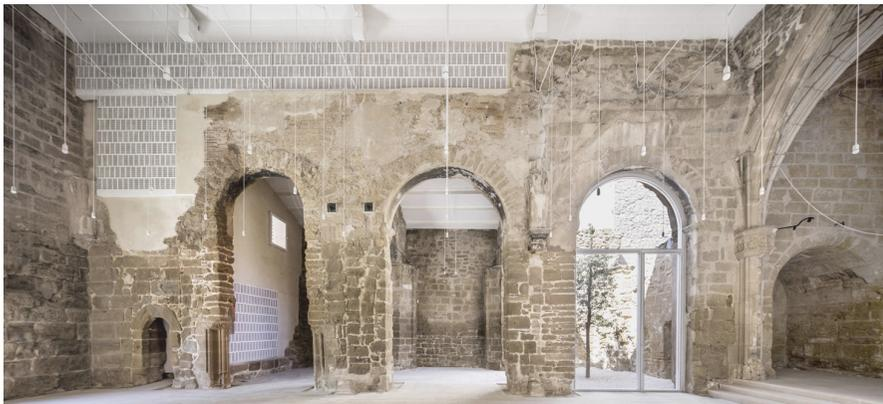
**Figura 72.** Galería de Santa María de Vilanova de la Barca. Observamos los dos tipos de construcciones que se respetan. Ambos utilizan la misma estructura pero la celosía descansa sobre el muro primario. La carpintería realizada a medida a partir de los huecos originales. Foto fuente: <http://hicarquitectura.com/wp-content/uploads/2017/01/AO-VdB-25.jpg>
