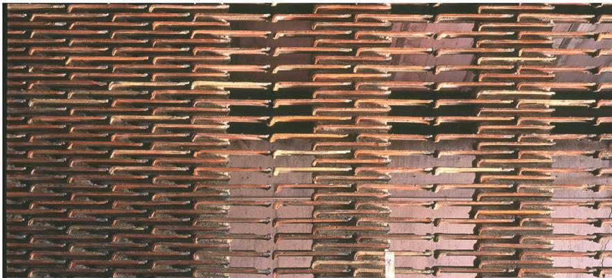
**Figura 48** Sistema constructivo para dividir los espacios a través de la apilación de piezas cerámicas planas. nave8 B Matadero de Madrid. 2009. Arturo Franco. Foto fuente: <https://www.plataformaarquitectura.cl/cl/02-90438/nave-8-b-arturo-franco/512aa876b3fc-4b11a7009cc6-8-b-nave-arturo-franco-photo>
