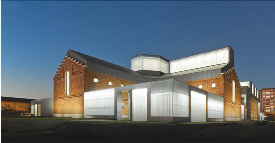
**Figura 59.** Composición de la fachada en tres tipos de material: Fabrica de ladrillo del edificio primitivo, fachada de zinc para ampliar la altura de los pabellones, y las extensiones en planta baja de Uglass. Foto fuente: <https://arqa.com/wp-content/uploads/2012/05/17.jpg>
