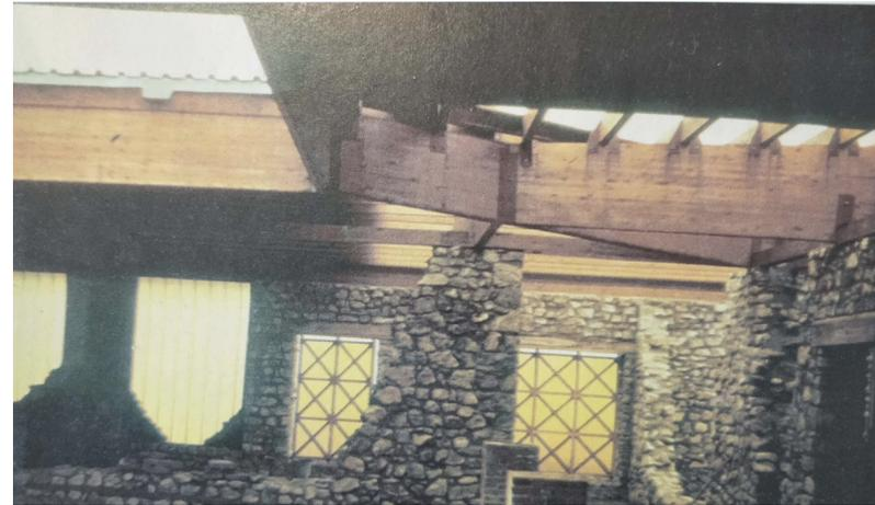
**Figura 31.** Proyecto de cubierta sobre una ruina romana. Balàca (Hungria). 1964. El proyecto trata de realizar una cubierta de madera a partir de una estructura ligera con un criterio crítico, evitando el mimetismo mediante el diálogo entre su carácter ligero y el carácter masivo de la estructura muraria existente. Foto fuente: CARBONARA, Giovanni, 1997, "Avvicinamento al Restauro" de *Liguori Editoriale*, Milan (Italia), Imagen 383
