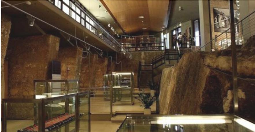
**Figura 12.** Museo Etnográfico Regionale di Cagliari (Italia). 1957-1974. P.Gazzola, L. Cecchini, M. Pinna. La sala temporal ha sido realizada en un base natural de roca calcárea y el alto muro medieval de la antigua cárcel. Se utiliza un sistema constructivo actual que refuerza la construcción petrea histórica. Foto fuente: <https://www.mediterraneaonline.eu/wp-content/uploads/2016/08/Museo-Etnografico-Regionale-di-Cagliari-591x325.jpg>
