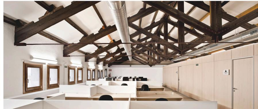
**Figura 54.** Cubierta de la nave industrial de Can Minguell. Las cerchas son vistas, para así formar los dos aleros de la cubierta. El enlucido blanco crea contraste con la madera que es la estructura existente. Foto fuente: [https://images.adsttc.com/media/images/5379/4602/c07a/8059/5700/0170/slideshow/N7X4137\\_42.jpg?1400456690](https://images.adsttc.com/media/images/5379/4602/c07a/8059/5700/0170/slideshow/N7X4137_42.jpg?1400456690)
