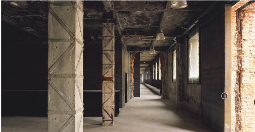
**Figura 43.** Nave Intermediae de matadero de Madrid. 2006. Arturo Franco. Conservación de los pilares y muros preexistentes. Foto fuente: <https://images.adsttc.com/media/images/512a/a4c0/b3fc/4b11/a700/9c2a/slideshow/1305992727-017.jpg?1414264491>
