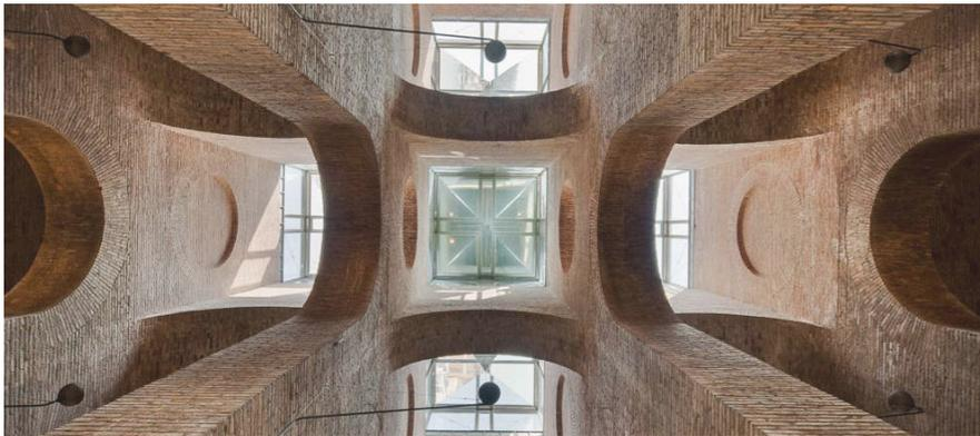
**Figura 40.** En la cubierta se presenta los lucernarios que iluminan el interior con luz cenital y pasan por los arcos. Foto fuente: [http://www.arqfoto.com/wp-content/uploads/2015/09/Biblioteca-Diposit-de-les-Aigues-Clotet-Paricio-arquitectos-SG1209\\_014\\_7180.jpg](http://www.arqfoto.com/wp-content/uploads/2015/09/Biblioteca-Diposit-de-les-Aigues-Clotet-Paricio-arquitectos-SG1209_014_7180.jpg)
