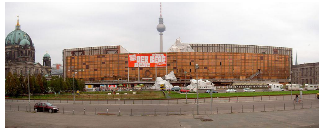
Fig 33. El Palacio de la República en proceso de desmantelamiento en 2005. Autor: Denis Apel (Wikimedia Commons)
