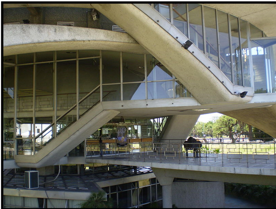
Diferentes escaleras de circulación entre plantas, en la cubierta de la planta inferior es posible apreciar los lucernarios en el forjado de hormigón calado.
