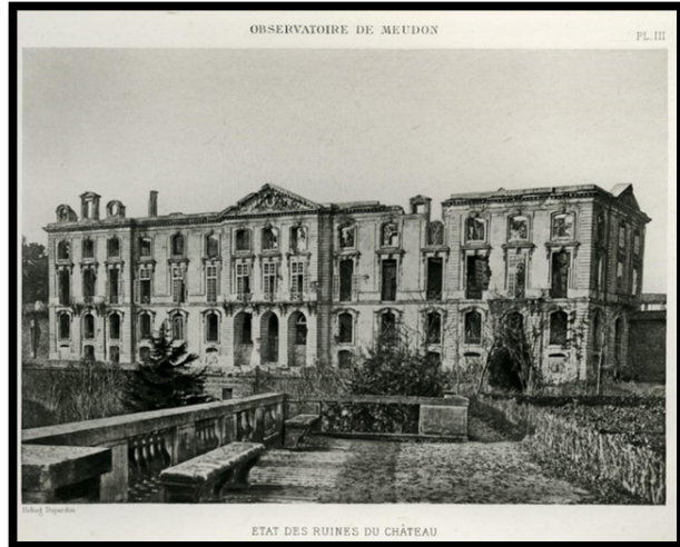
Ruinas del Chateau Neuf (fachada Este)
