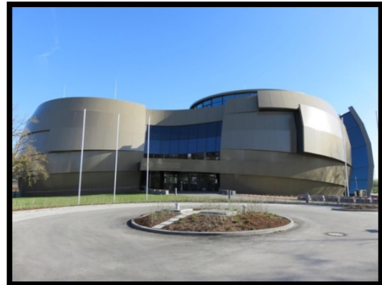
Estado actual finalizado (fachada de acceso)
