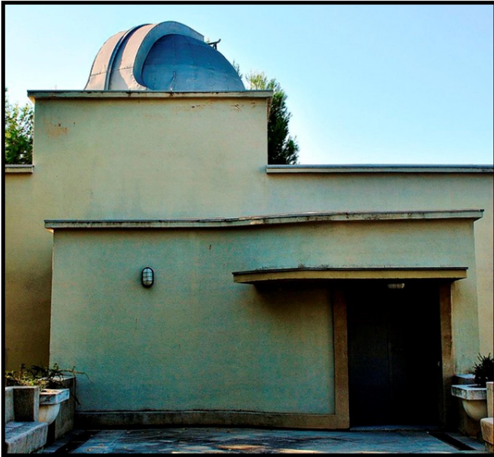
Acceso al pabellón del astrógrafo.
