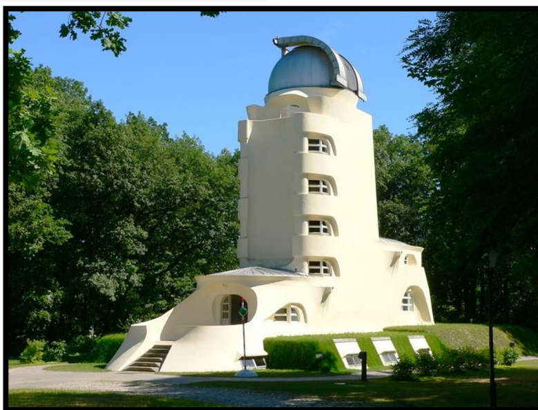
Einsteinturm, en construcción, tras los bombardeos de 1945 y en la actualidad.
