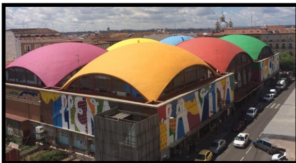
Cubiertas del Mercado de la Cebada en Madrid.
