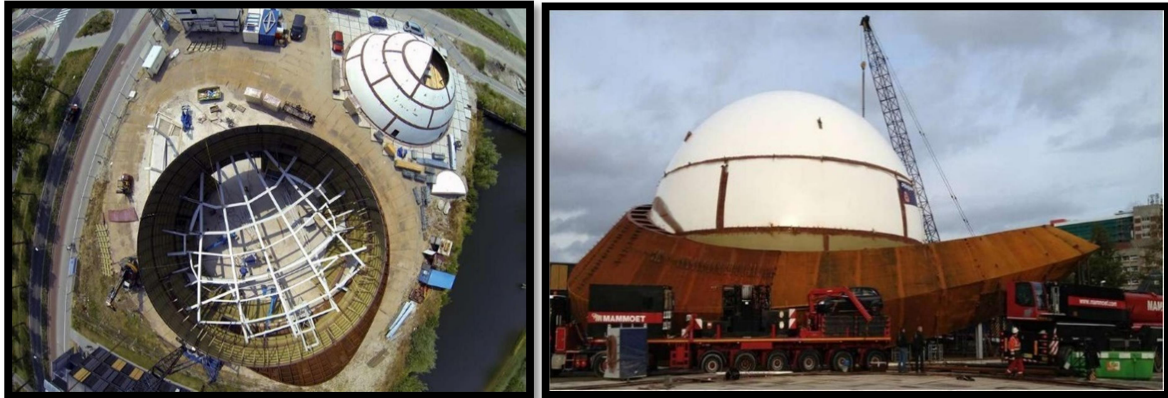
Vista cenital de la construcción de la cúpula, a la vista está la estructura en grada de la sala de proyección y uno de los cascos esféricos preparado para ser colocado. Y finalización de la misma.
