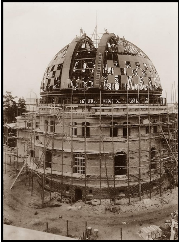
Obras de construcción del edificio del Großher Refraktor.
