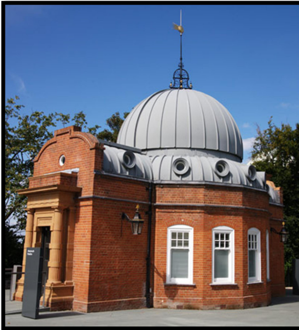
Pabellón Altazimut tras la construcción, tras la II Guerra Mundial y en la actualidad.
