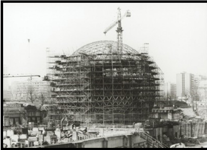
Estructura en construcción y detalle de los tubos y los nudos.
