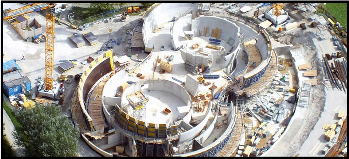
Construcción de ESO Supernova.
