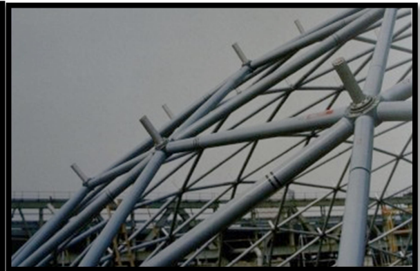
Estructura en construcción y detalle de los tubos y los nudos.
