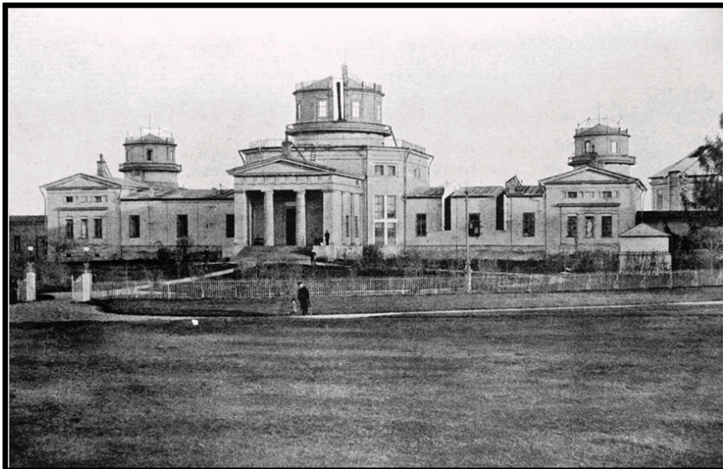
Fachada principal del observatorio hacia 1889, se observan las torres cilíndricas y las galerías intermedias con las rendijas para los telescopios de tránsito y los círculos meridionales.
