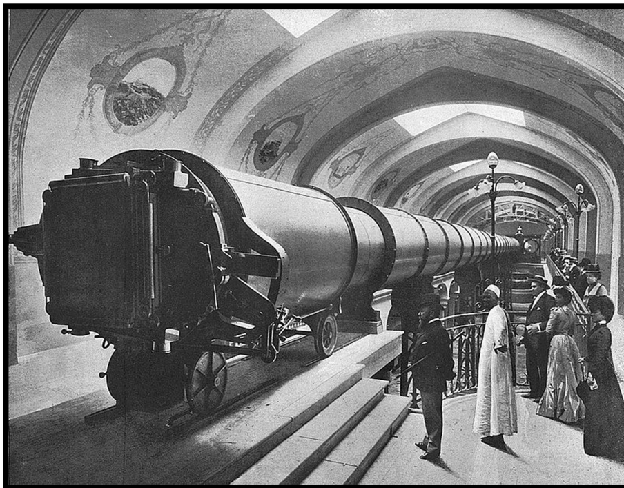
Extremo final del telescopio desde la galería superior, las ruedas de la última sección y un fuelle permitían enfocar la imagen.
