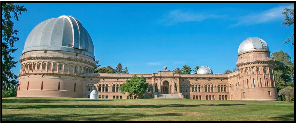
Fachada Sur del observatorio
