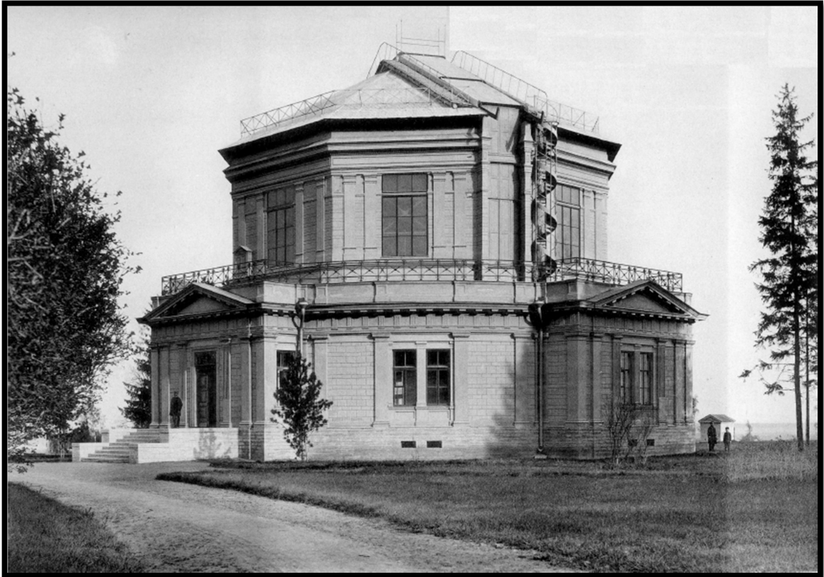
Exterior del edificio del telescopio de 30 pulgadas.
