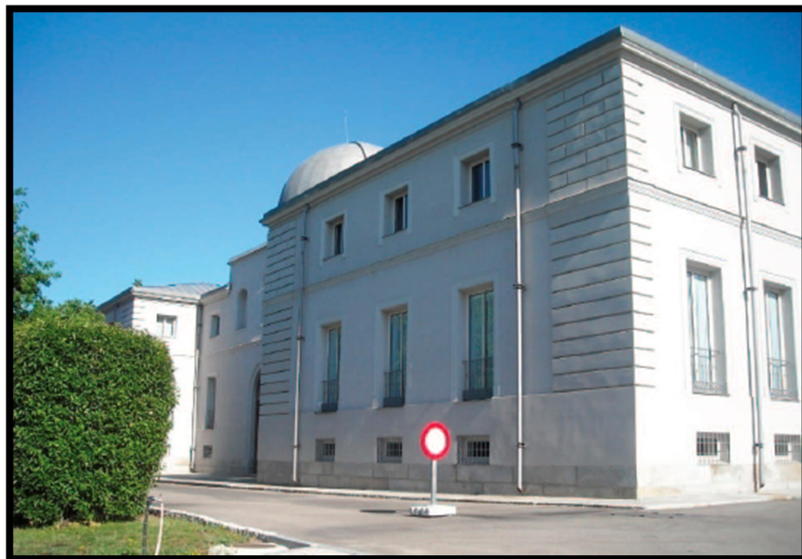
Ala Este y acceso central del edificio del Gran Ecuatorial.
