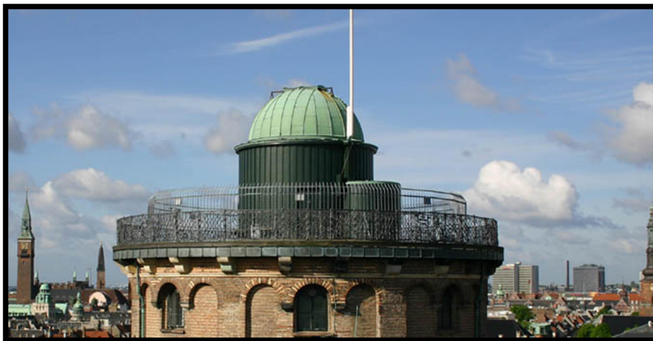
Estado actual de la cubierta con las nuevas instalaciones.
