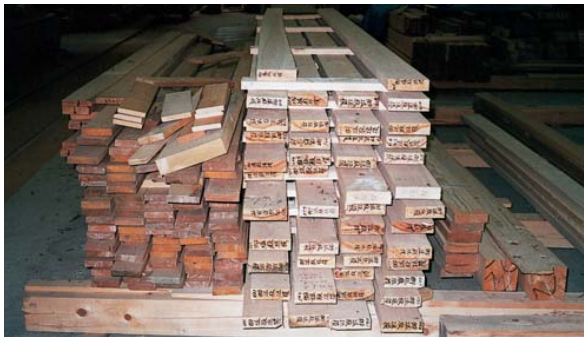
Fig 68. Piezas ya cortadas para la reconstrucción del santuario con su destino escrito en la sección.
