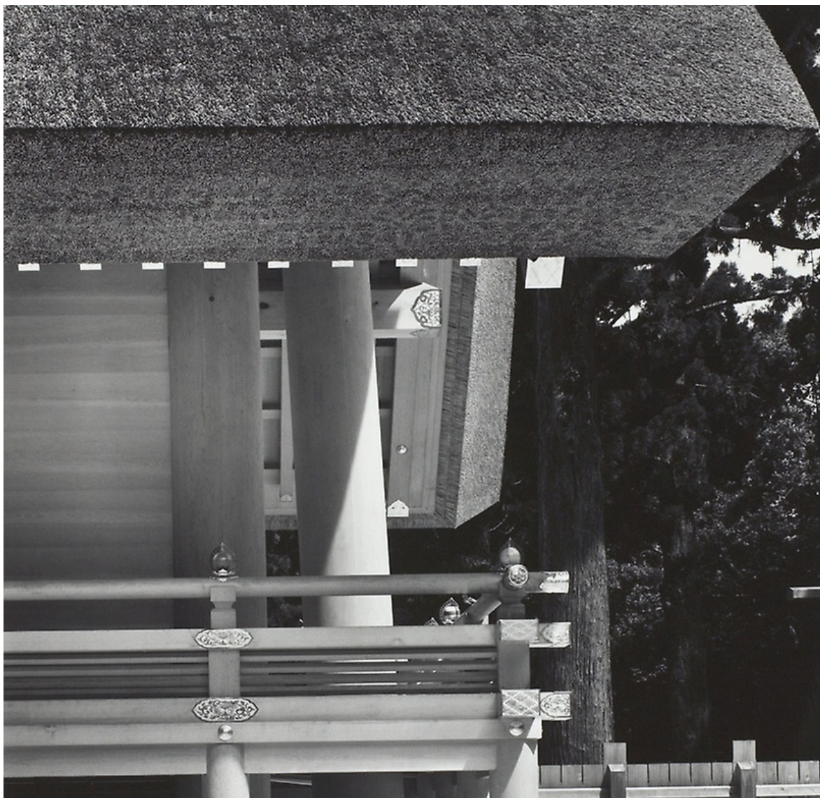
Fig 62. Santuario de Ise; vista en detalle del honden del santuario interior. Se aprecia el pilar muna-mochi-bashira exento atravesando la veranda. Fuente: Tange, Kenzo, Noboru Kawazoe, y Yoshio Watanabe. Ise: prototype of Japanese architecture . Cambridge: Massachusetts Institute of Technology Press, 1965.
