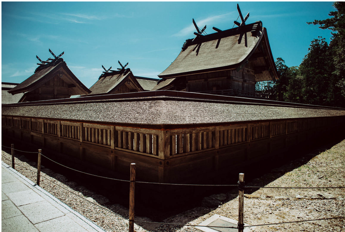
Fig 91. Santuario de Izumo, reconstrucción de 1744; vista del honden desde la valla exterior. Fuente: https://flic.kr/p/McY7YK
