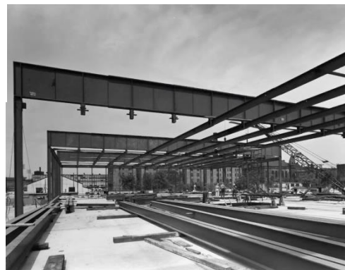
Estructura del Crown Hall en construcción Fuente: http://arquipozcodia.blogspot.com/
