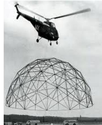
R. Buckminster Fuller: Cúpula geodésica, Carolina del Norte 1951. Helicóptero transportando una cúpula.
