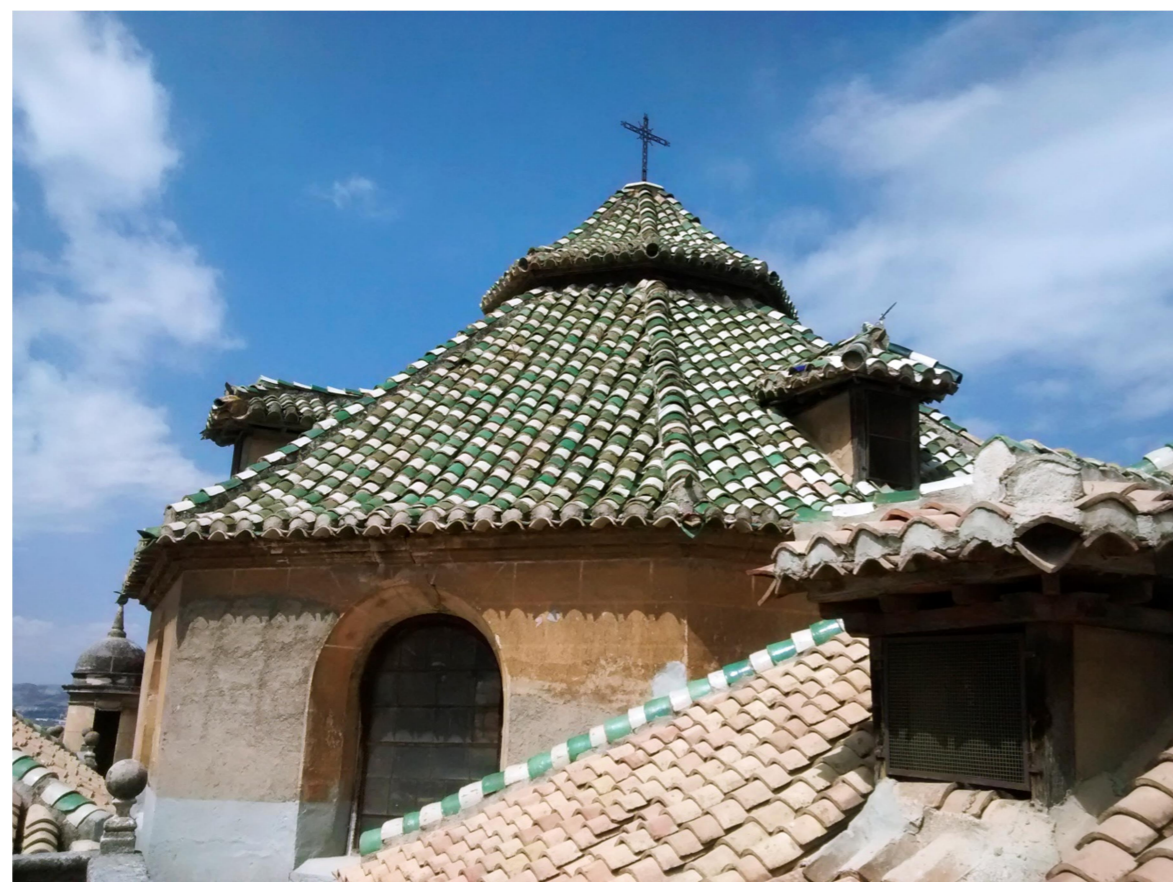
Figura 63: Acabado exterior de la cúpula con teja cerámica vidriada. Fuente: Elaboración propia.
