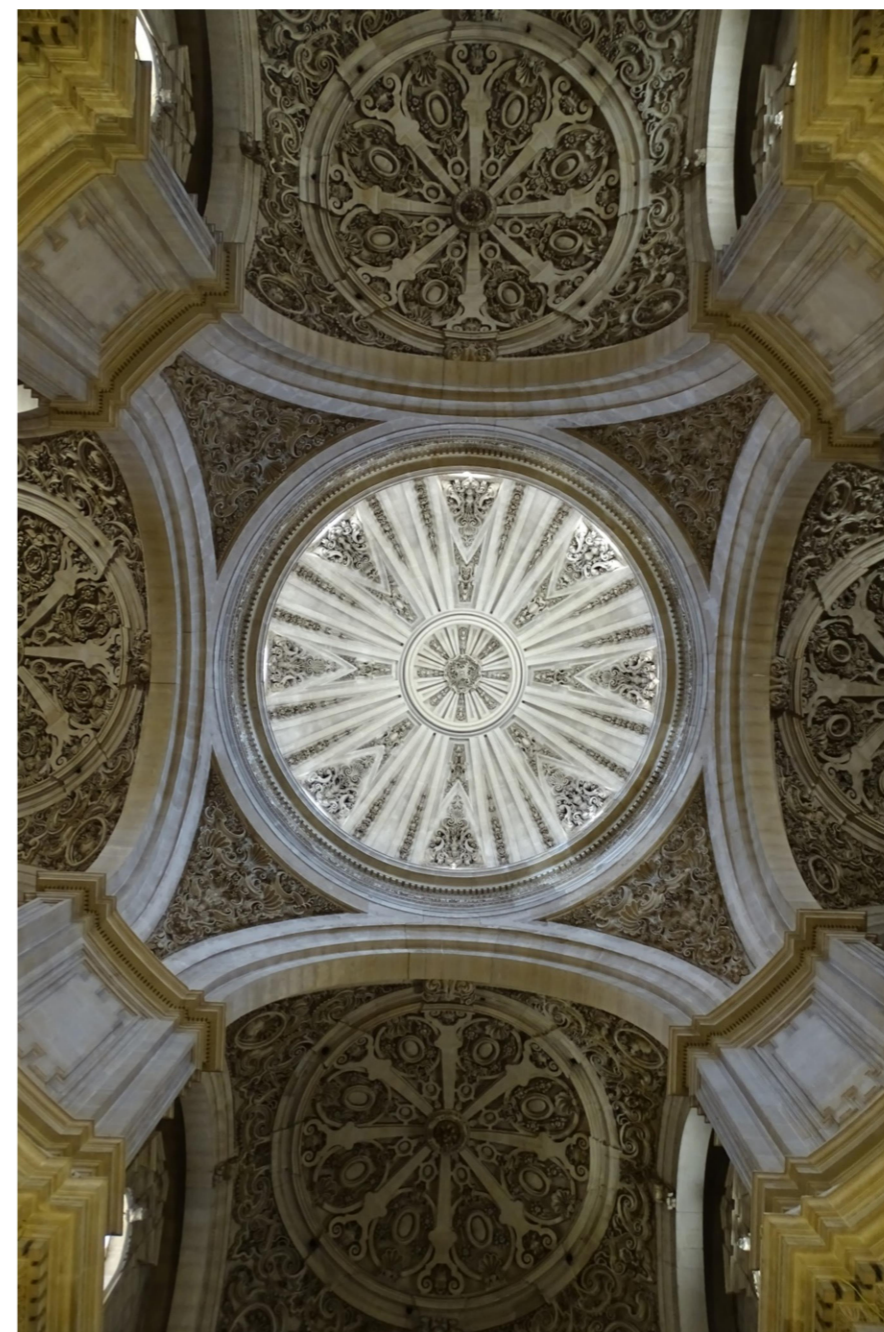
Figura 15: Cúpula central sobre pechinas. Fuente: Elaboración propia.
