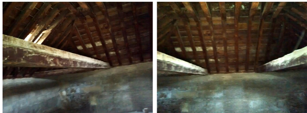
Figura 44: Vistas de las armaduras de cubierta de una de las cúpulas laterales a través del respiradero. Fuente: Elab. propia.
