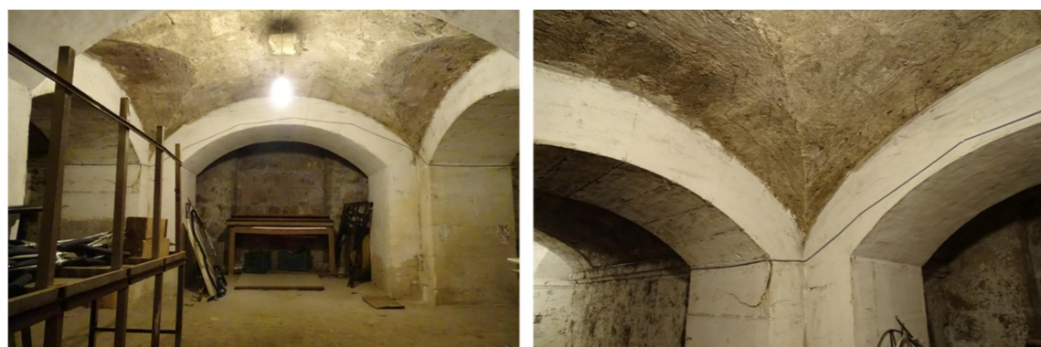
Figura 42: Refuerzos de la bóveda de la cripta situada bajo el tabernáculo. Fuente: Elaboración propia.
