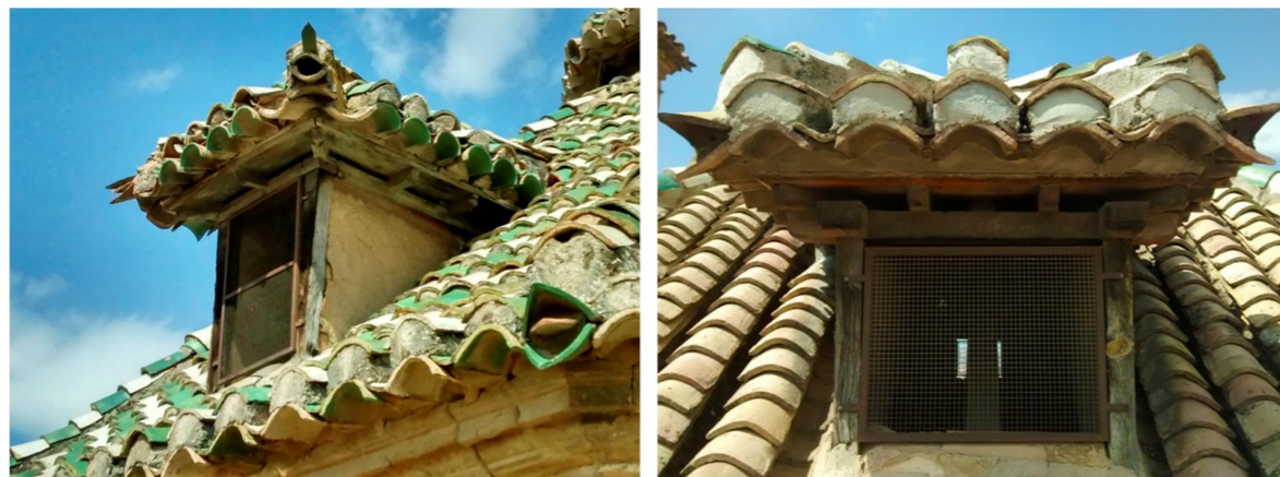
Figura 48: Detalle de respiraderos de las cubiertas. Cúpula principal (izda.) y cúpula lateral (dcha.). Fuente: Elaboración propia.
