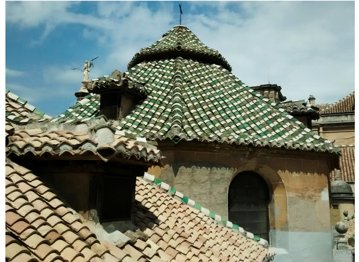
Figura 49: Cubierta vidriada de la cúpula principal. Fuente: Elaboración propia.
