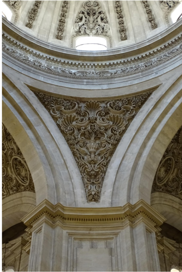
Figura 16: Detalle de una de las pechinas. Fuente: Elaboración propia.
