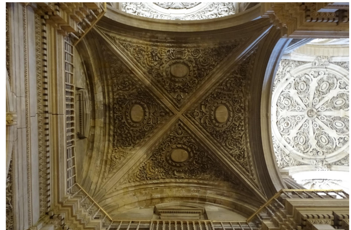
Figura 19: Detalle de una de las bóvedas de arista. Fuente: Elaboración propia.
