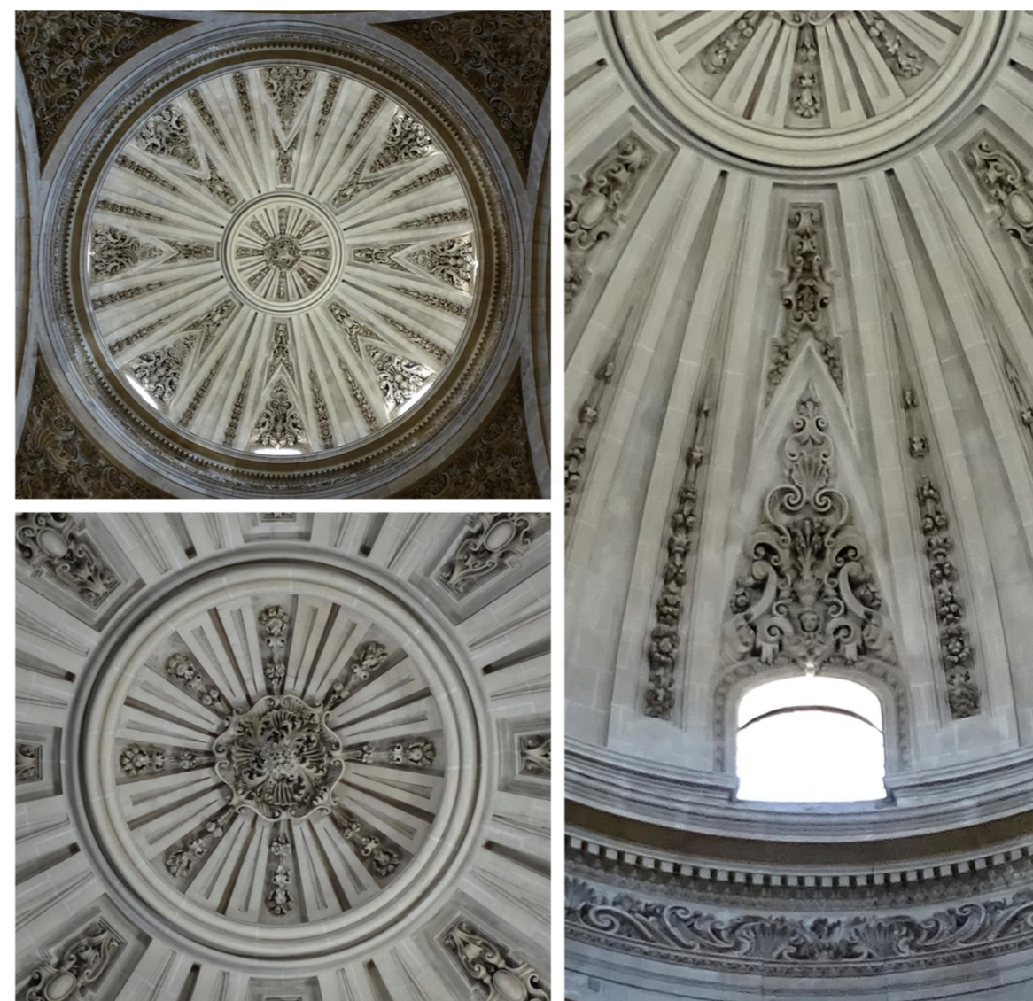
Figura 64: Detalles de las yeserías del acabado interior de la cúpula. Fuente: Elaboración propia.
