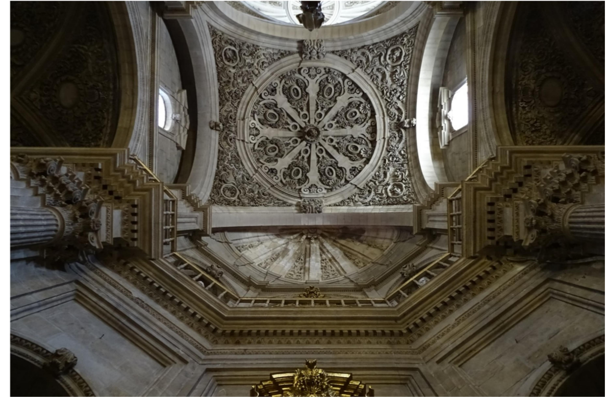
Figura 18: Detalle de una de las bóvedas vaídas y de la bóveda de cuarto de esfera de una de las capillas. Fuente: Elab. propia.
