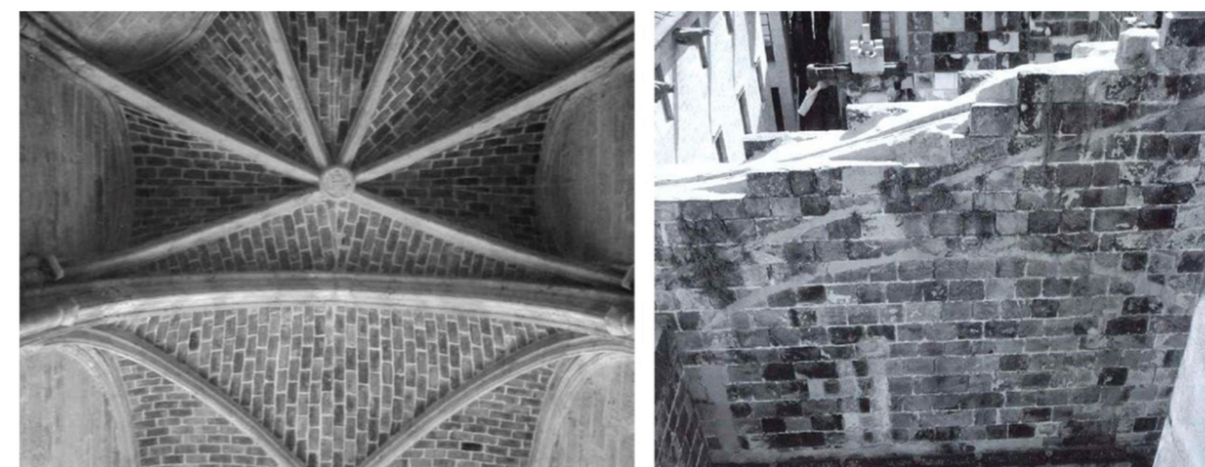
Figura 32: Bóvedas de la capilla de los Jofre (Izda.) y Huella de bóveda en la catedral de Barcelona (Dcha.). Fuente: Esther Redondo Martínez, Tesis Doctoral, p.26-27.
