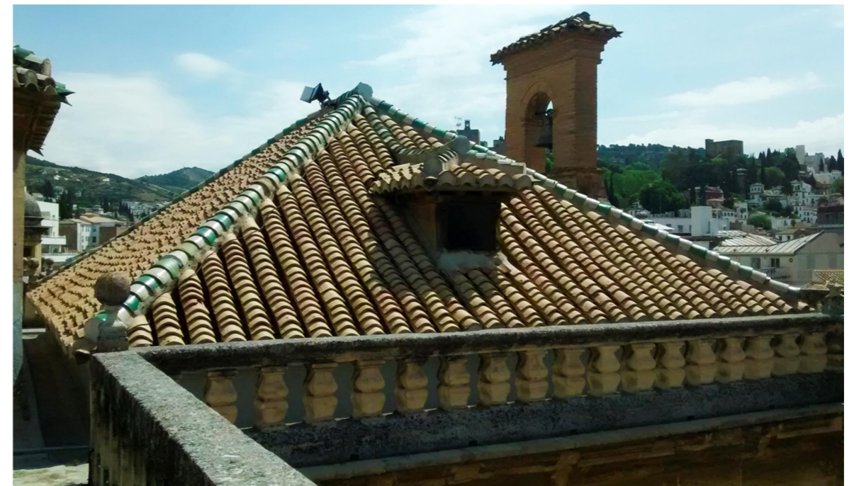
Figura 50: Cubierta cerámica de una de las bóvedas laterales. Fuente: Elaboración propia.
