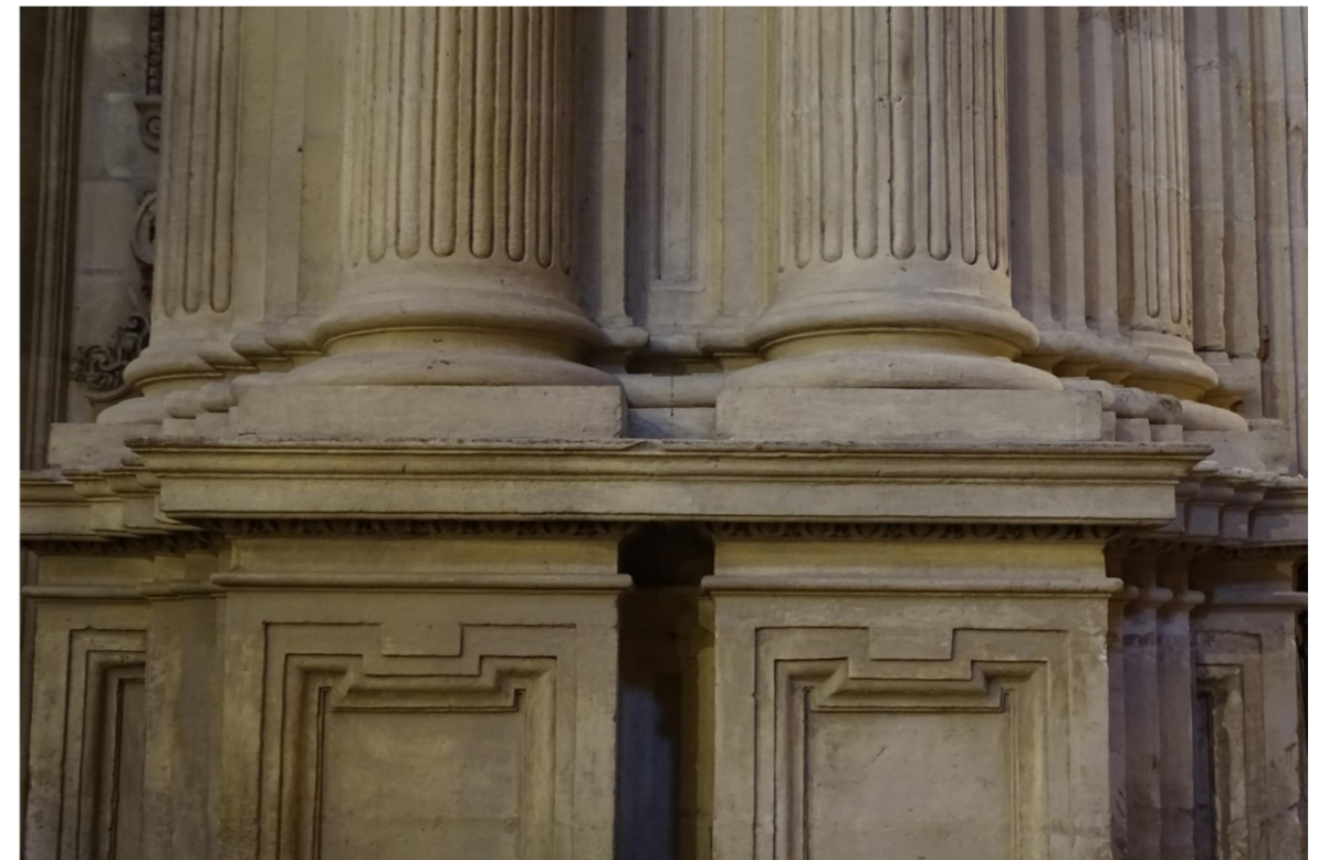
Figura 18: Detalle de las basas de los soportes centrales. Fuente: Elaboración propia.
