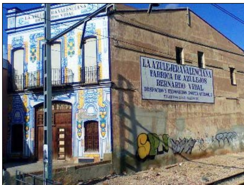
Figura 11. Fábrica de azulejos Bernardo Vidal.
