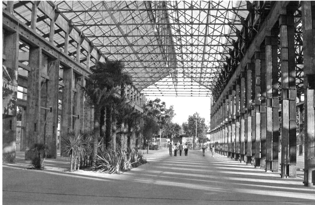
Fig. 34. Hall de Les Machines. Dossier de Presse: Les Nerfs de la Loire . 2005/207. ILE DE NANTES(44). http://www.alexandre-chemetoff.com/
