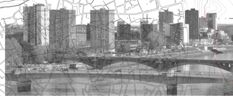
Desarrollo residencial del barrio de Malakoff, en donde se sitúa la estación de tren
