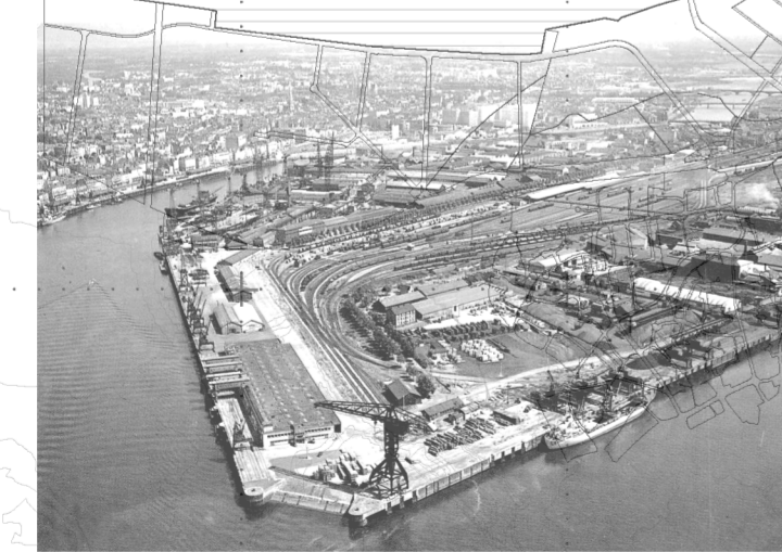
Gran zona industrial que cayó desuso a finales de siglo tras su gran auge en el siglo XX
