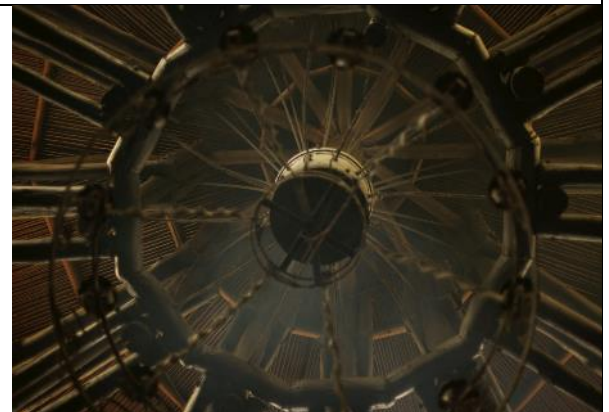
Figura 8.3 Vista de la estructura del techo Fuente: Equipo de Registro Audiovisual.
