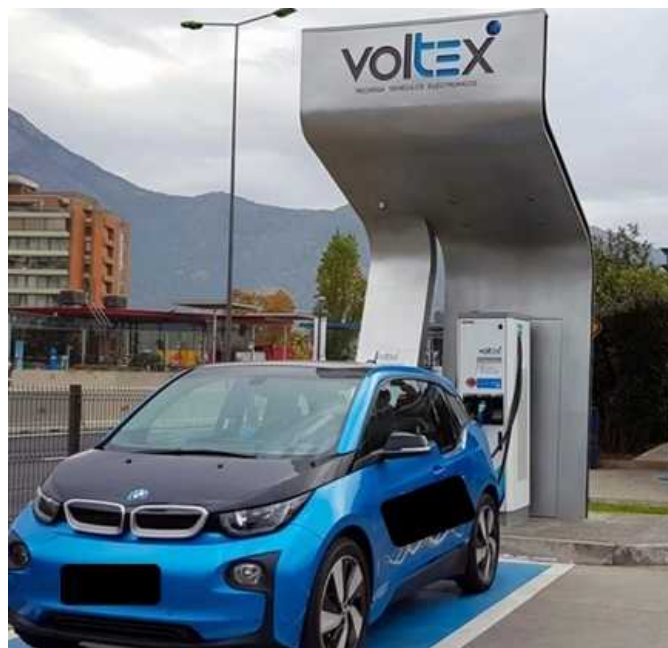
Imagen 78: Estación de recarga de VEs VOLTEX; fuente, COPEC-VOLTEX.
