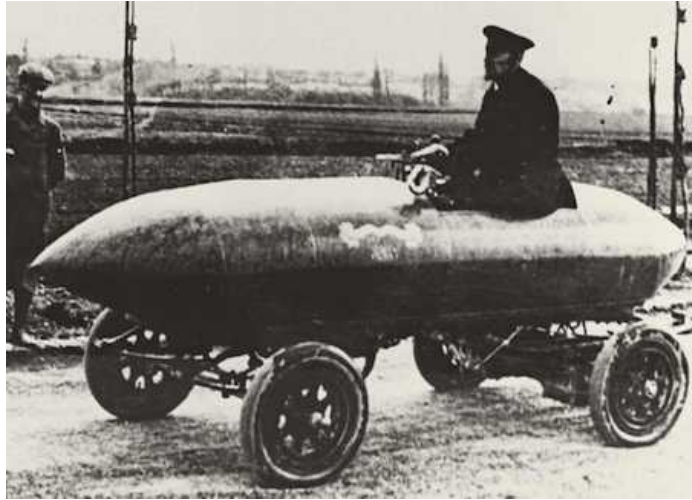
Imagen 10: Automóvil eléctrico “ Jamais Contente ” desarrollado en 1899; poseía una carrocería de aleación ligera en forma de torpedo, con el cual se logró superar por primera vez los 100 km/h.; fuente, www.lautomobileancienne.com
