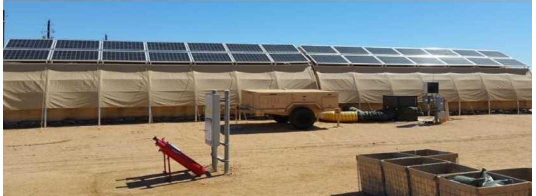
Imagen 92: Microplanta de generación de energía fotovoltaica de despliegue rápido de la Fuerza Aérea de los Estados Unidos de América; fuente, NATO (2015).
