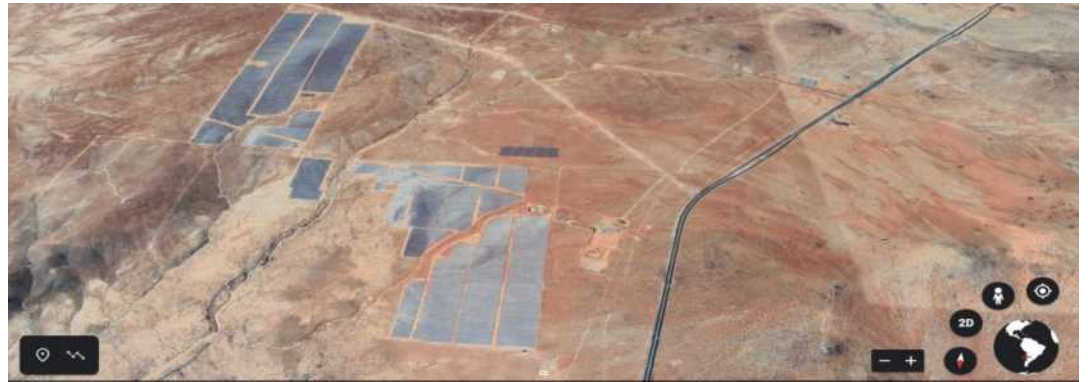
Imagen 89: Planta fotovoltaica “ El Romero ”, genera 196 MW, la mayor de Latinoamérica, ubicada en el desierto de Atacama, 29^{\circ}06'09''\text{S} 70^{\circ}55'36''\text{W} ; fuente, Google Earth.
