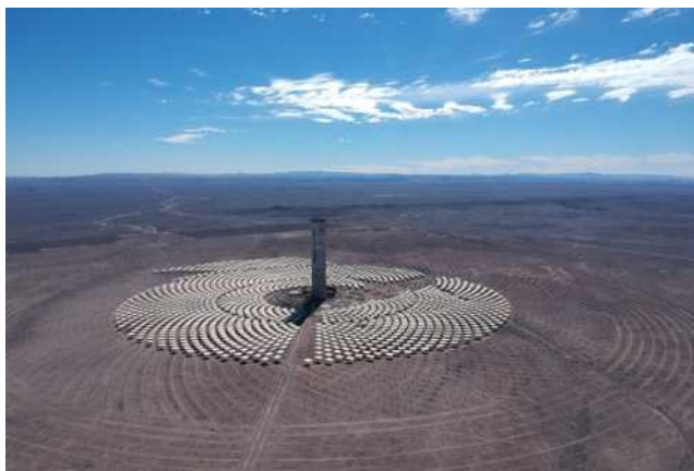
Imagen 87: Planta de concentración solar y de almacenamiento termal (CSP-TES) “Cerro Dominador”; fuente, www.pv-magazine-latam.com
