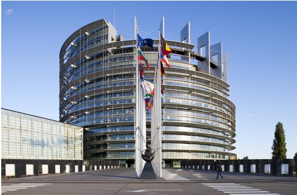
Pie de foto: “Torre inacabada”.
