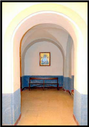
Fig.375. Estado actual de la antigua Capilla del Señor del Rescate. Foto: autor.
