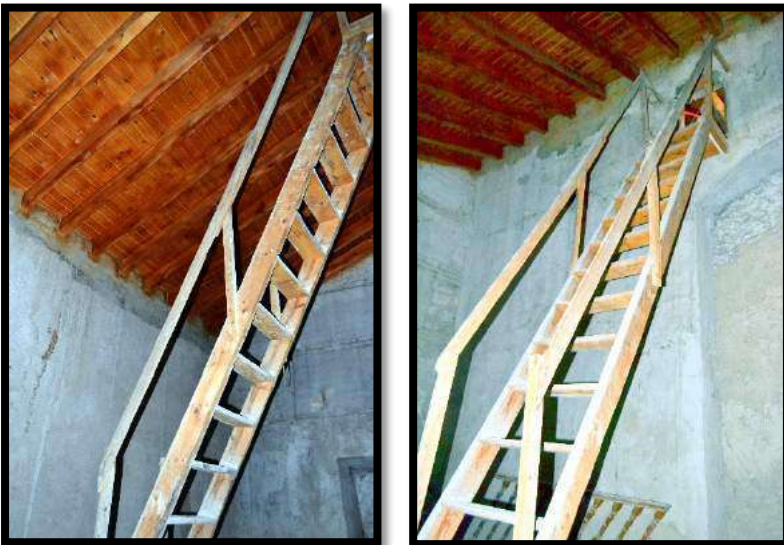
Fig.406. Dependencia previa a las cubiertas de la iglesia, con la pronunciada escalera de subida. Al fondo, puede verse tapiado uno de los vanos adintelados que comunicaban con las antiguas casas congregacionales. Foto: autor.
