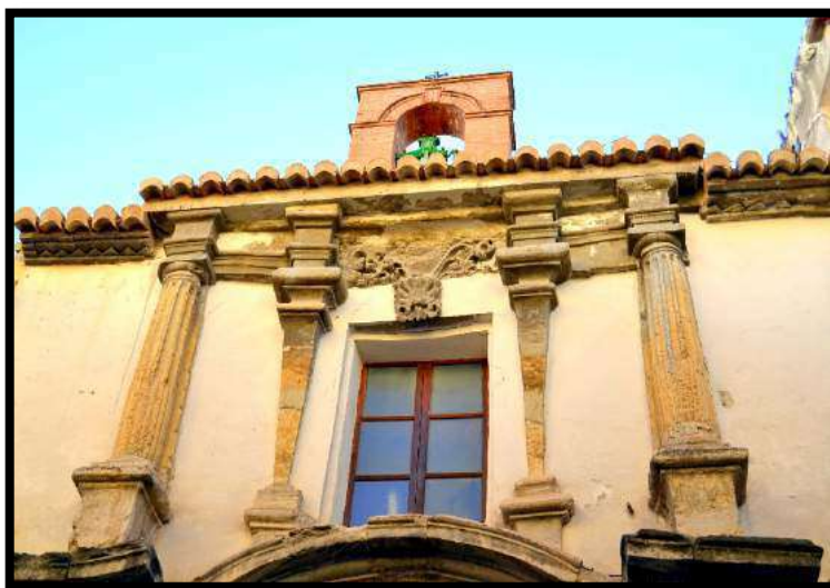
Fig.359. Detalle y estado actual del segundo cuerpo de la portada de la Iglesia de los Dolores de Baza. Foto: autor.
