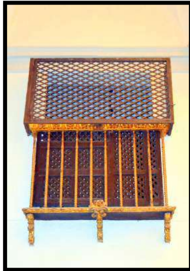
Fig.384. Celosía que cierra el balcón que comunica el brazo de la Epístola del crucero con la Palacio Episcopal . Foto: autor.
