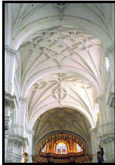
Fig.117. Ambrosio de Vico, Bóvedas de la nave central de la Catedral, Granada, 1582-623. Foto: autor.
