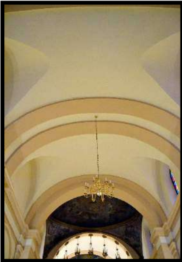
Fig.493. Vista de las sencillas bóvedas de lunetos que cubren la nave y que mantienen oculta la armadura mudéjar. Foto: autor.
