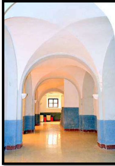
Fig.374. Vista longitudinal de las capillas de la nave colateral del Evangelio. Foto: autor.
