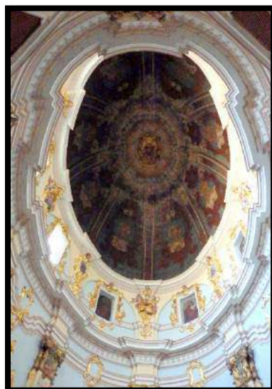
Fig.54. Detalle de la bóveda que cubre la planta elíptica del Oratorio conquense. Foto: autor.
