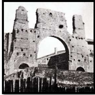
Fig.438. Fotografía que muestra las ruinas que subsistían de la Casa de la Anunciación tras la Guerra Civil. Fuente: col. part.
