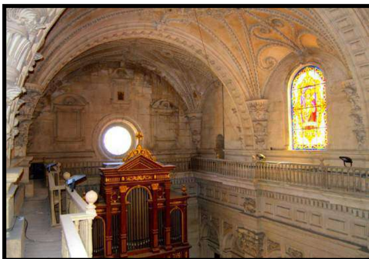
Fig.179. Arranque de las bóvedas centrales y luneta sobre el pasillo de las tribunas. Foto: autor.
