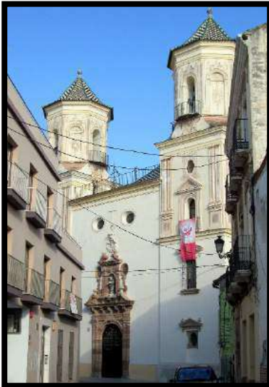
Fig.56. Fachada principal del Oratorio malagueño, modificada por Ventura Rodríguez en 1778. Foto: autor.
