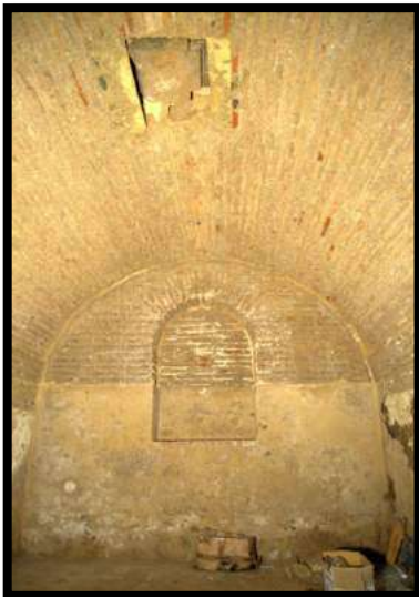
Fig.210. Capilla ubicada a los pies de la cripta con un respiradero practicado en su techo. Foto: autor.
