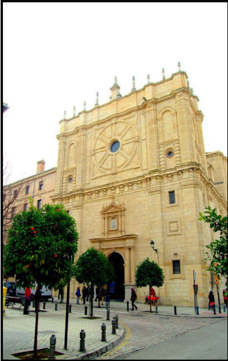
Fig.132. Vista del estado actual de la fachada principal del Santuario del Perpetuo Socorro . Foto: autor.
