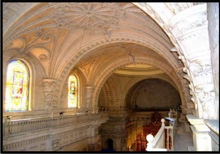
Fig.165. Vista de la bóveda central de la nave desde sus arranques, a la altura de la cornisa. Foto: autor.
