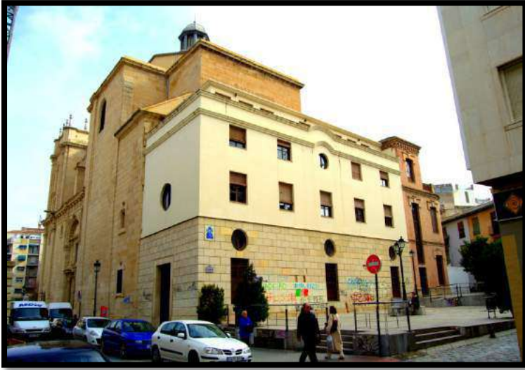
Fig.253. Estado actual de las estructuras de la sacristía y el camarín, tras las que se abre la plaza Luis Portero García, espacio que otrora encerrase el patio de los Carros y otras dependencias auxiliares del Oratorio. Foto: autor.
