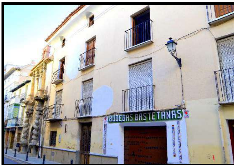
Fig.413. Estado actual de la fachada principal del Palacio Episcopal de Baza, junto a la Iglesia de los Dolores . Foto: autor.
