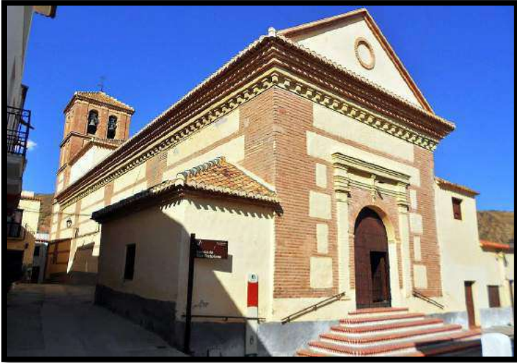
Fig.475. Autor desconocido, Fachada de la Iglesia de San Blas , principios del siglo XIX, Cherín. Foto: autor.
