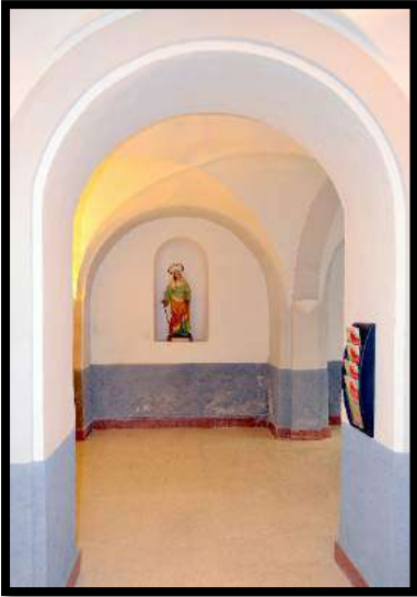
Fig.381. Estado actual de la antigua Capilla de San Cayetano. Foto: autor.
