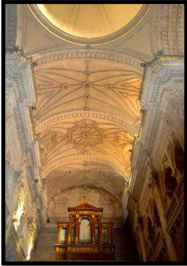
Fig.162. Sistema de bóvedas de la nave central. Foto: autor.
