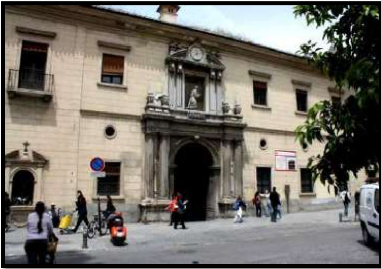
Fig.88. Autor desconocido, Fachada principal del Hospital de San Juan de Dios , Granada, 1553-609. Foto: autor.
