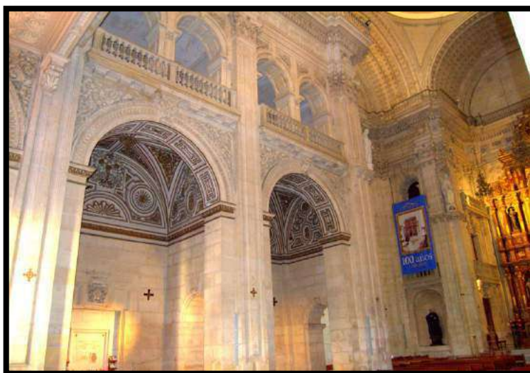
Fig.175. Vista del cuerpo inferior del colateral del Evangelio. Foto: autor.
