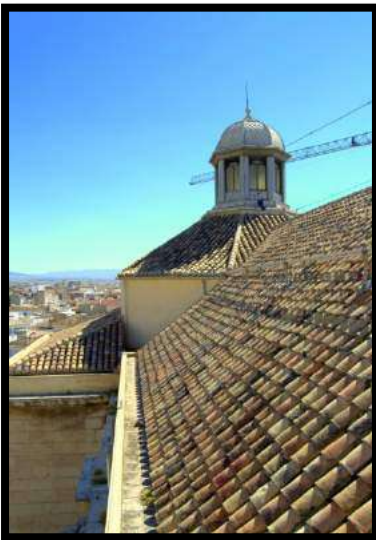
Fig.188. Vista exterior de la cúpula decimonónica con la linterna de principios del siglo XX. Foto: autor.
