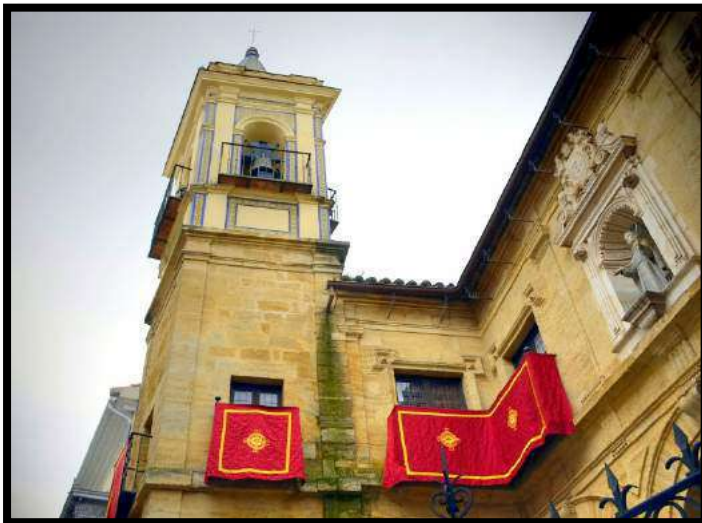
Fig.105. Melchor de Aguirre, Torre de la Iglesia de San Francisco Solano , Montilla, 1681. Foto: autor.
