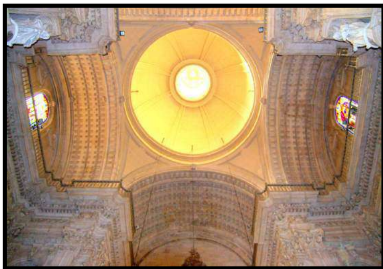
Fig.183. Estado actual de la cúpula y bóvedas del transepto. Foto: autor.
