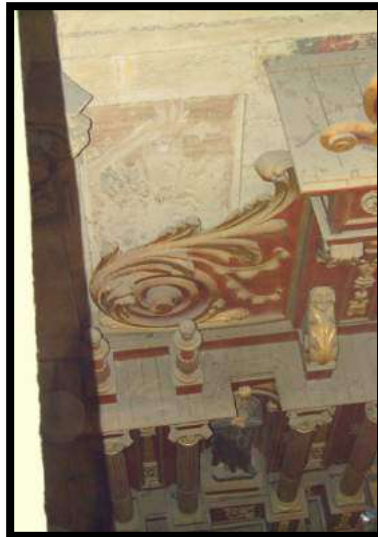
Fig.202. Restos del ornato de la antigua capilla mayor felipense, tras el actual retablo mayor. Foto: autor.
