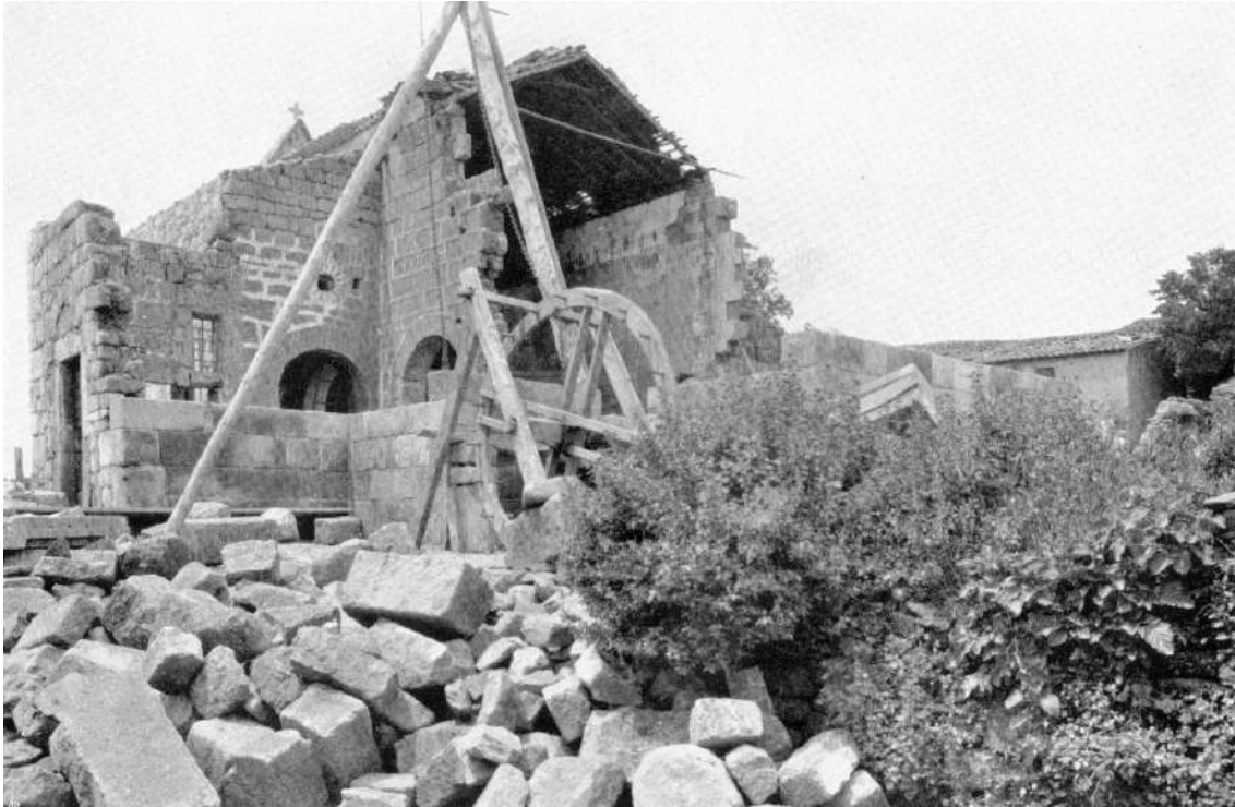
Ilustración 2. Vista del desmonte de Lourosa desde el sureste (Barreiros, 1934: Est. 40).
