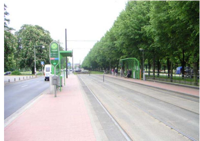
Aquí la línea H de tranvía que acaba de salir de túnel –al fondo de la fotografía-. Estas calles anchas y verdes ofrecen hermosos paisajes al M.L. en superficie. En calles estrechas este atractivo desaparece.
