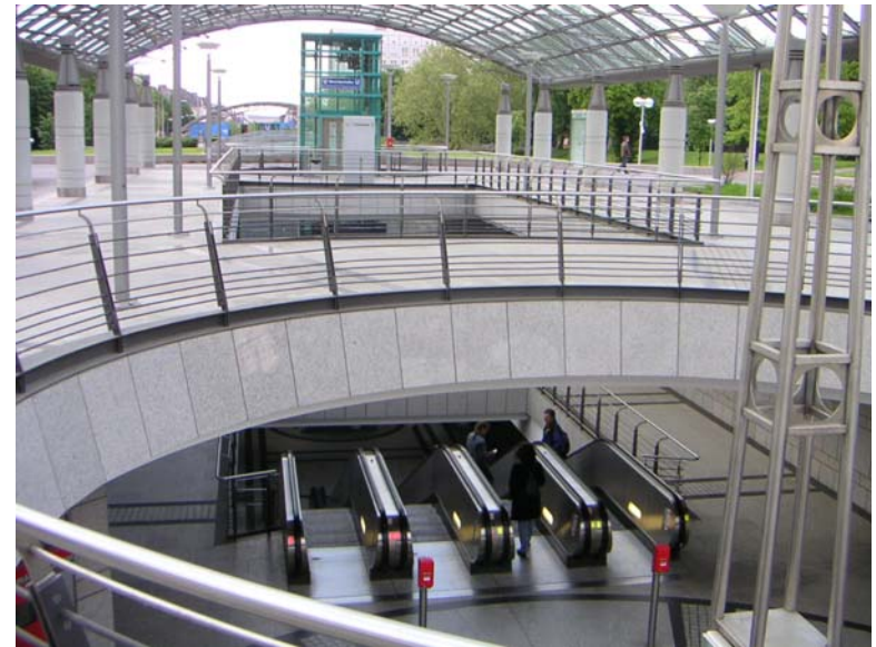
La luz natural llega al andén en estación del Metro de Dortmund.
