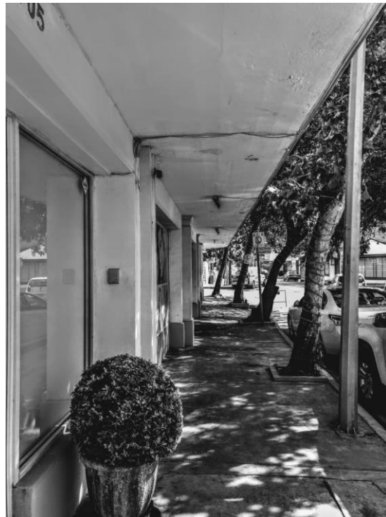
Figura 4: Edificio Hacienda María Luisa (1938), Monterrey. Fotografía de las accesorias y espacio público aledaño Fuente: A. Canavati Espinosa (2018)
