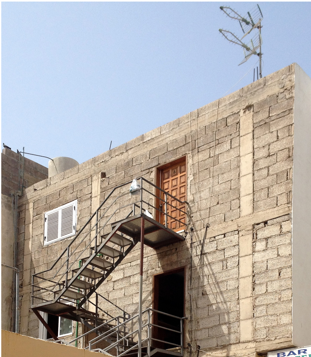
Figura 2: Edificio "a bloque visto" Fuente: E. Martín del Toro (2018)
