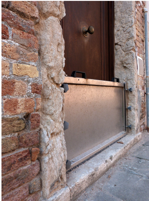
Figura 3: Paratie en fondamenta Alberti Fuente: F.A. García Pérez (2018)
