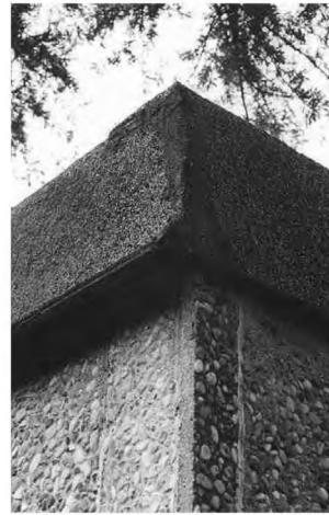
Figura 5.1: Unión de paneles verticales en esquina
