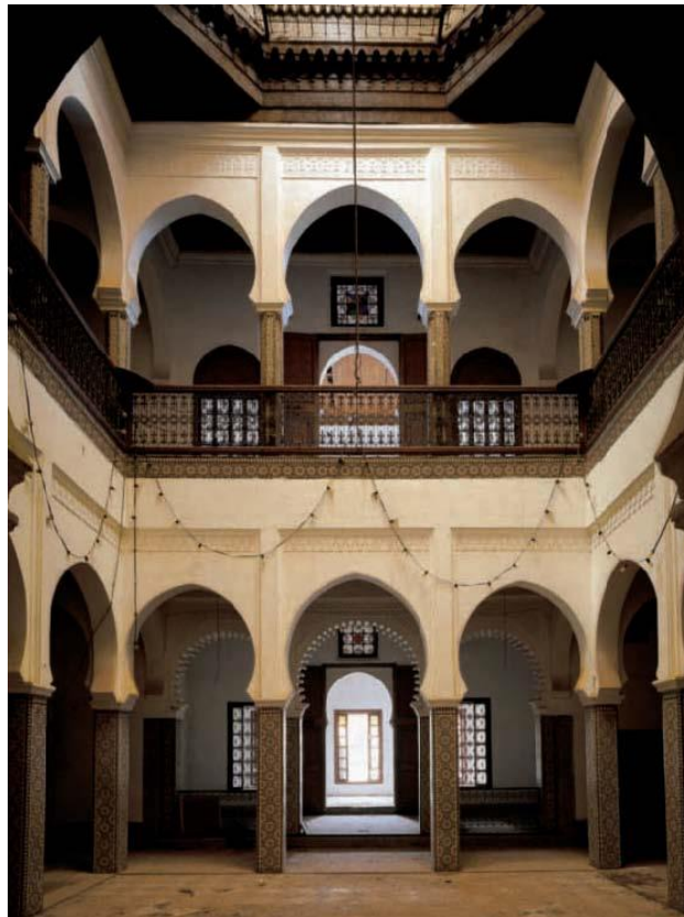
Figura 5: Casa Abdeluahid Bricha, Medina de Tetuán. La doble altura del patio se resuelve con arcos de descarga sobre pilares de ladrillo, ricamente decorados; el techo con armadura de madera, ochavando el hueco
