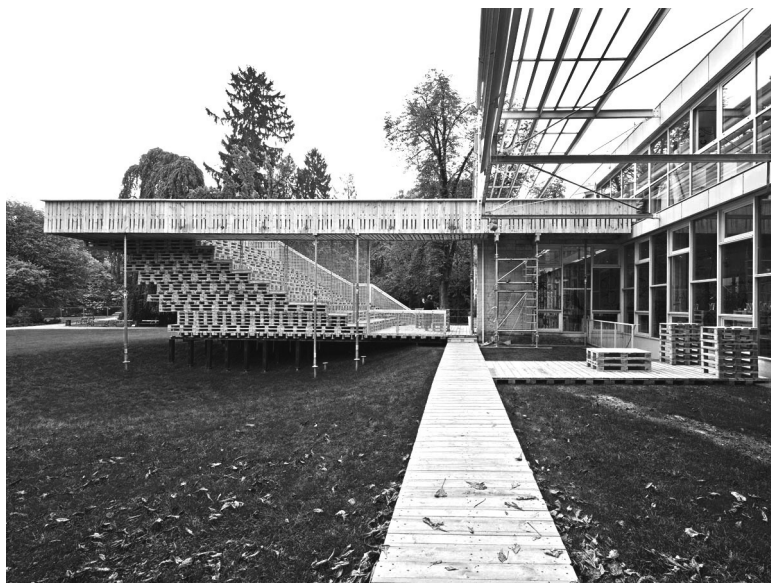
Feld72, Ampliación del Forum Stadtpark para el Steirischer Herbst , Graz, 2010. Graderío en fachada este (Fuente: Imagen de Hertha Hurnaus)
