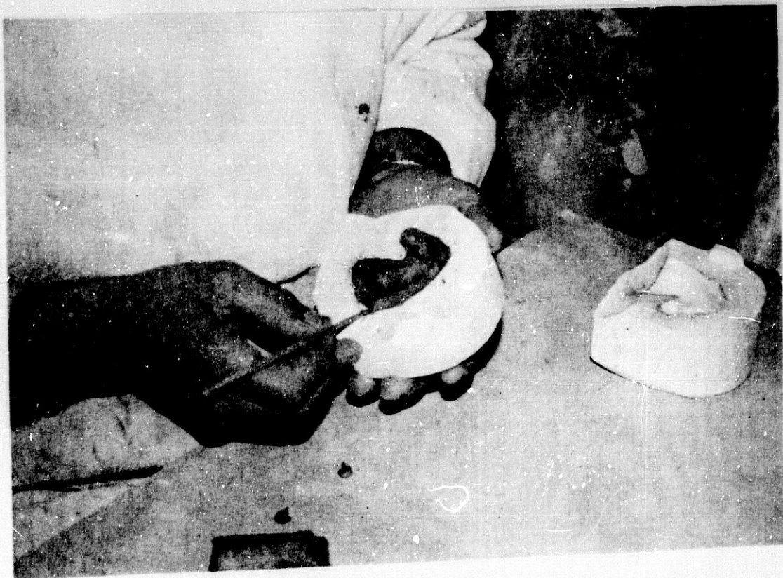
d -. Corte lateral para permitir la salida del molde.
