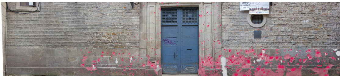
Ilustración 4: Dibujo de los impactos de metralla sobre la fachada A de la iglesia de Sant Felip Neri. Fuente: Elaboración pròpia.
