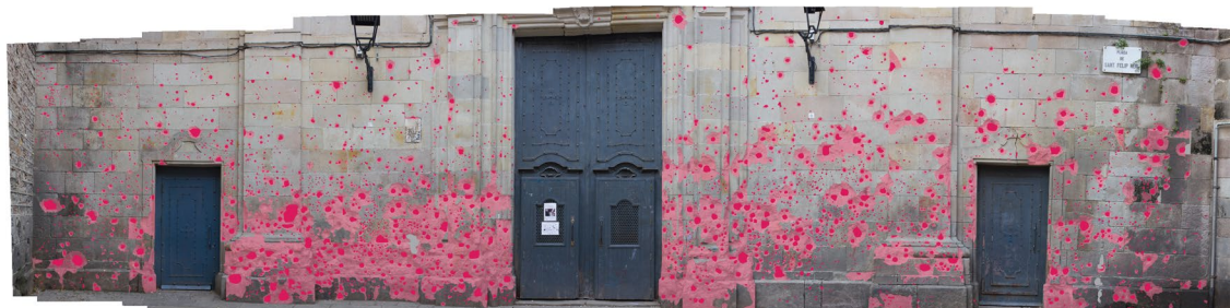
Ilustración 6: Dibujo de los impactos de metralla sobre la fachada B de la iglesia de Sant Felip Neri. Fuente: Elaboración propia.
