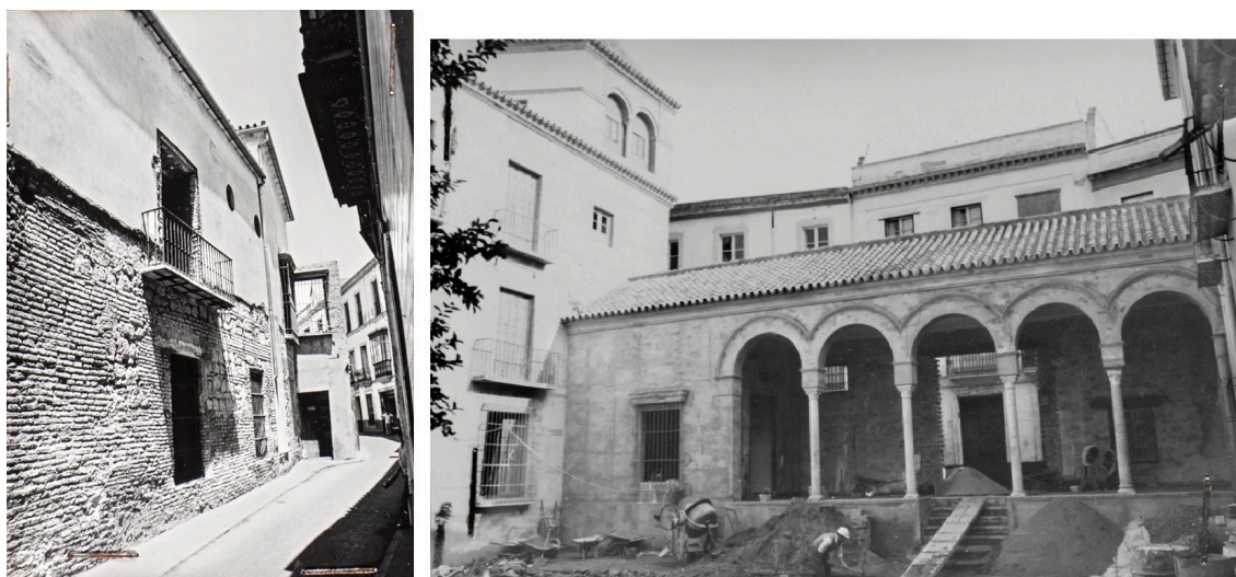
Ilustración 05. Obra en la fachada de la Casa de Pinelo hacia la c/ Abades, y construcción del pórtico de la crujía de calle del jardín de la casa, que sirve de acceso exterior a la Real Academia de Medicina. (IAPH, BECERRA FONDO, 28-3-3 y 28-29-1).
