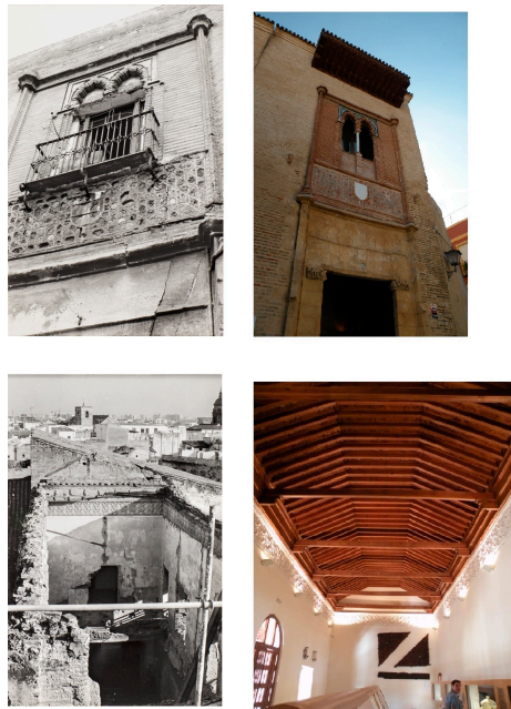
Ilustración 10. Portada del palacio de los Marqueses de la Algaba y sala de la crujía norte del palacio anteriores a la intervención de Manzano (IAPH, BECERRA FONDO, 10 02 03 y 10 11 08), e imágenes tras la actual rehabilitación integral.
