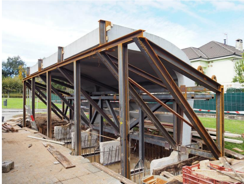
Ilustración 5: La marquesina y su cimentación, en su nueva ubicación, con la estructura metálica construida para su izado. Elaboración propia.
