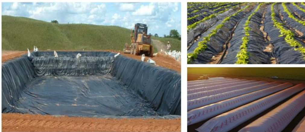
Figura 30. Ejemplo de empleo de polietileno como geomembrana en impermeabilización y distintos usos agrícolas.
