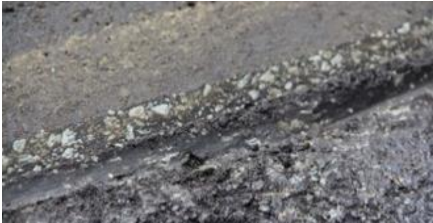
Figura 19. Ejemplo de pavimento con betún modificado con resina epoxy empleado en el puente San Francisco-Oakland SAS Bay. (Fuente: ChemCoSystems)
