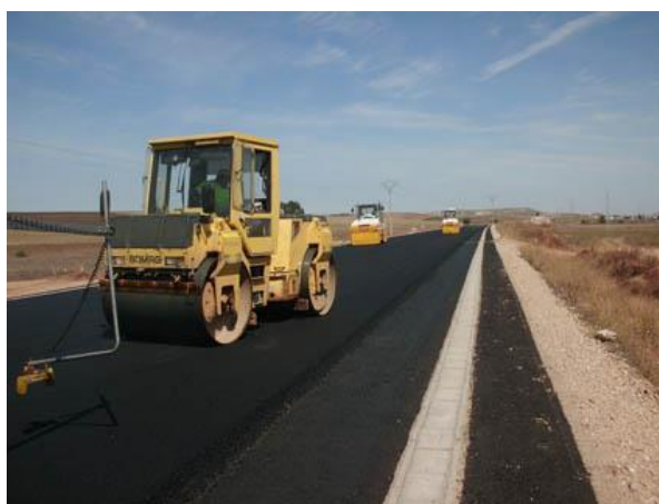
Figura 7. Puesta en obra de subbalasto bituminoso en el subtramo de plataforma de alta velocidad Villodrigo (Palencia)-Villazopeque (Burgos) (Fuente: ADIF).
