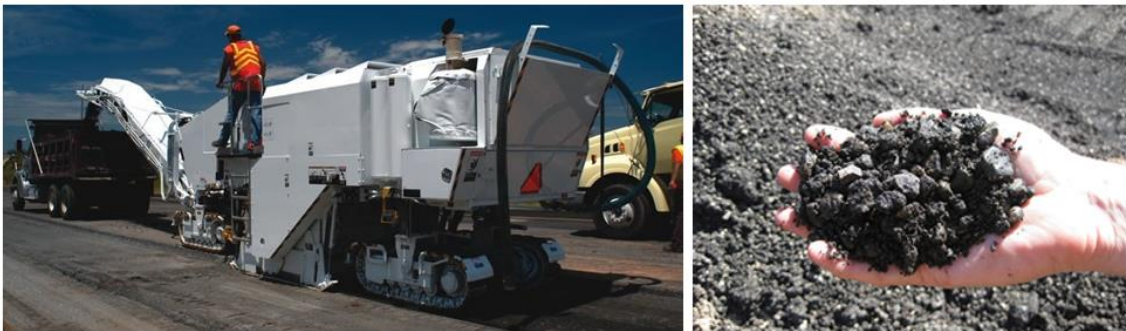
Figura 24. Fresado de carreteras y material fresado obtenido.
