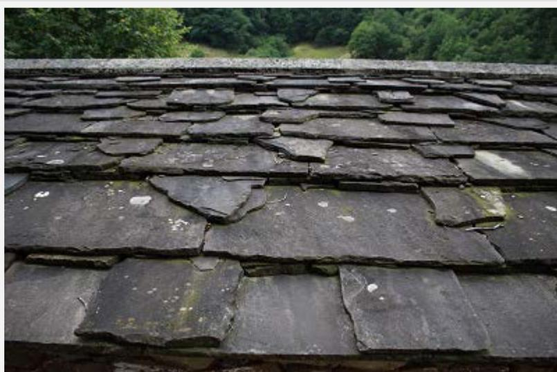
Fig. 13. Detalle de un arquetípico tejado de lastras, en Yera (Vega de Pas).
