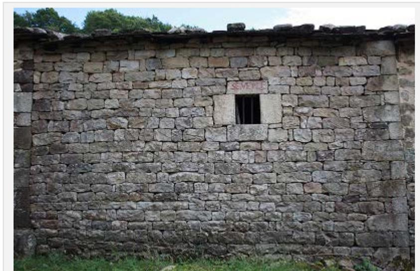
Fig. 11. Muro de carga con piedra seca en Rucabao (Vega de Pas).
