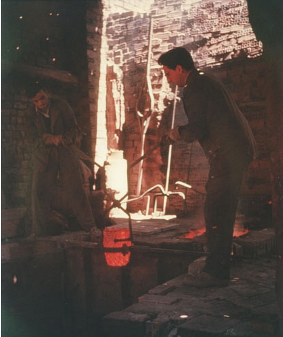
Fig. 4.15. Proceso de fundición artística en coca, colocando el crisol en el mineral. Eduardo Capa y José Murciego. Año 1957. Toda su experiencia previa fue de gran importancia para incorporar la fundición artística a la docencia reglada. Imagen tomada de: http://capaesculturas.com/fundicion/historia/english/
