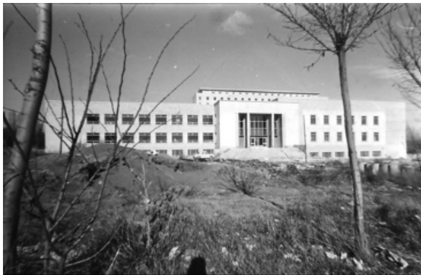
Fig. 4.12. Construcción de la Escuela de Bellas Artes y la Academia de San Fernando en 1966. ARCM, Fondo Fotográfico Martín Santos Yubero. Imagen adaptada de: http://open.ieec.uned.es/HussoDigital/wp-content/uploads/UCM/18BellasArtes/2BELLAS%20A%201966%20SY24813_003.jpg
