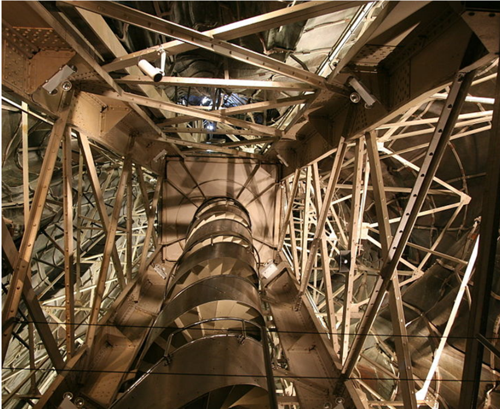
Fig. 2.66. La estructura interior de la Estatua de la Libertad. Frédéric Auguste Bartholdi. Hierro. (1875-1886). 93 m de altura aproximadamente, peso de 225 toneladas. La Isla de Bodloe. Tomada de: https://www.tes.com/lessons/l1K0qhVUhaU6wA/statue-of-liberty-engineer-challenge .
