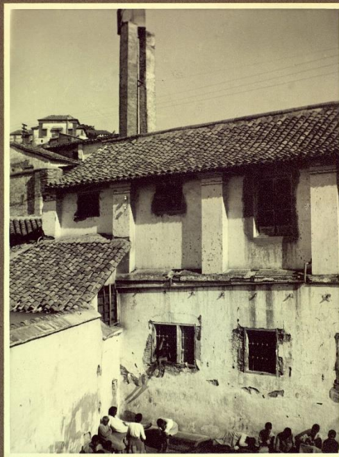
Unos de los edificios destruidos en el barrio de los obreros de la Fábrica de Ferrerías
