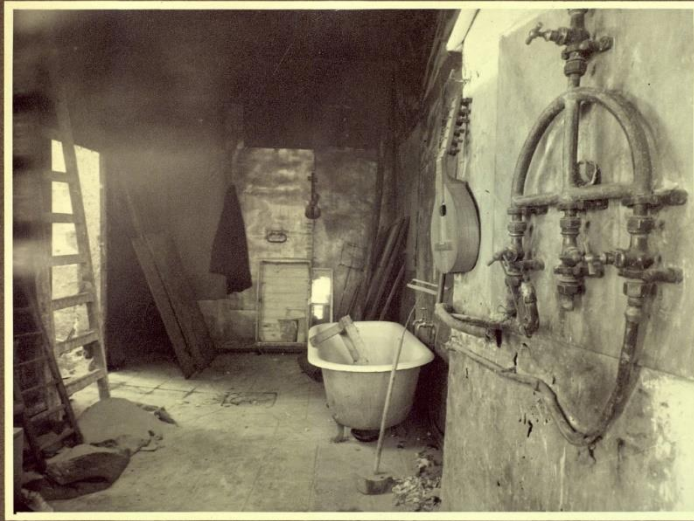
El baño de un obrero en un barrio de trabajadores desplazados
