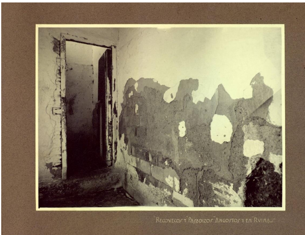
Recovecos y pasadizos angostos y en ruinas.
