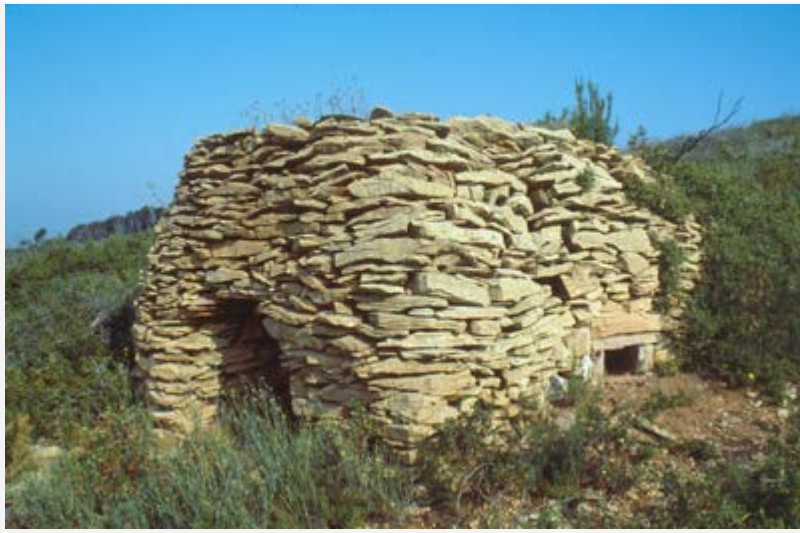
Fig. 6: Un four à cade (huile de genévrier) dans la colline varoise (Provence, France).
