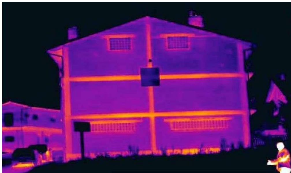
Puentes térmicos en frentes de forjado y pilares Fuente: Termagraf. Enriquealario
