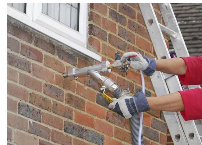
Sistema de aislamiento de fachada por inyección en cámara Fuente: Arrevol Arquitectos
