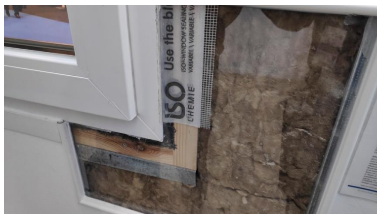
Detalle de una ventana correctamente colocada para evitar puentes térmicos Fuente: Arrevol
