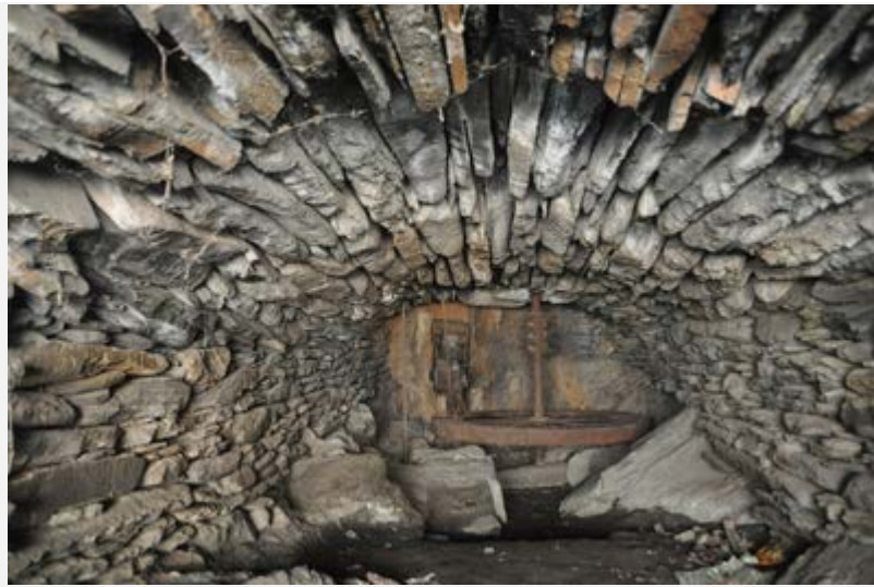
Cimbre de piedra seca para albergar el cárcavo de un molino. Almazara de Castro de Filabres.
