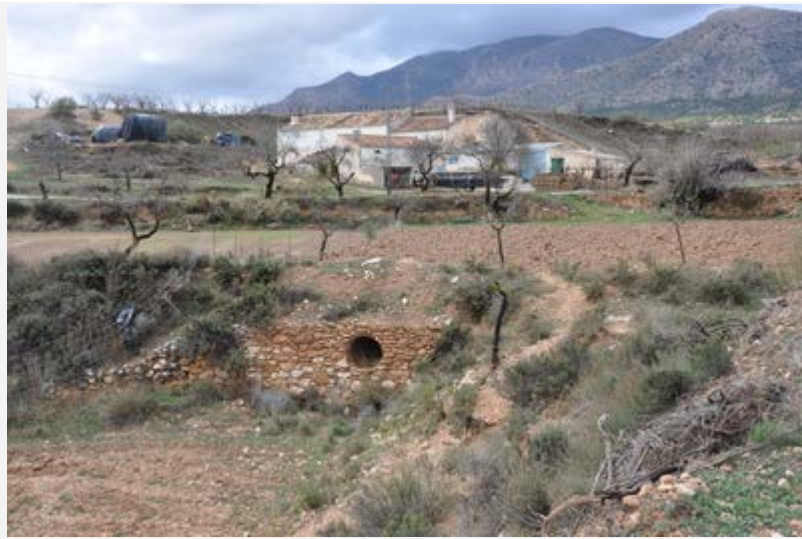
Galería de drenaje en una cañada velezana.
