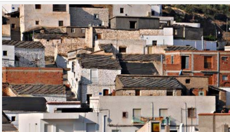
Cubiertas de aleros en recesión, Escúllar.
