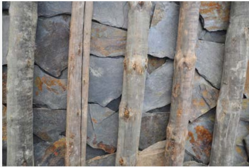
Trama del ensolado visto desde abajo.
