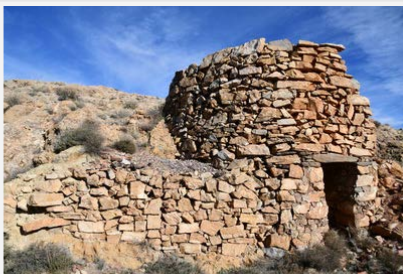
Horno de fundición reconvertido en calera, Sierra Nevada.
