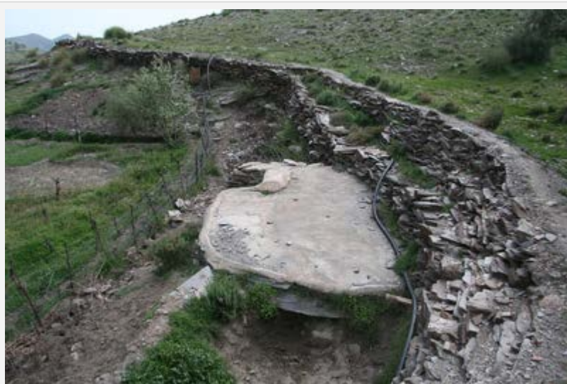
Aljibillo de barranco en Gérgal.
