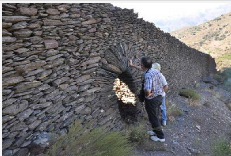
Gran muro alpujarreño con función de paravientos.
