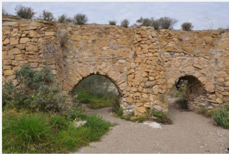
Acueducto en Carboneras.
