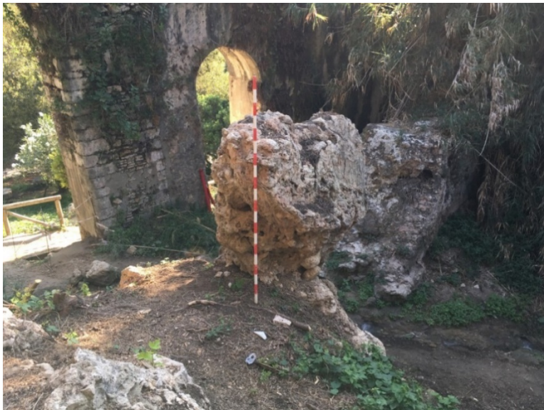
Figura 11. Estructura hidráulica inédita documentada paralela al acueducto de Santa Lucía
