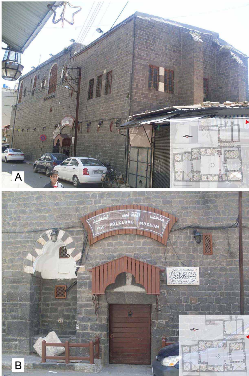
Fig 3. La demeure al-Zahrāwī : A. La façade nord extérieure donnant sur la rue ‘Ūmar al-Mūhtar ; B. L’entrée de la partie principale condamnée (à gauche) et de la seconde partie actuelle (I. Fayyad).
