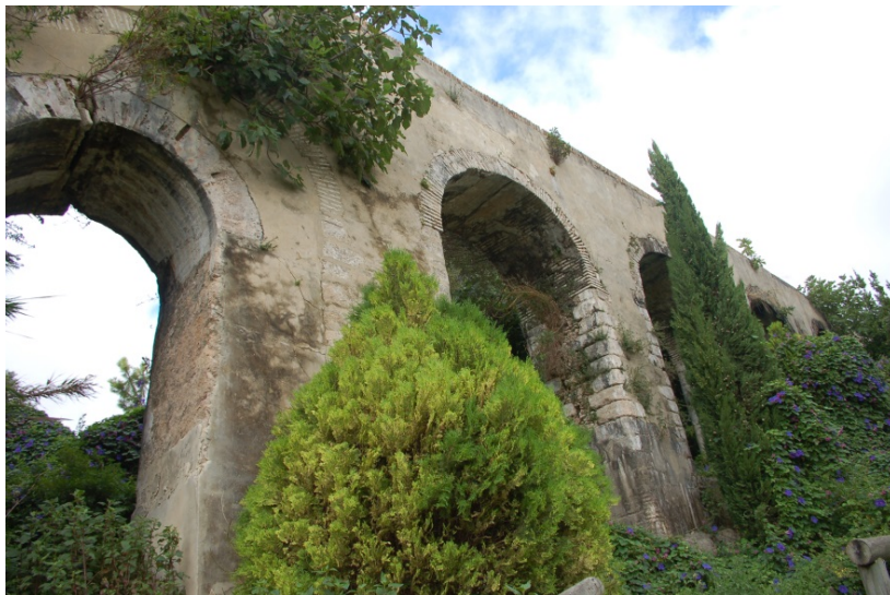
Figura 2. Vista parcial del acueducto de Santa Lucía
