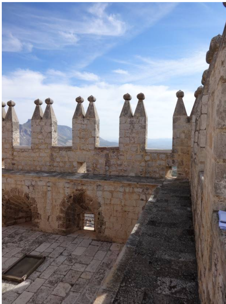
Lámina 8. Remate de la torre del Homenaje del Castillo de Vélez Blanco, Almería. Alto farsante provisto de troneras de artillería y un paso cubierto superior. Configuración similar a la prevista para el Castillo Cristiano. © DGO.
