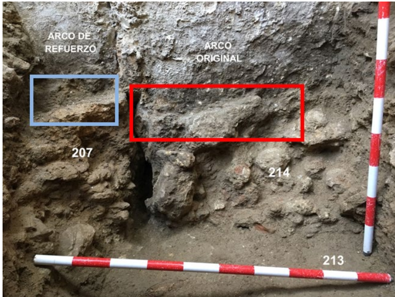
Figura 10. Detalle de la cimentación del arco original y del arco de refuerzo
